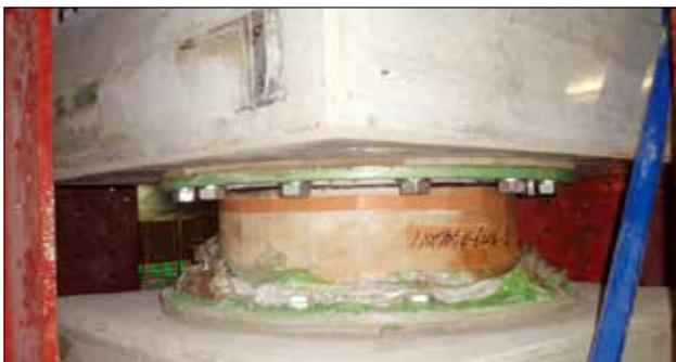
④免震装置設置完了
