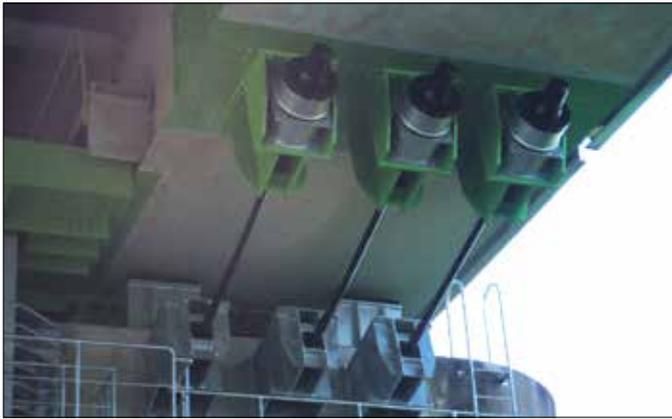
PC ケーブルによる落橋防止装置
