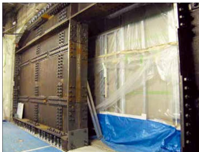
室内開口部補強鋼板設置
