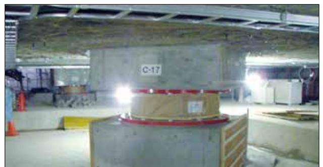
④免震装置設置完了
