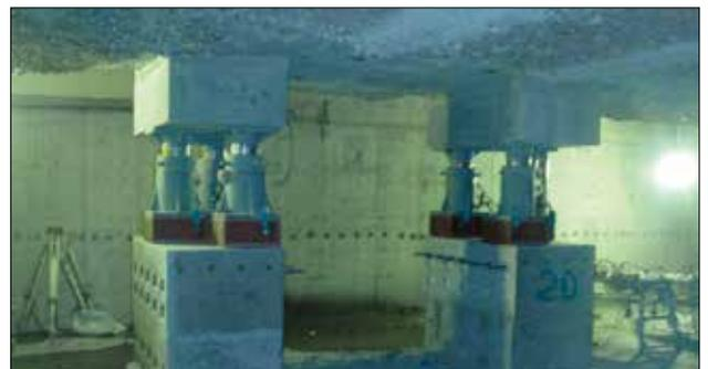
③既存杭切断撤去完了（仮受ジャッキ受替え完了）
