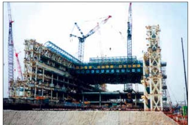
タービン棟鉄骨建方（多機能式ステージ工法）
