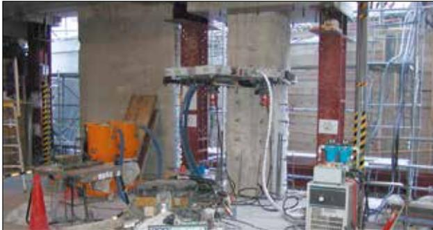
②無水式ワイヤーソーによるRC柱切断
