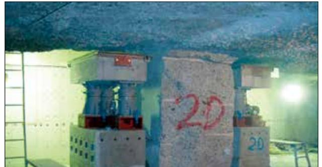
②既存杭部分切断撤去完了並びに仮受ジャッキセット
