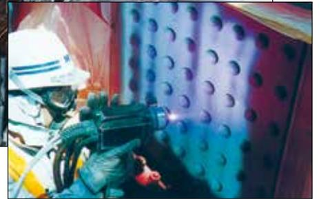
垂鉛・アルミ溶射（補剛桁の添接部）
