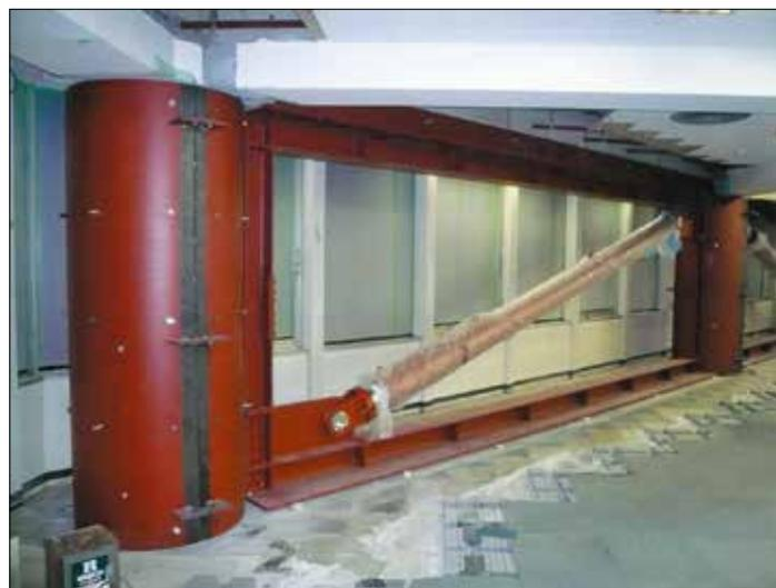
内部鉄骨補強フレーム並びにダンパー設置
