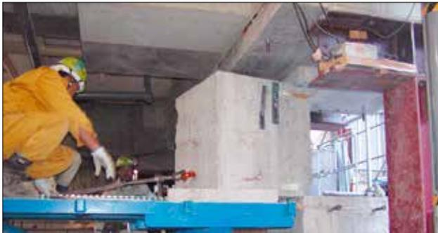
③既設 RC 柱切断部撤去
