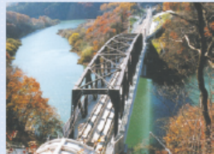
●第1北上川橋りょう / 日本鉄道建設公団(岩手県) No.Kitakami-Gawa Bridge / Japan Railway Construction Public Corp. (Iwate Pref.)
