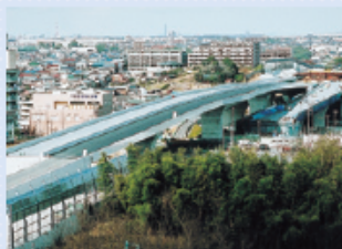
●有松高架橋 / 中部地方整備局(愛知県) Arimatsu Viaduct / Chubu Regional Bureau (Aichi Pref.)
