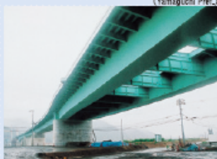
●新四方十川橋 / 四国地方整備局(高知県) Shin-Shimoda Bridge / Shikoku Regional Development Bureau (Kochi Pref.)
