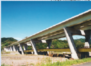
●荒科川橋 / 日本道路公団(静岡県) Warashina-Gawa Bridge / Japan Highway Public Corporation (Shizuoka Pref.)
