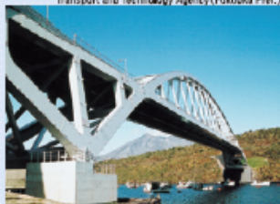
●牛根大橋 / 九州地方整備局(鹿児島県) Ushine Bridge / Kyusyu Regional Development Bureau (Kagoshima Pref.)
