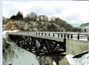
●戸田4号橋 / 秋田県 Toga No.4 Bridge / Akita Pref.
