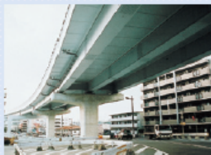
●片江高架橋 / 福岡北九州高速道路公社(福岡県) Katate Viaduct / Fukuoka-KitaKyushu Expressway Public Corp. (Fukuoka Pref.)
