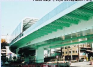
●板橋相生陸橋 / 東京都 Izabashi Aoi Overpass / Tokyo Metropolitan Pref.
