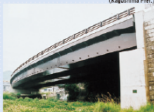
●坊津2号橋 / 鹿児島県 Bounatsu No.2 Bridge / Kagoshima Pref.
