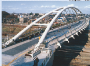
●大宮ほこすぎ橋 / 東日本旅客鉄道(株) (埼玉県) Omiya Hokusugi Bridge / East Japan Railway Company (Saitama Pref.)
