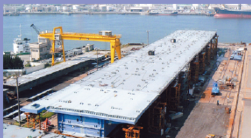
● 工場敷地内仮組立作業 Shop Assembly Works
