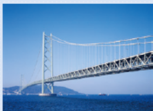
●明石海峡大橋 / 本州四国連絡橋公社(兵庫県) Akashi-Kaikyo Bridge / Hanshu-Shikoku Bridge Authority (Hyogo Pref.)
