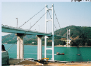
●豊島大橋 / 広島県道路公社(広島県) Toyoshima Bridge / Hiroshima Pref. Road Public Corp. (Hiroshima Pref.)
