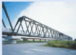
●石狩川橋りょう / 北海道旅客鉄道(株) (北海道) Shikari-Gawa Bridge / Hokkaido Railway Company (Hokkaido)
