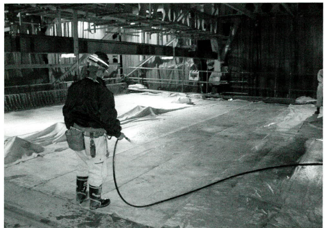
写真-2 床版上面の養生（散水状況）
