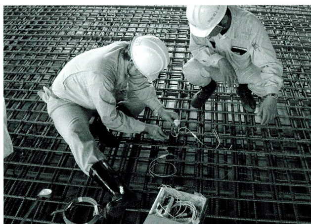
写真-4 計測機器の設置状況写真
