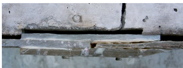
写真－7 繊維層間のせん断破壊状況
