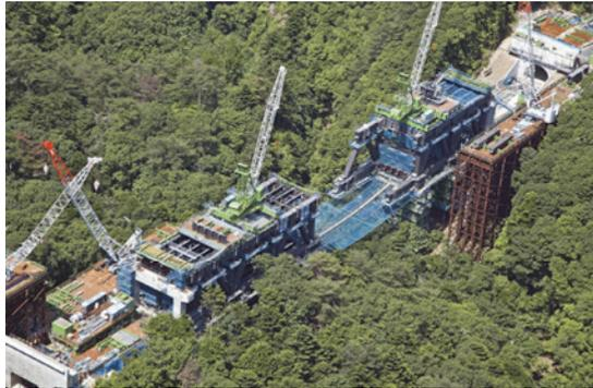
写真-13 トラベラークレーン張出し架設状況
