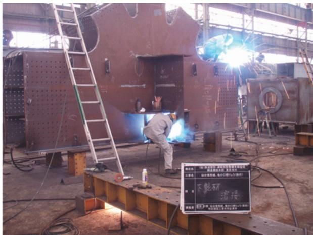
写真一七 部材溶接状況
