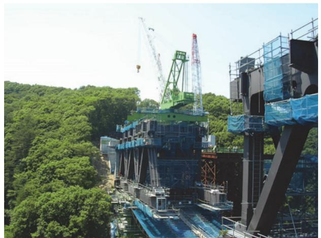
写真-11 トラベラクレーン張出し架設状況
