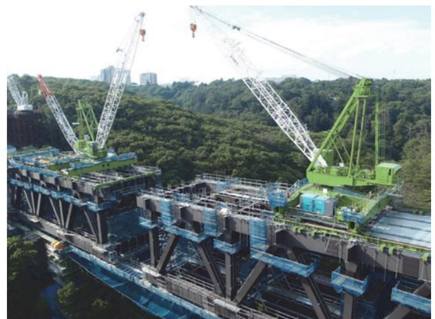
写真-12 トラベラクレーン張出し架設状況
