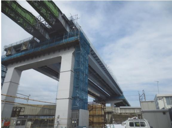
写真一八 上り線送り出し完了
