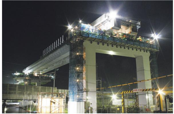
写真-6 下り線桁横取り状況
