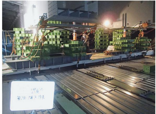
写真-7 桁降下状況
