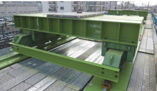
写真-3 従上台車スライド設備（ステンレス板）
