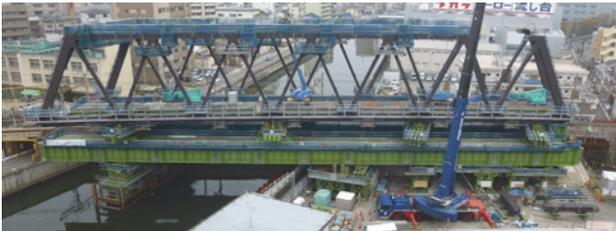
写真-7 後方トラス桁組立
