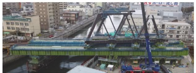
写真-5 前方トラス桁組立
