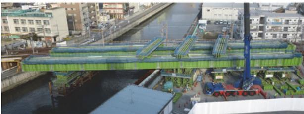
写真-2 送出し工事桁設備全景
