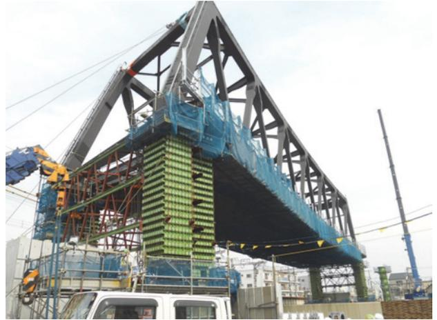
写真-9 ジャッキダウン設備全景
