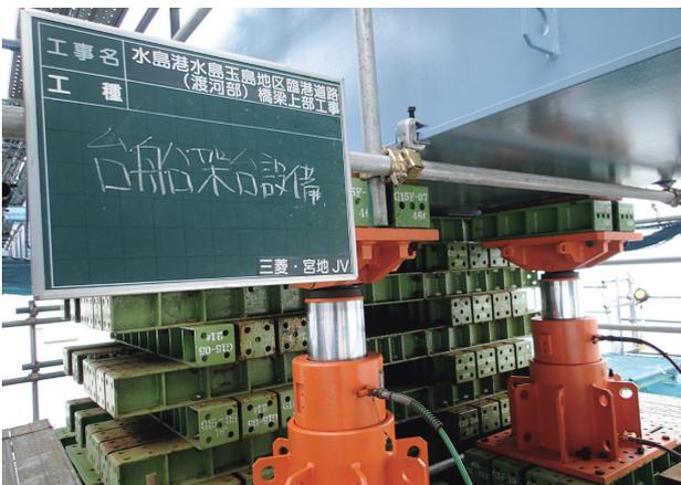
写真-5 台船架台設備（200t-400STジャッキ）
