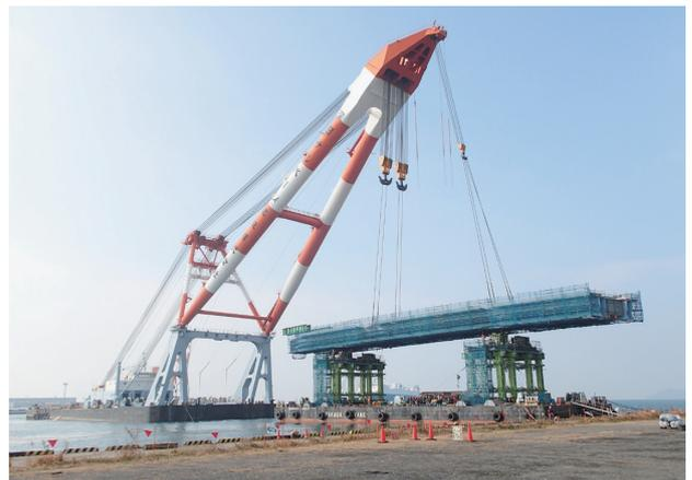
写真-3 2000t吊FC「金剛」による浜出し
