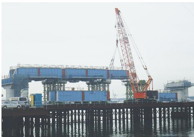
写真-1 クレーン架設
