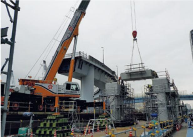
写真一五 梁部架設状況
