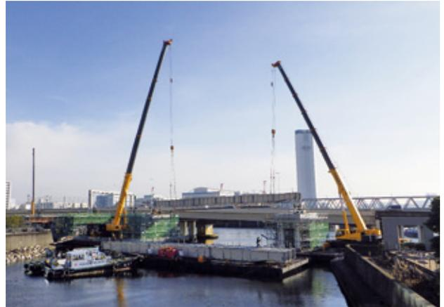
写真-10 相吊り架設状況
