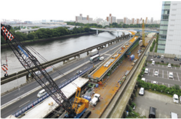
写真-3 横取り完了
