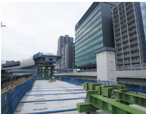
写真-17 大ブロック架設完了
