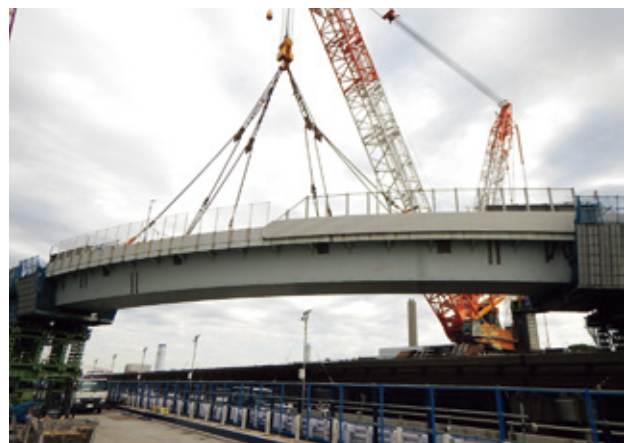
写真-7 大ブロック撤去1日目完了（陸側）
