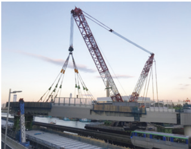
写真-16 架設1日目完了
