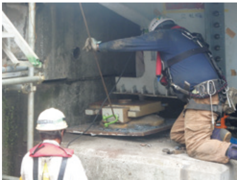
写真-2 支承撤去
