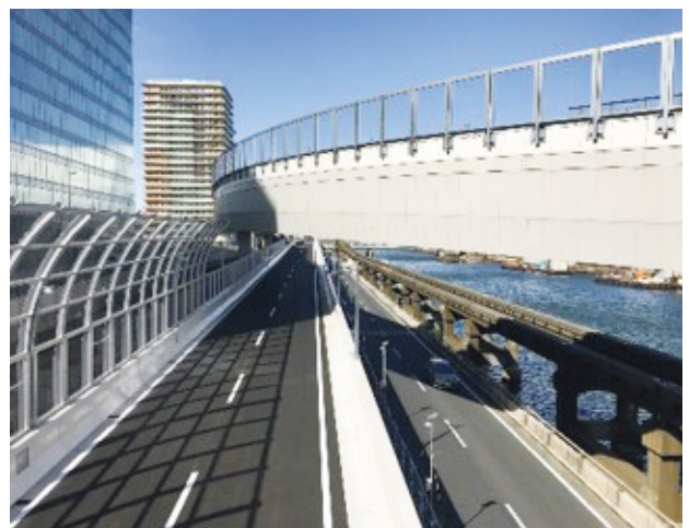
写真-19 八潮連結路全景
