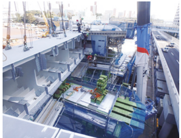
写真-18 閉合桁架設
