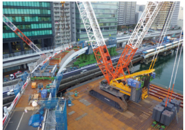
写真-6 大ブロック撤去1日目完了（海側）
