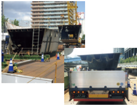
写真-4 鋼桁切断・搬出
