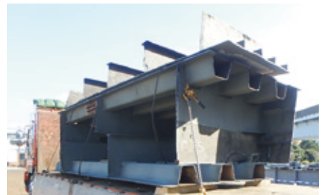
写真-9 鋼桁撤去
