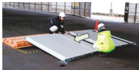
b) 渡し板の設置
