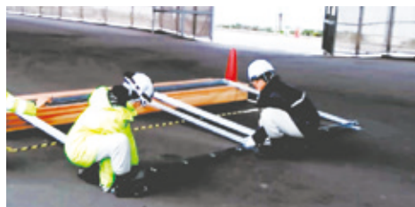
a) 鋼製フレームの組立
