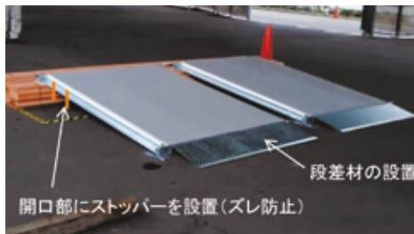
c) 段差材、ストッパーの設置
