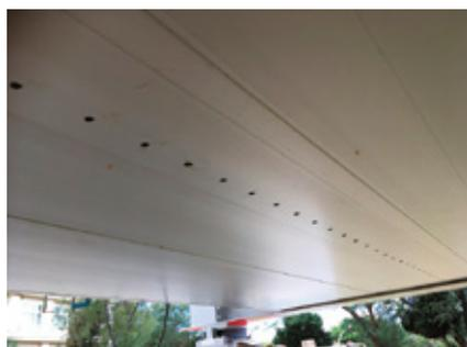
写真-3 計測孔 (デッキ下面)
