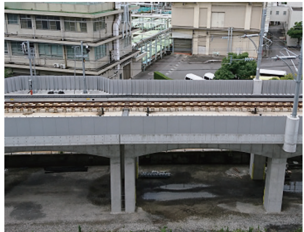
写真-1 鉄道用壁高欄への適用例
