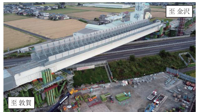
写真－17 送出し2回目完了
