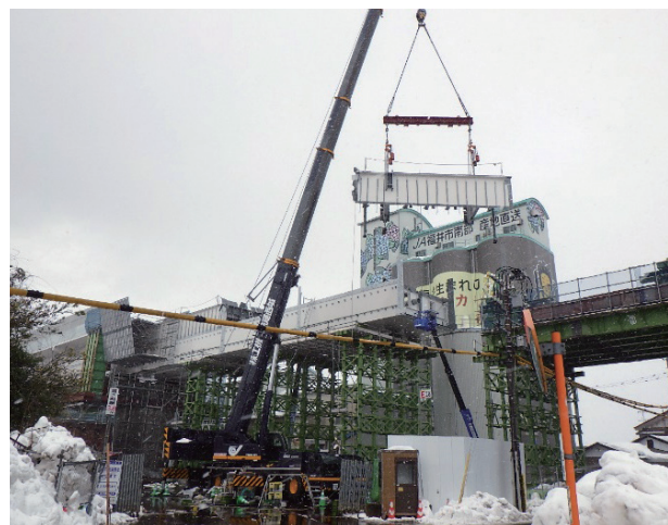
写真-20 側径間架設状況
