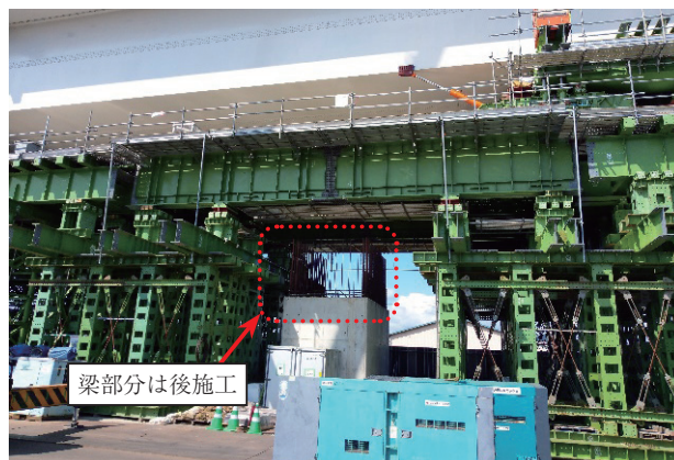
写真-5 橋脚渡り部
