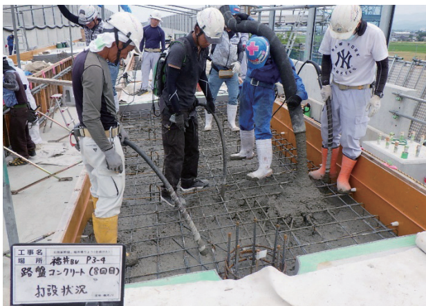
写真-26 路盤コンクリート施工状況
