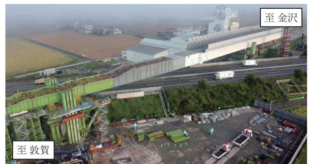
写真－16 送出し1回目完了
