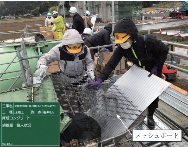
写真-23 鋼繊維投入状況
