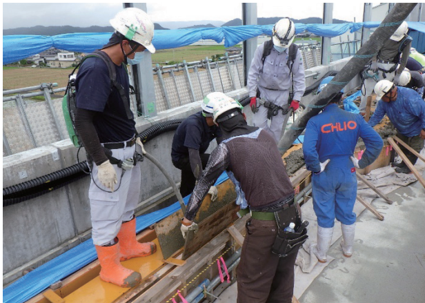
写真-25 ダクトコンクリート打込み状況
