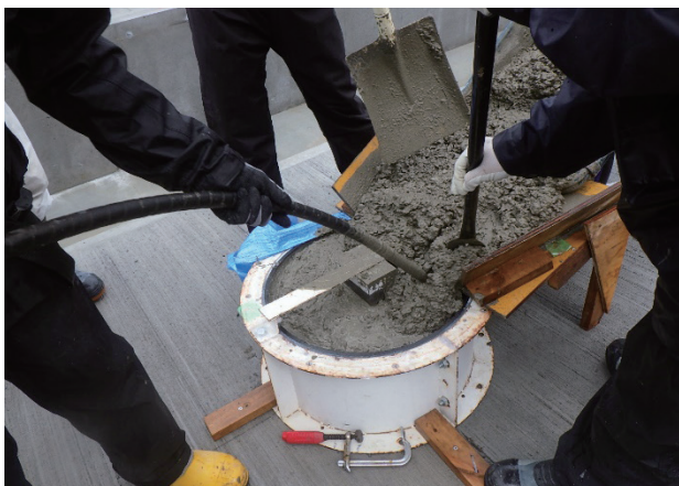
写真-27 突起コンクリート打込み状況
