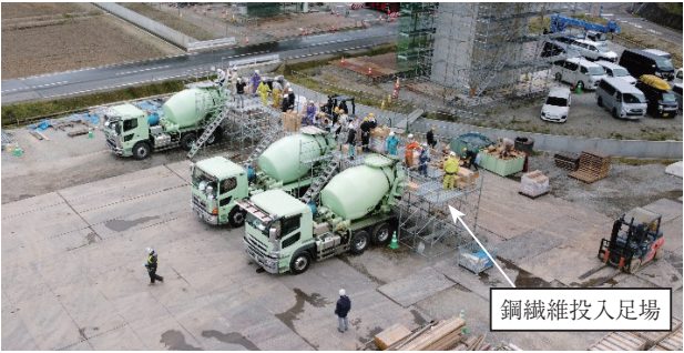
写真-22 鋼繊維投入足場
