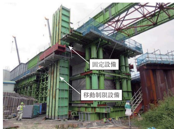
写真-1 橋脚部移動制限設備
