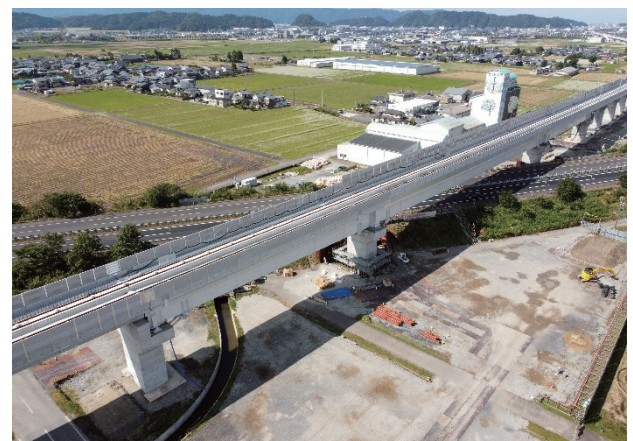
写真-29 福井Bv（完成）
