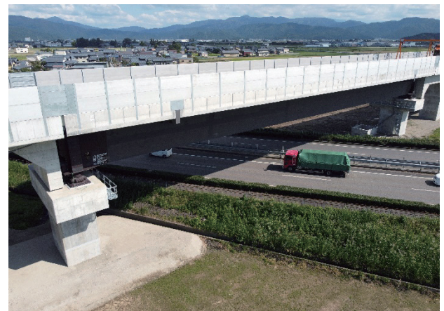
写真-28 第2下筋生田Bv（完成）
