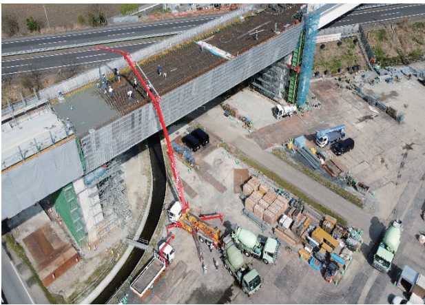
写真-21 床版コンクリート打込み状況
