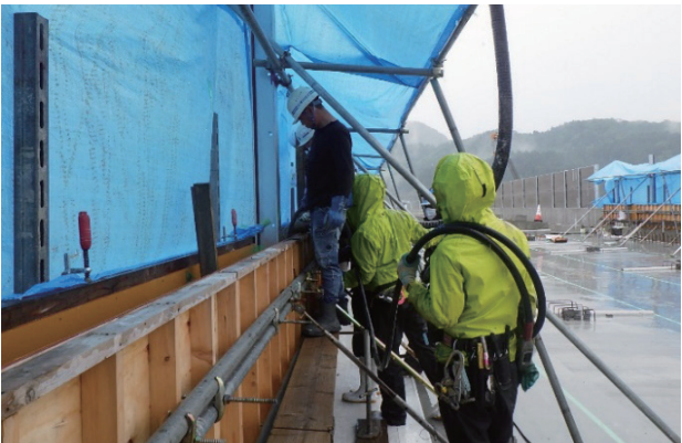
写真-24 防音壁コンクリート打込み状況
