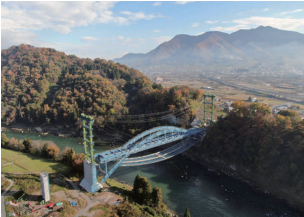
図-11 ケブルクレーン架設完了
