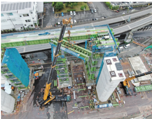
写真-13 軌条架設状況②
