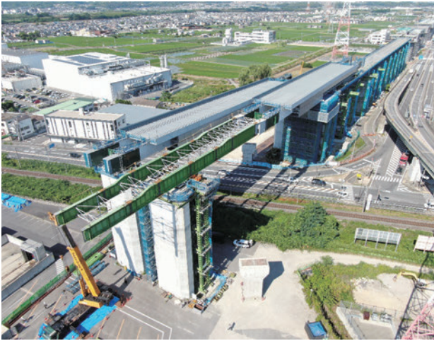
写真-3 下り線架設後、上り線送り出し状況
