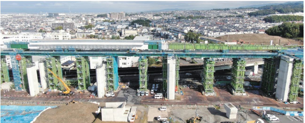
写真-2 下り線 送り出し桁組立完了
