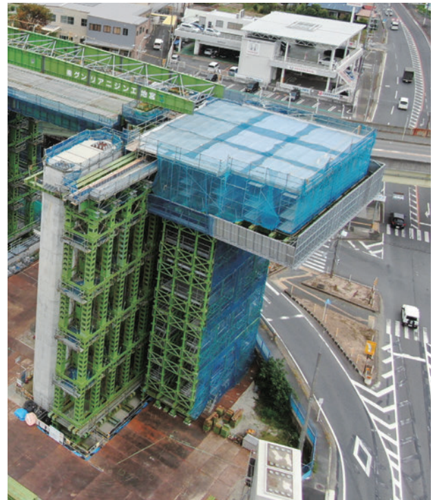
写真-4 常設足場設置用構台設備
