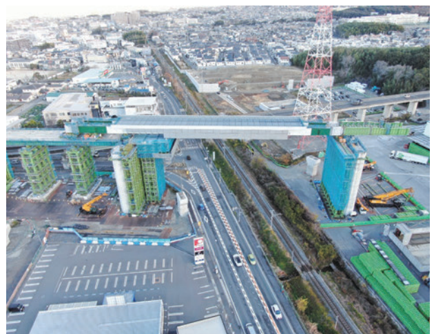
写真-9 第12回送り出し架設完了
