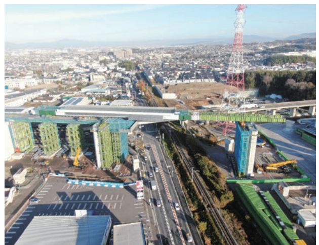
写真-8 第8回送り出し架設完了
