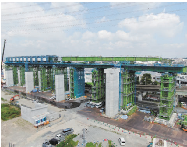
写真-11 手延機縦取り後、主桁組立状況
