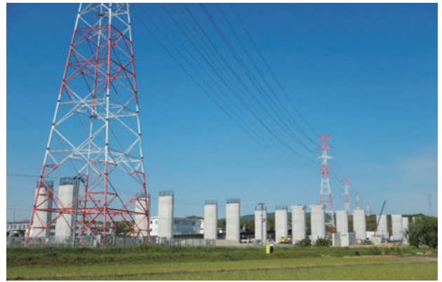
写真-1 着工前 施工ヤード全景
