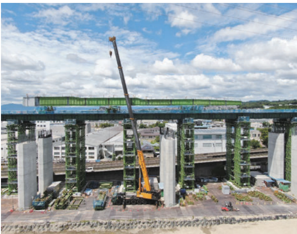
写真-10 手延機組立状況
