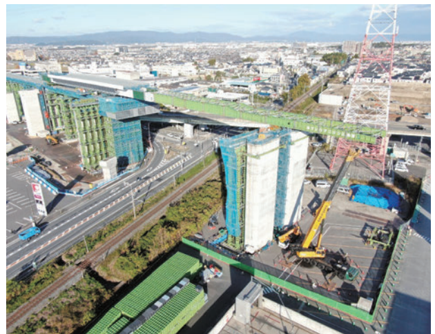
写真-7 第4回送り出し架設完了
