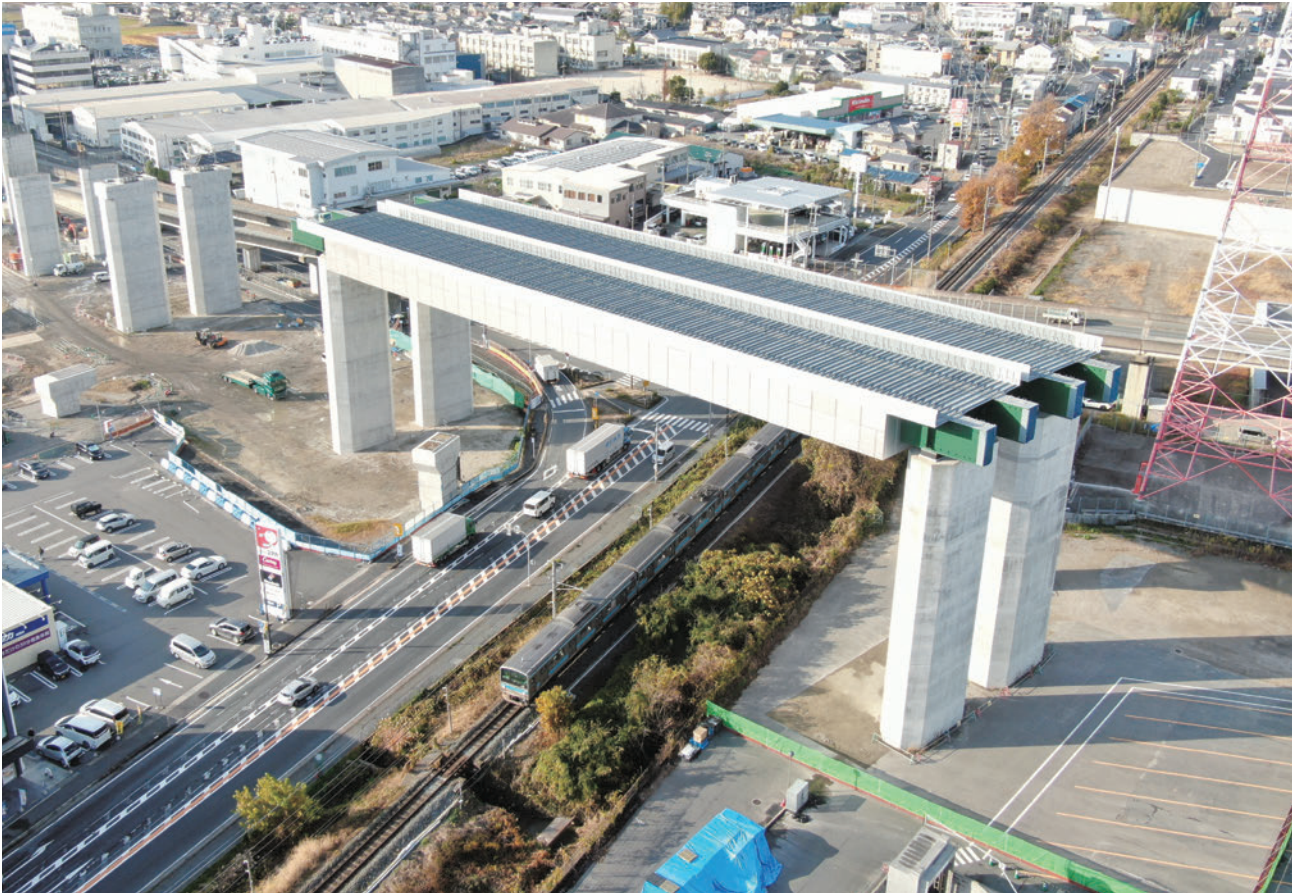
写真-14 工事完了写真
