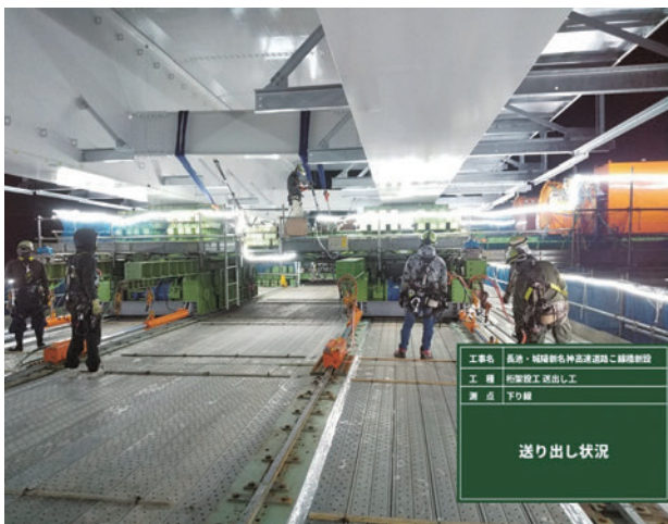
写真-6 送り出し架設作業状況
