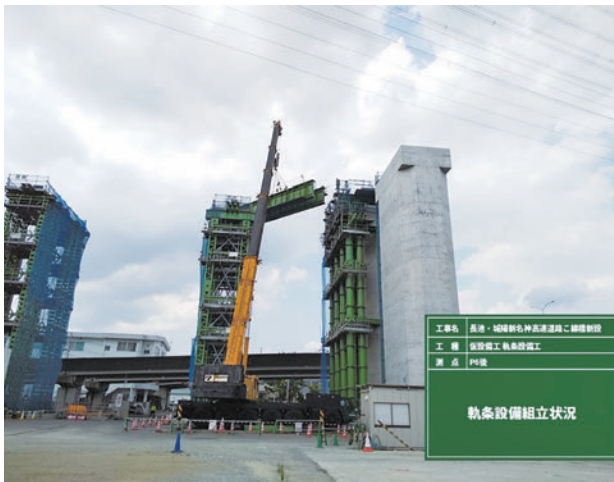
写真-12 軌条架設桁架設状況①
