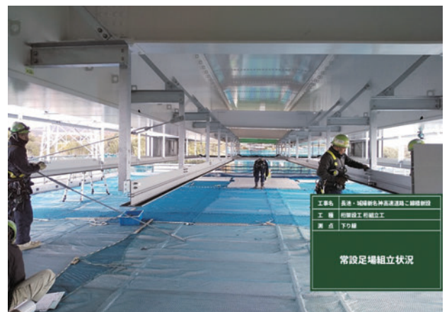
写真-5 常設足場組立状況備
