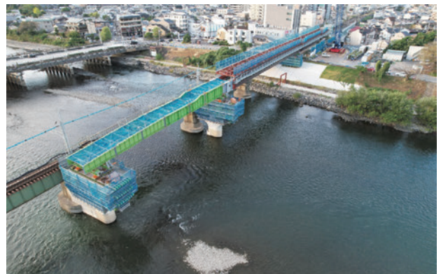
写真-14 第3回送出し (P2到達) 下流から臨む
