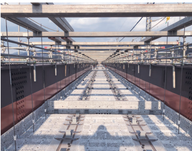
写真-24 埋設型枠設置完了
