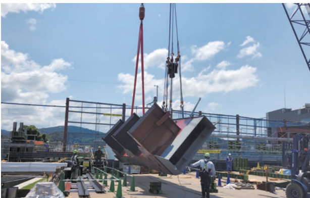
写真-11 主桁建て起こし②
