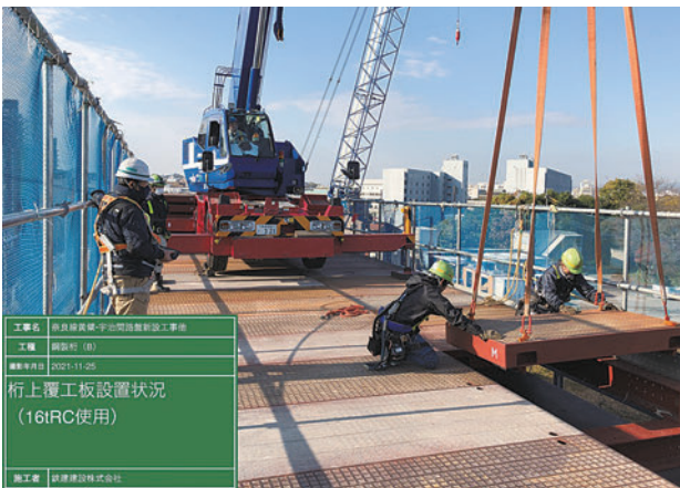
写真-20 桁上栈橋覆工板敷設
