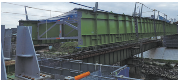
写真-17 P1到達前手延機先端
