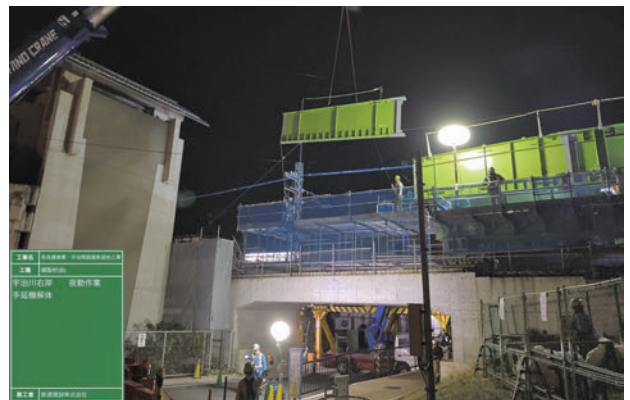
写真-19 手延機解体状況
