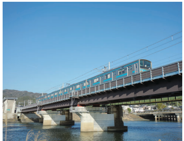
写真-26 完成開通写真（左岸から臨む）
