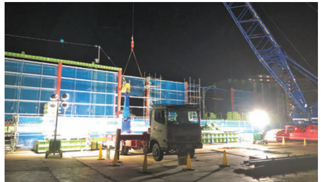
写真-8 線路防護設備設置況
