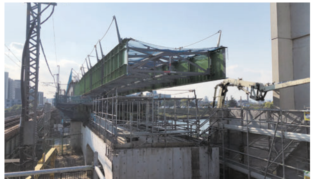
写真-18 手延機先端張出し状況
