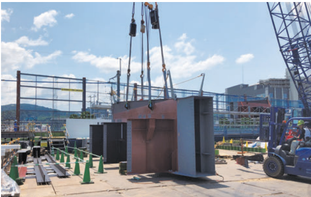
写真-12 主桁建て起こし③
