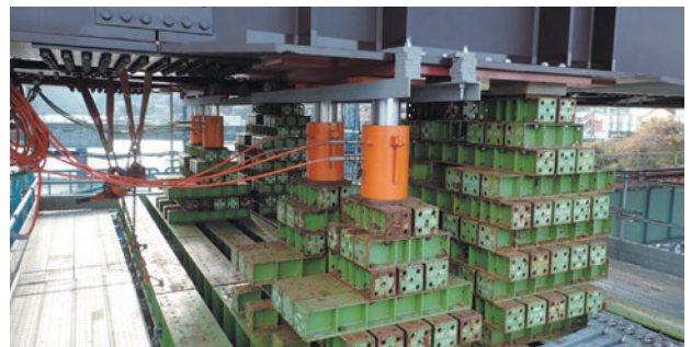
写真-22 吊り下げ降下ジャッキ
