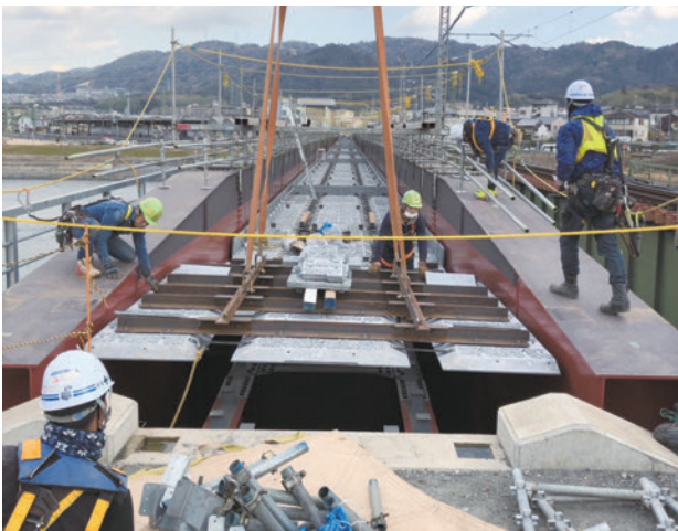
写真-23 埋設型枠設置状況
