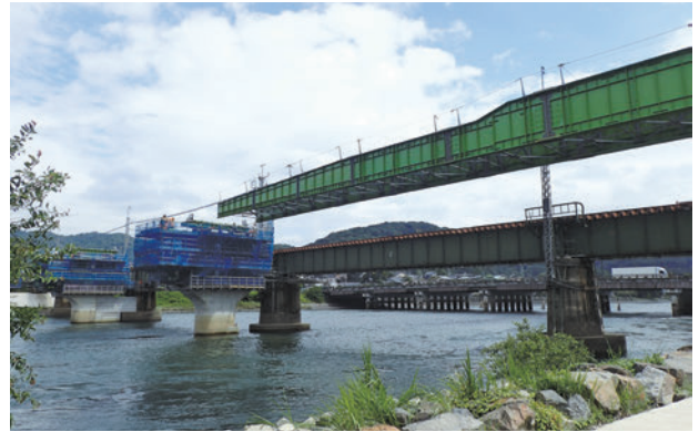
写真-13 第2回送出し (P1到達前) 左岸から臨む
