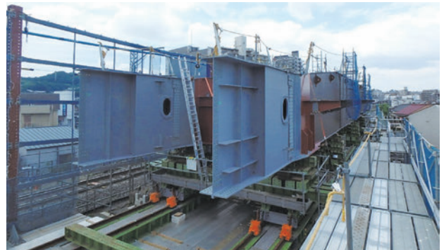
写真-9 主桁・連結構組立
