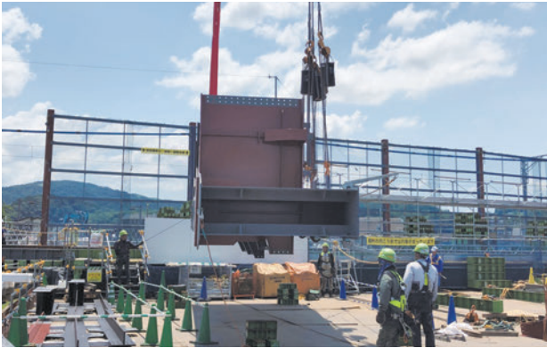
写真-10 主桁建て起こし①
