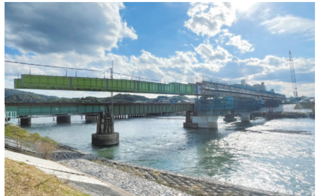
写真-15 第5回送出し (A2到達前) 右岸から臨む
