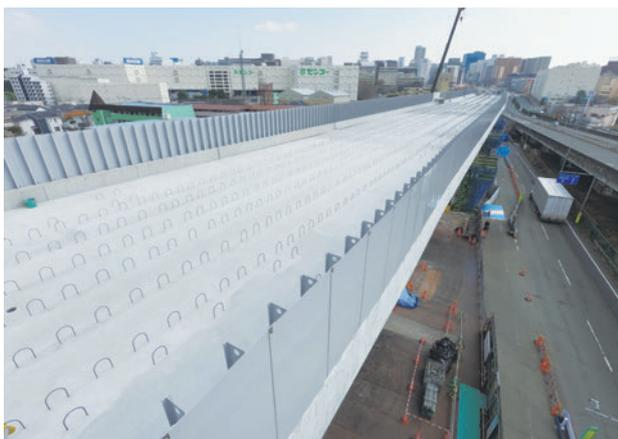
写真-45 FRP壁高欄設置完了
