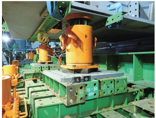
写真-30 降下量計測用エンコーダ設置
