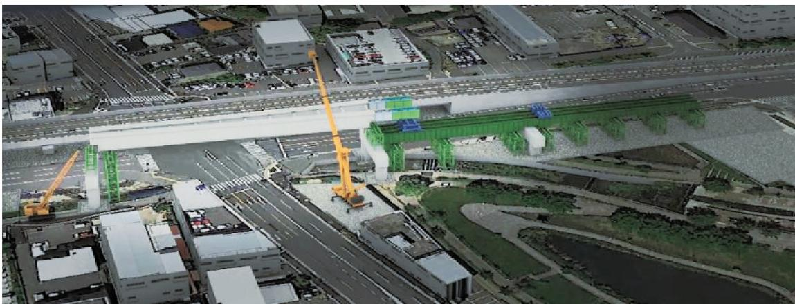
図-9 送出し→桁降下3Dイメージ
