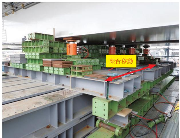
写真-18 仮受け架台移動装置 (自走台車)
