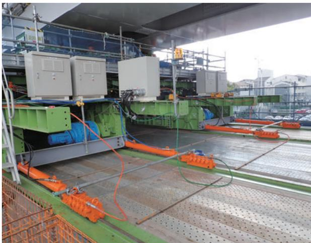
写真-19 水平ジャッキ設備
