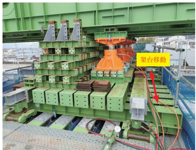
写真-17 仮受け架台移動装置 (P13橋脚ベント)
