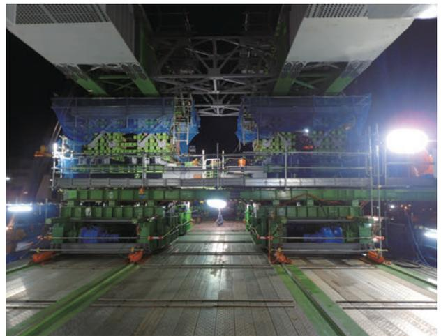
写真-21 台車主桁固定状況
