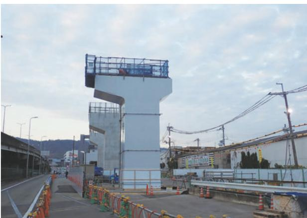
写真-34 P8橋脚架設完了
