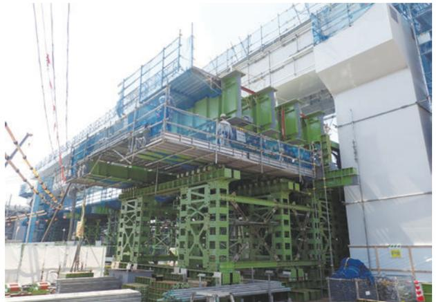
写真-36 DG1工事桁解体状況
