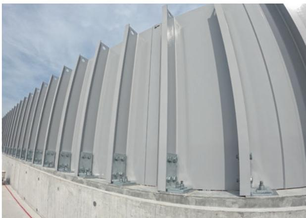
写真-46 FRP壁高欄設置完了
