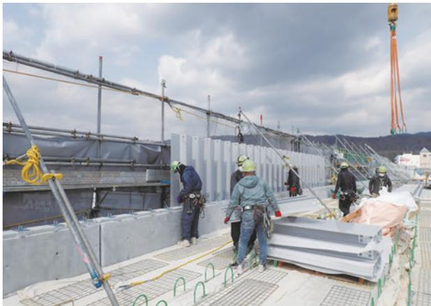
写真-44 FRP壁高欄設置状況
