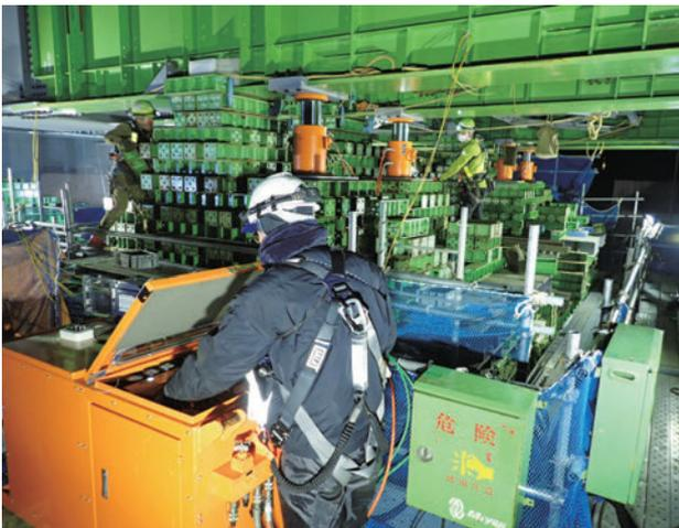
写真-27 桁降下状況
