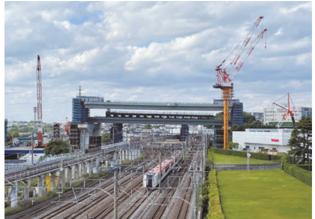
写真-11 桁降下前
