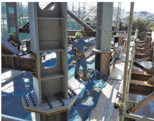
写真-3 支柱組立状況
