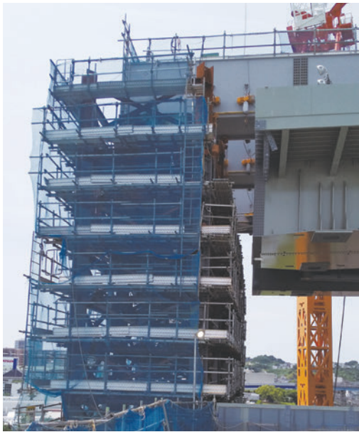
写真-7 桁降下前
