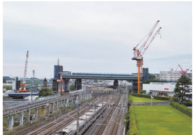
写真-12 桁降下完了
