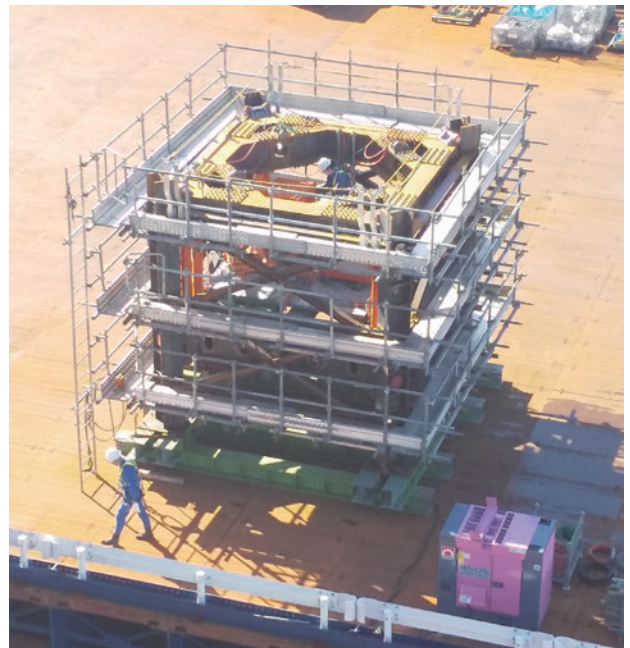
写真-1 試験施工
