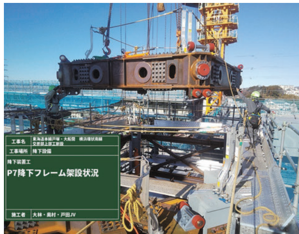
写真-5 降下フレーム組立状況
