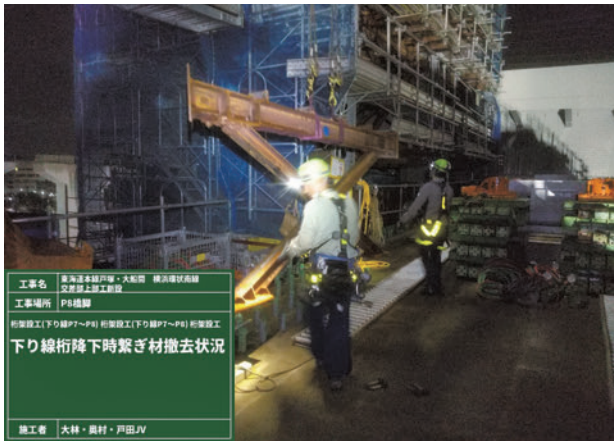
写真-10 繋ぎ材撤去状況
