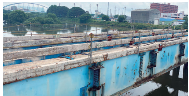
図-11 合成鉄桁床版撤去完了状況
