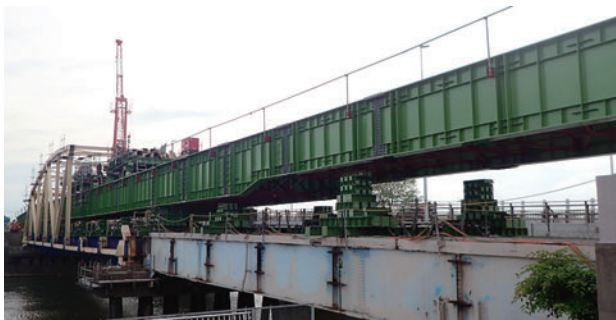
図-3 架設桁設置状況
