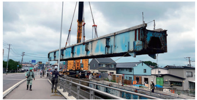
図-5 鉸桁部撤去要領図
