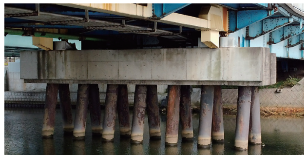
図-6 P1橋脚現況
