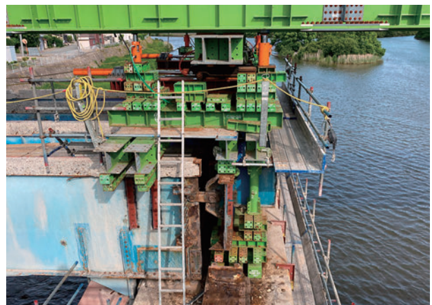
図-9 P1橋脚上設備組立状況
