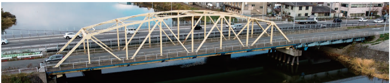
図-2 旧新川橋撤去前
