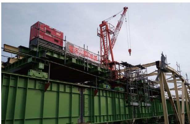
図-4 クレーン台車設置状況
