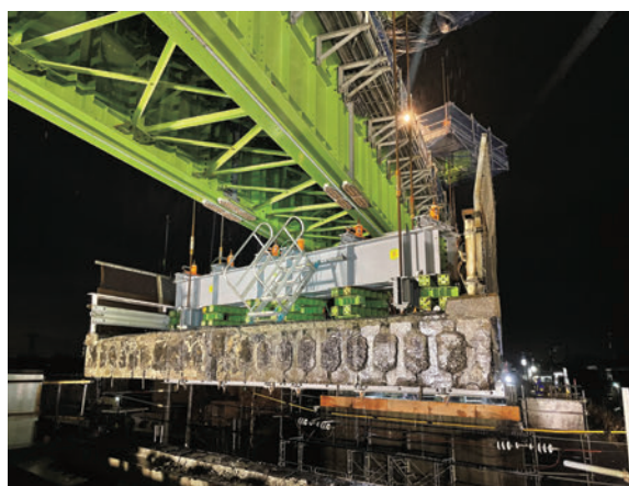
写真-11 吊上状況
