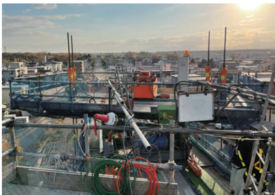
写真-8 吊上台車ジャッキ部
