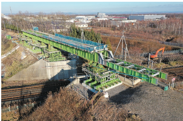
写真-6 架設桁送り出し状況
