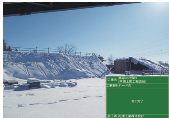
写真-16 上部工撤去完了
