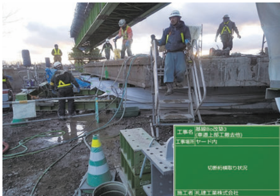
写真-14 桁横取り状況
