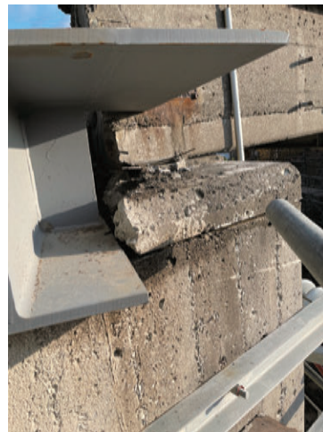
写真-4 桁座縁切り状況
