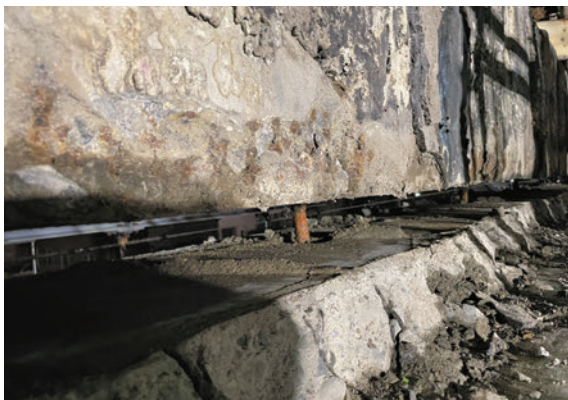
写真-9 支点部縁切り状況
