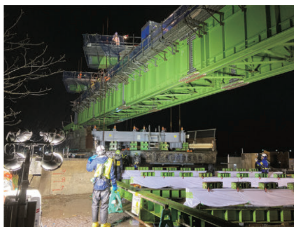
写真-10 吊上状況
