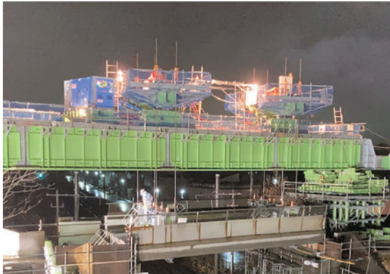
写真-7 架設桁上吊上台車
