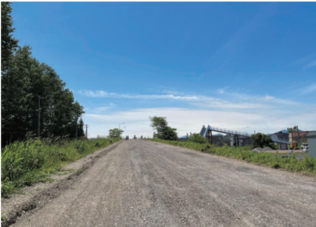
写真-1 上り線側ヤード造成後
