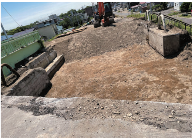
写真-2 下り線側ヤード造成後
