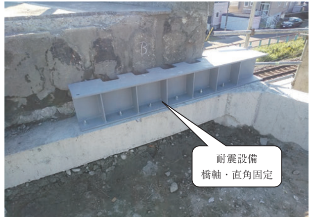
写真-3 耐震設備設置状況
