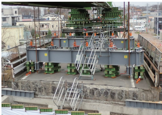
写真-5 桁吊り天秤設置状況
