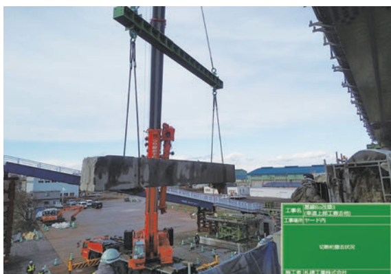
写真-15 桁分割撤去状況
