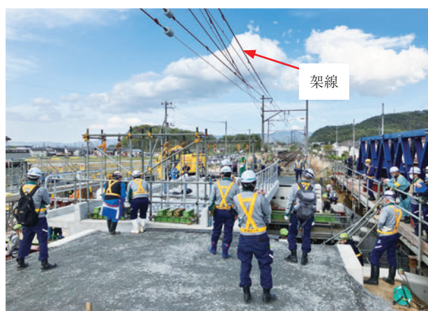
写真-5 桁横取り架設完了後
