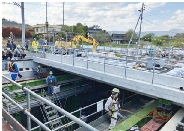
写真-4 桁横取り前
