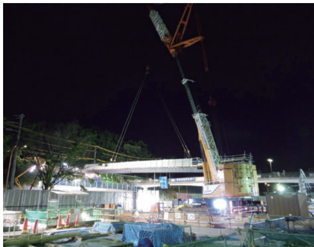
写真-1 従来玉掛架設状況
