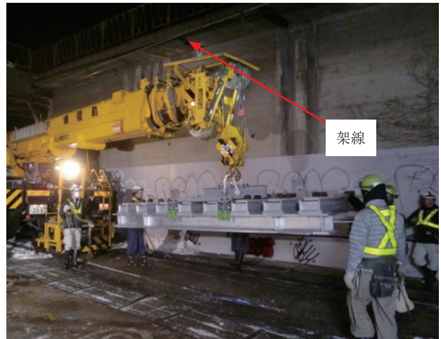
写真-7 玉掛けワイヤーを省略した天秤架設状況
