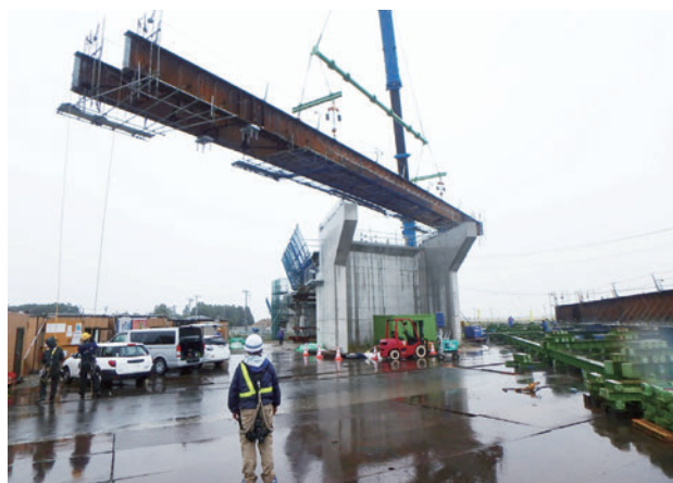
写真-2 吊天秤使用時架設状況
