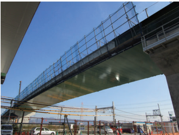
写真-2 架設完了
