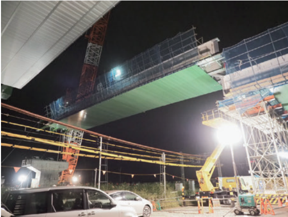
写真-1 一括架設状況（FRP防護板底板設置）
