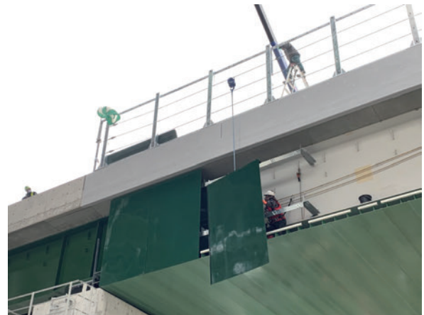
写真-3 4tクレーン付トラックでのFRP防護板側板設置
