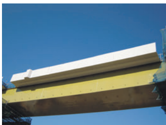
久喜白岡Fランプ (一括架設への適用) (NEXCO東日本 平成24年度竣工)
