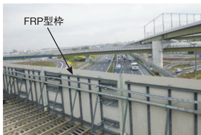
久喜白岡ランプ（高速道路本線上への適用） (NEXCO東日本 平成24年度竣工)
