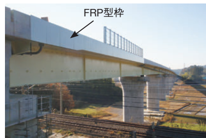
大網白里高架橋（JR上送り出し架設への適用） (NEXCO東日本 平成23年度竣工)
