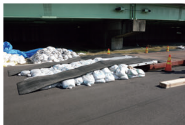
軽量土嚢によるスロープ構築
