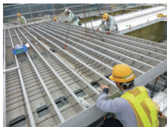
桶川インターCランプ (関東地方整備局 平成25年度竣工)
