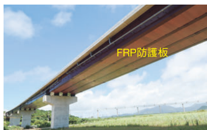
FRP防護板 下田原大橋 (沖縄県 令和2年度竣工)
