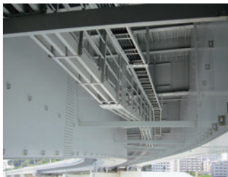
泊大橋上部工検査路 (沖縄総合事務局 平成22~24年度竣工)
