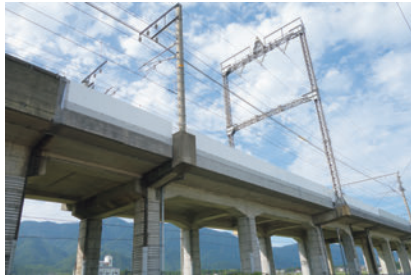
JR湖西線におけるFRP製壁高欄設置状況 (西日本旅客鉄道)
