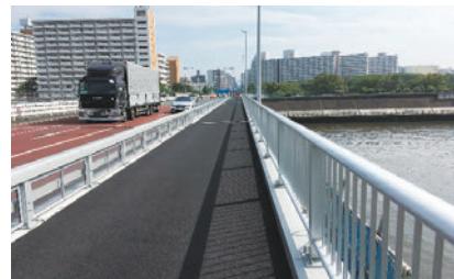
平井大橋 (中川部) (東京都 令和元年度竣工)
