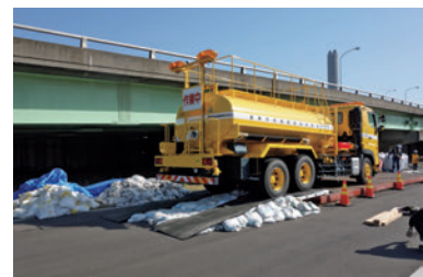
F-Deckにより通行可能
