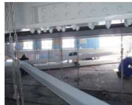
桁下足場上での移動
