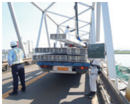
検査路の荷卸し (ユニック車)
