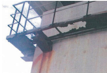
鋼製検査路の腐食による損傷の例
