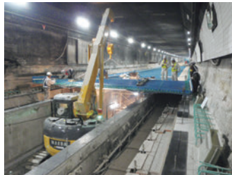
関門トンネル (床版打替え工事) (NEXCO西日本 平成22年度竣工)
