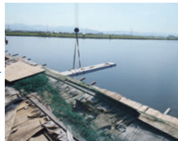
桁下の足場への取込み
