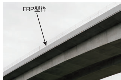
高倉川橋（PC上部工の埋設型枠への適用） (NEXCO東日本 令和2年度施工中)
