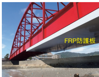
FRP防護板 鹿島大橋補修工事 (愛知県 平成28年度竣工)
