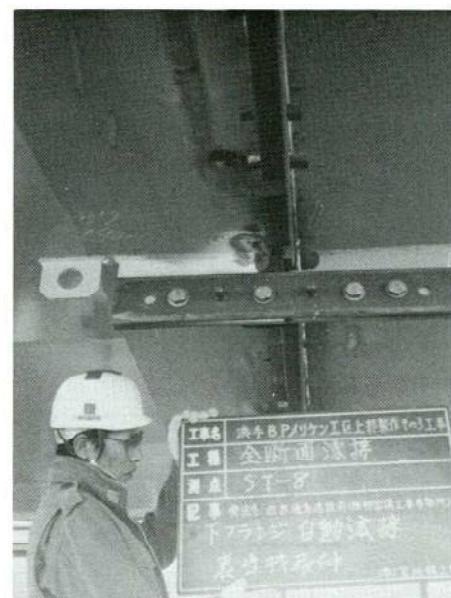
写真-5. 下フランジ裏当材取付状況
