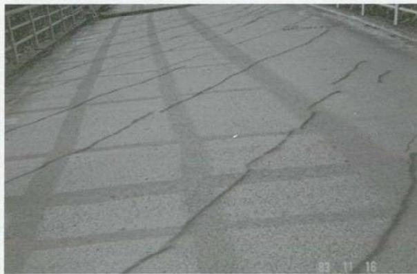
写真-3. 床版の亀裂状況
