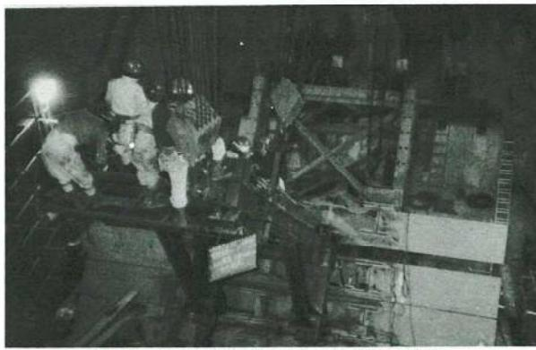
写真-12 手巻ウインチによる落込み状況
