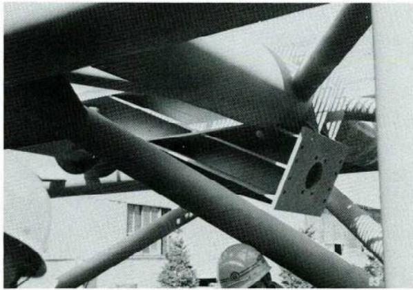
写真-1. 主桁側ケーブル定着部（側面）
