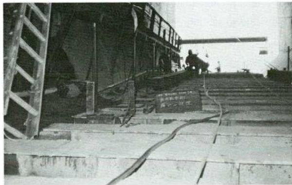
写真-1 坑内軌条梁落とし込み状況
