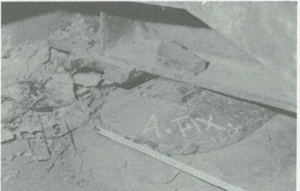
写真-9. AI橋台、固定沓(A桁)の破損状況
