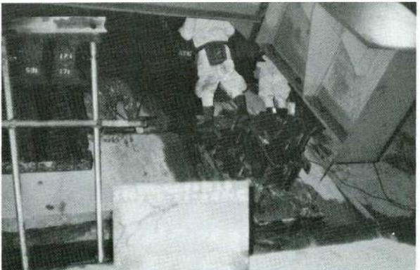
写真-6 回転柎ピン連結状況
