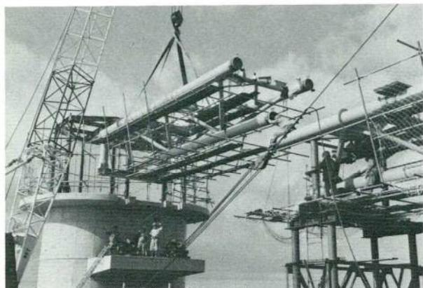
写真-5. 主構の架設
