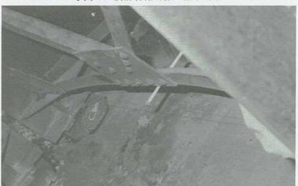
写真-8. 端対傾構の曲がり状況
