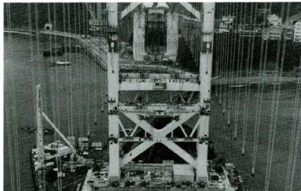
写真-4 端主横トラスの一括吊上げ架設
