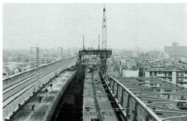
写真-5 通勤線桁降下
