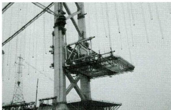
写真-5 中央径間塔付パネルの架設
