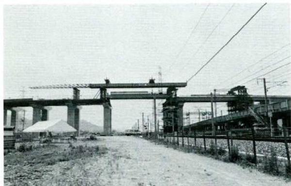
写真-4 3ブロック本桁吊込・引出し完了
