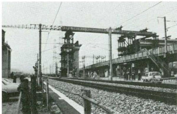
写真-2 第1回架設桁引出し完了
