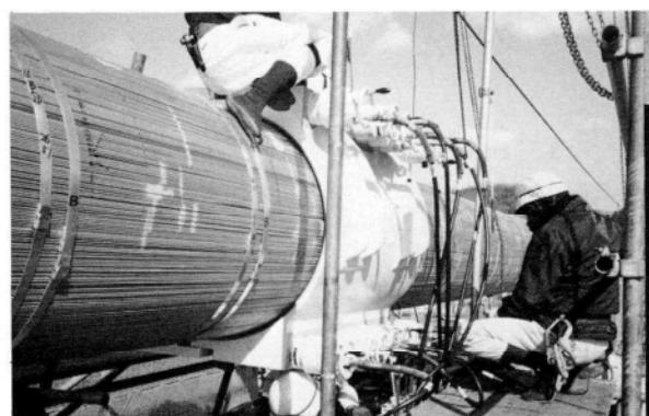
写真-14 ケーブルバンドボルト締付
