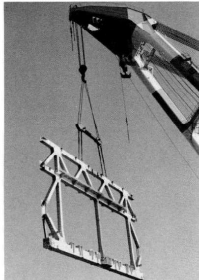
写真-2 床トラスの吊上状況
