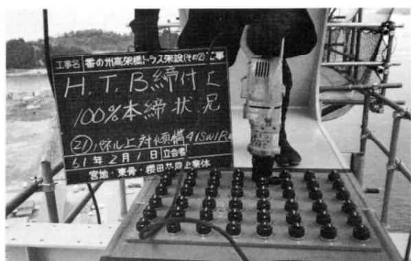
写真-3 本締め作業状況
