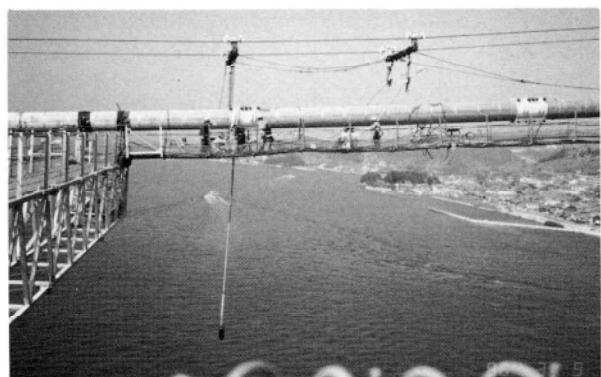
写真-15 ハンガーロープ架設
