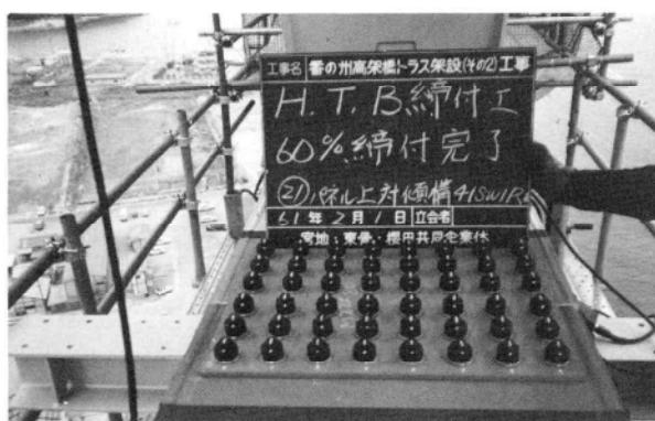
写真-2 1次締完了後のマーキング状況
