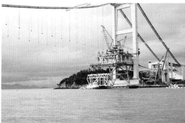
写真-9 3P前面に係留した台船
