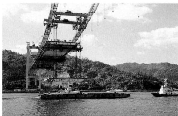
写真-3 捕剛桁の直下吊上げ
