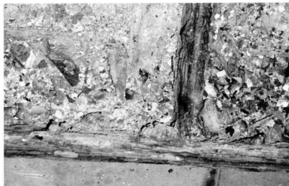
写真-7 補剛材下部とリベットヘッドの腐食状況
