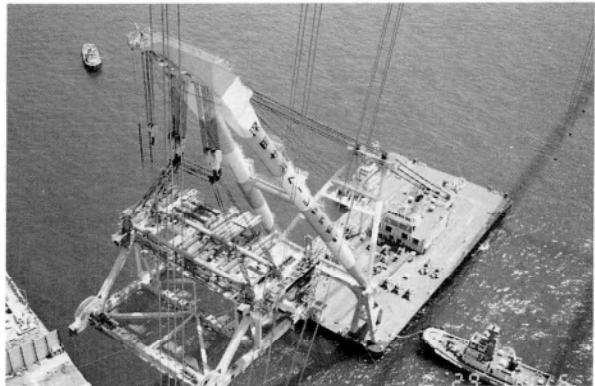
写真-4 2P塔付ブロック 2P前面に進入
