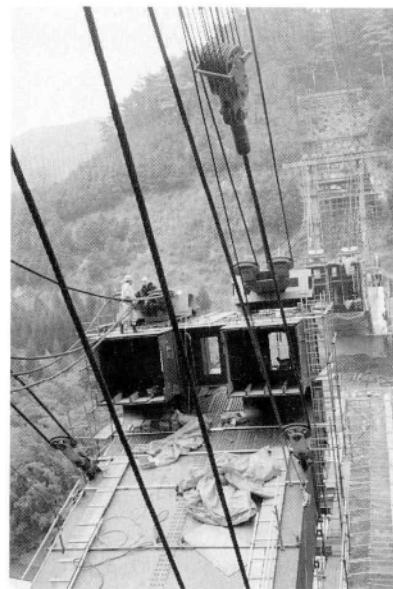
写真-3 第4橋隅角部断面の架設
