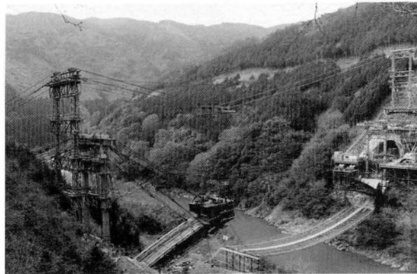
写真-4 第4橋のアーチの架設
