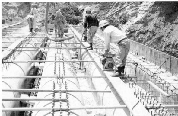
写真-8 コンクリートの充填
