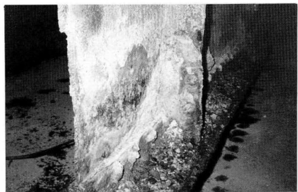
写真-2 撤去直後の桁の損傷状況
