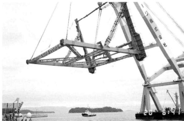
写真-3 2P塔付ベント・吊運搬して2P到着
