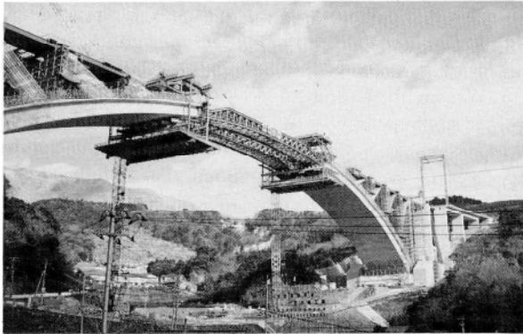
写真-11 A、Bライン共リフトアップ完了
