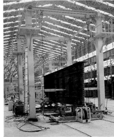
写真-12 全姿勢溶接反転装置での部材設置状況
