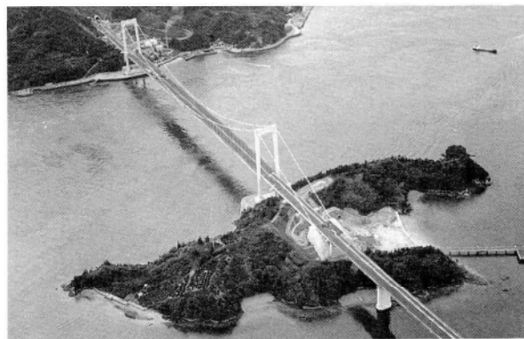
写-3 大島大橋全景
