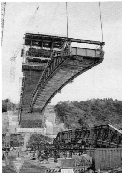
写真-8 Aライン、リフトアップ状況
