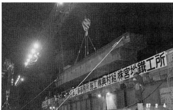
写真-2 軌条桁の設置
