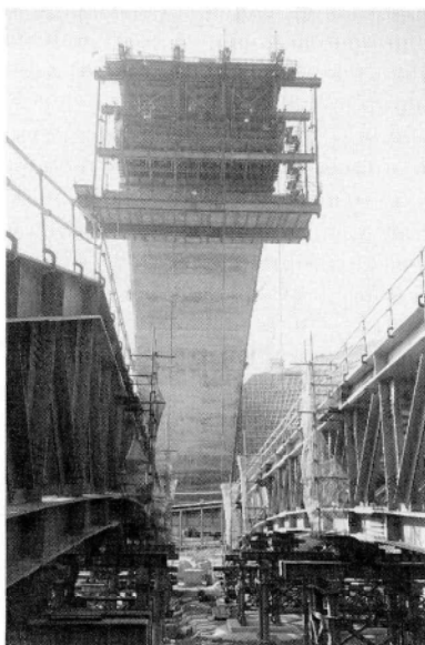
写真-6 リフトアップ設備全景
