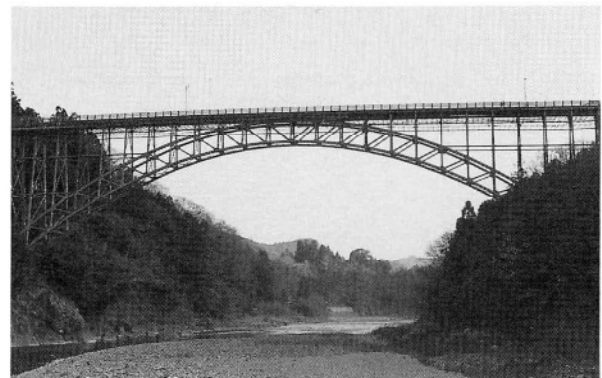
写真-1 奥多摩橋全景
