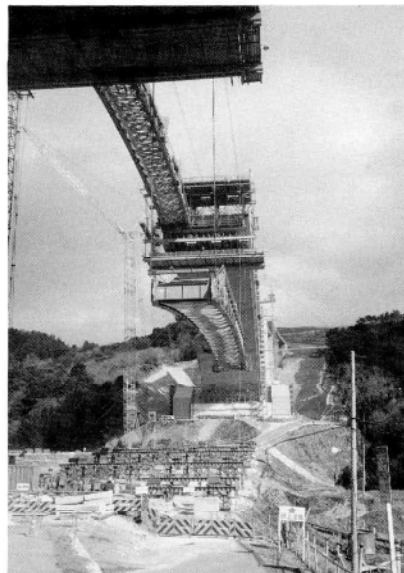
写真-10 Bラインリフトアップ状況
