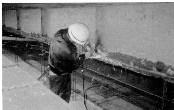
写真-5 直接サンダー作業状況
