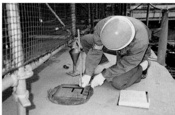
写真-3 移動量の測定状況
