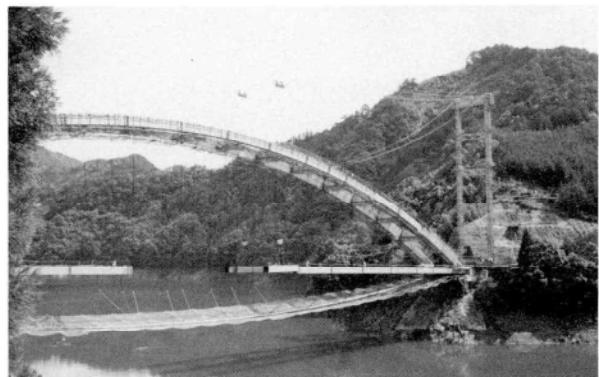
写真-6 下弦材・横桁の架設
