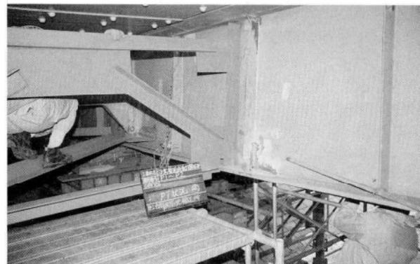
写真-4 横構・対傾構の新設
