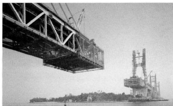
写真-1 長大吊橋の移動足場防護工
