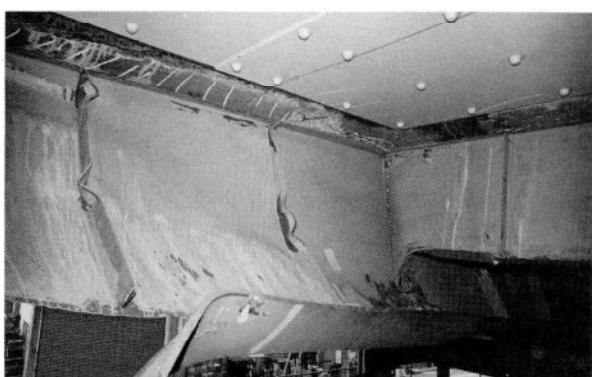
写真-2 GB桁下フランジ
