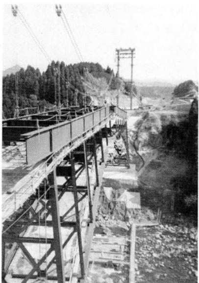
写真-2 アーチ材の架設(桁部分)
