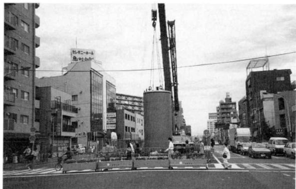
写真-2 脚柱の架設(昼間施工、4車線確保)
