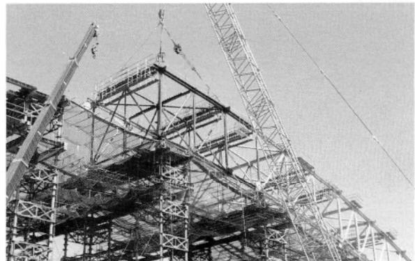
写真-4 トラス架設状況
