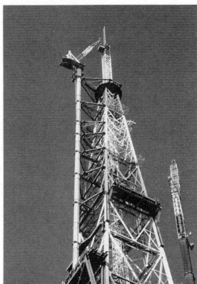
写真-3 ジブクレーン据付状況
