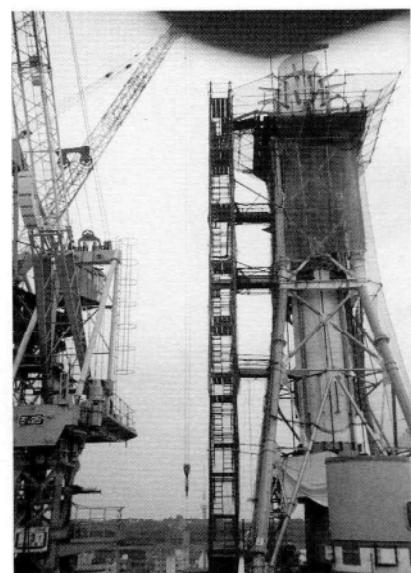
写真-2 工事用クレーン及び昇降設備
