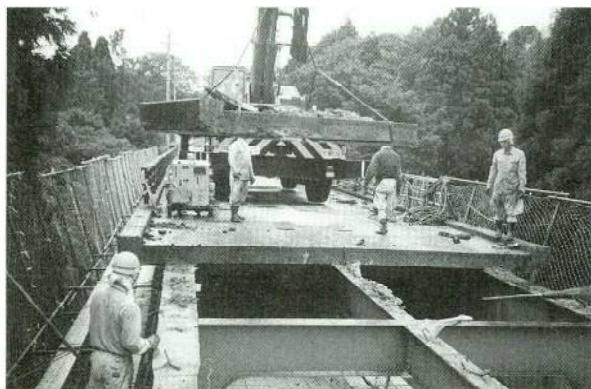
写真-2 床版撤去作業
