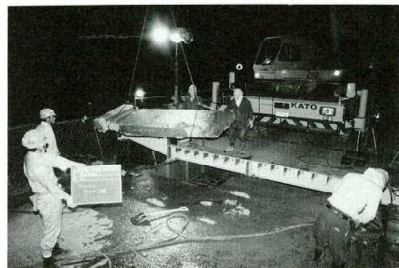
写真-1 クレーンによる取上げ作業
