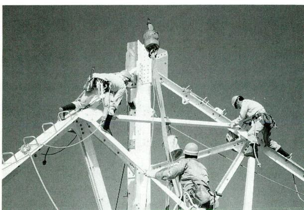
写真-6 キーロック方式安全ロープを使用した作業状況(2)
