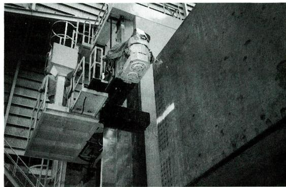
写真-3 添接部の孔明け加工
