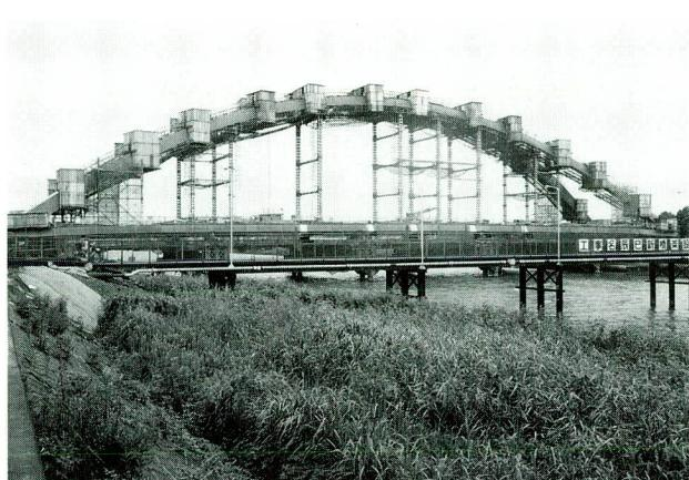
写真-3 現場溶接の風防施設の状況
