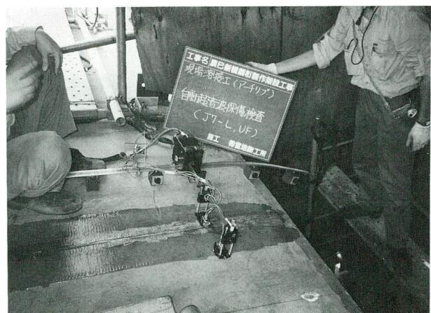
写真-5 自動超音波探傷の状況
