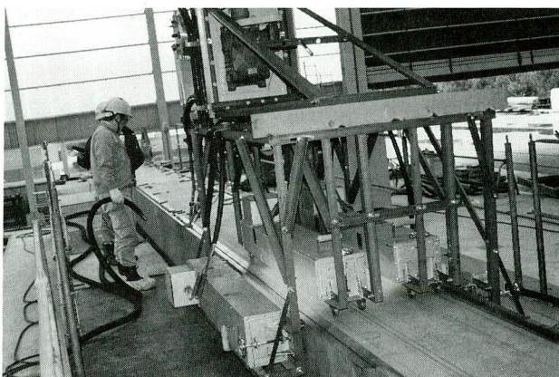
写真-7 J開先部分溶込みかど溶接時の移動熱源による予熱状況
