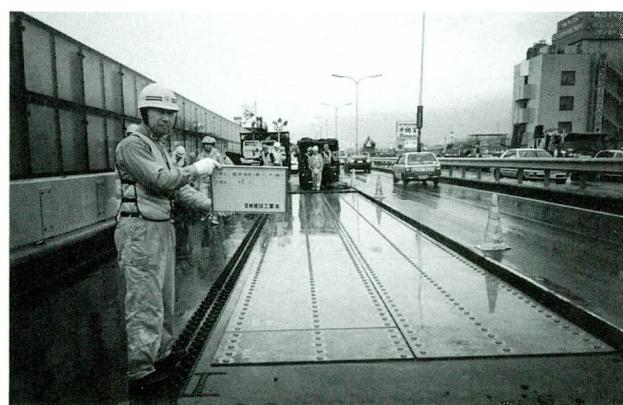
写真-3 デッキプレート補強構造
