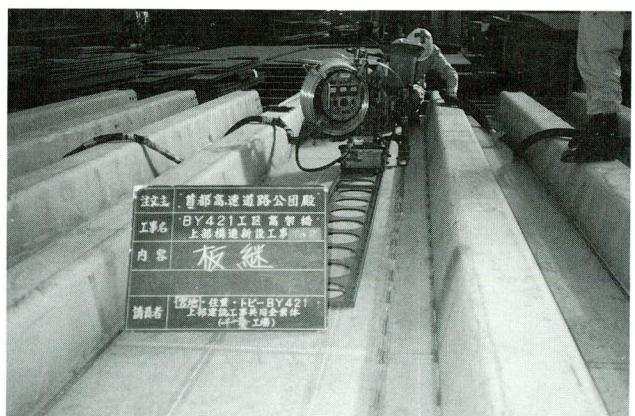
写真-5 先行組立溶接パネルの板継溶接
