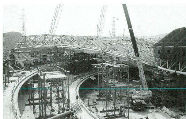
写真-8 屋根鉄骨組立状況
