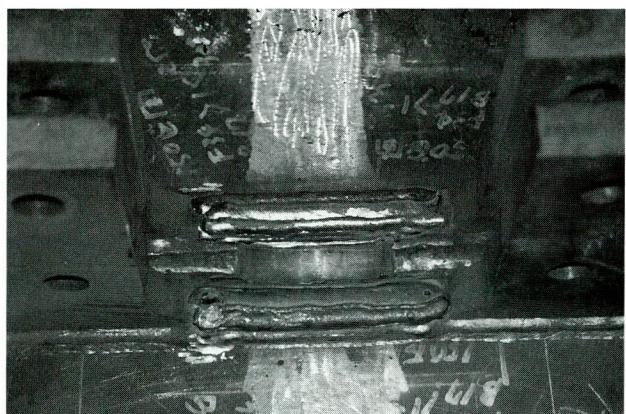
写真-5 縦リブスカーラップ補強溶接
