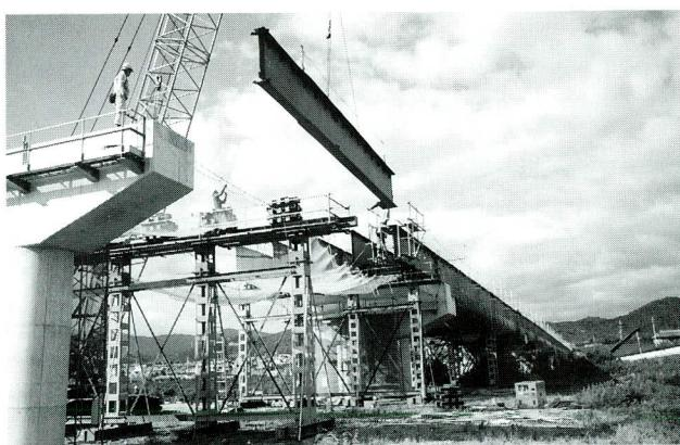
写真-5 主桁の架設
