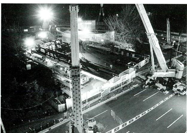
写真-4 架設桁縦取り状況
