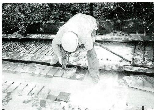
写真一　ウレタン吹付け施工状況
