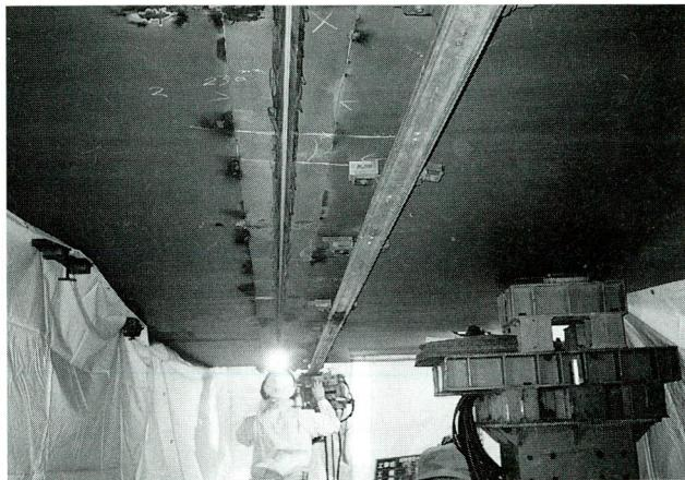
写真-6 横梁下フランジの溶接
