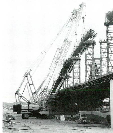
写真-4 アーチ部材の架設
