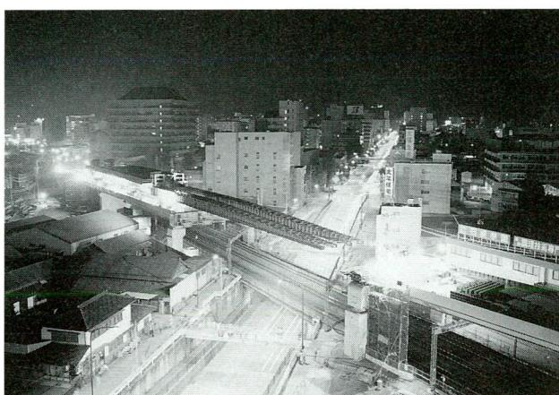
写真一4 G 4 桁送り出し状況
