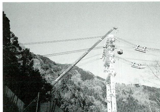
写真-7 ケーブルクレーン設備組立
