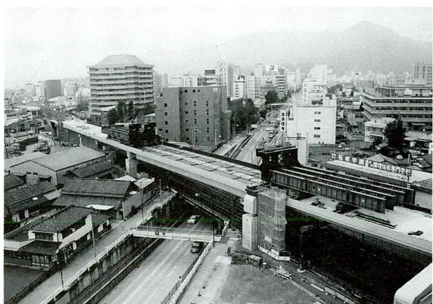
写真一6 G 4 桁降下完了
