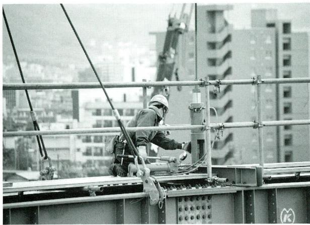
写真-6 吊りり点形状調整(50tセンターホールジャッキ使用)
