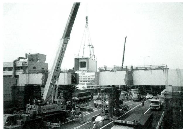
写真-20 梁部最終落し込み架設
