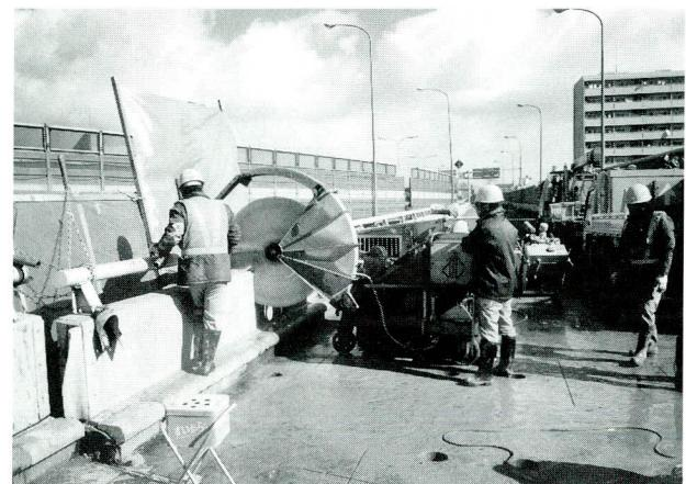
写真-15 高欄切断（橋軸直角方向）
