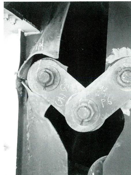
写真-4 耐震連結装置の損傷
