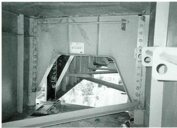
写真-29 若宮出路S3端横桁の損傷
