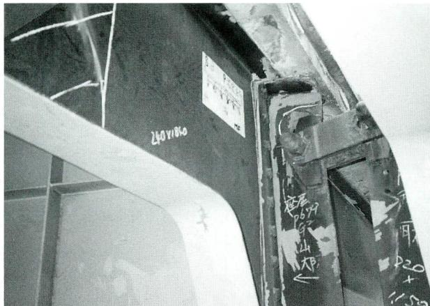
写真-30 若宮出路S3桁端部の損傷
