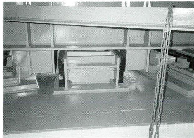
写真－34 橋軸直角方向ストッパー
