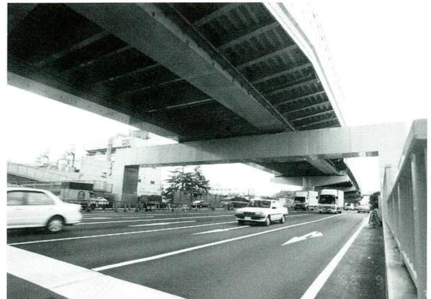
写真-17 神P150門型鋼製ラーメン橋脚
