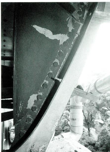
写真-9 神S144単純合成鋼桁の桁端部主桁損傷
