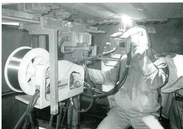
写真-7 下フランジ継手溶接
