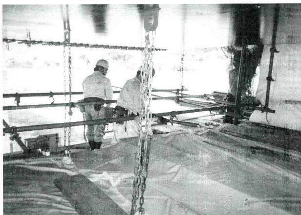
写真-2 移動足場上の吊り足場の解体作業
