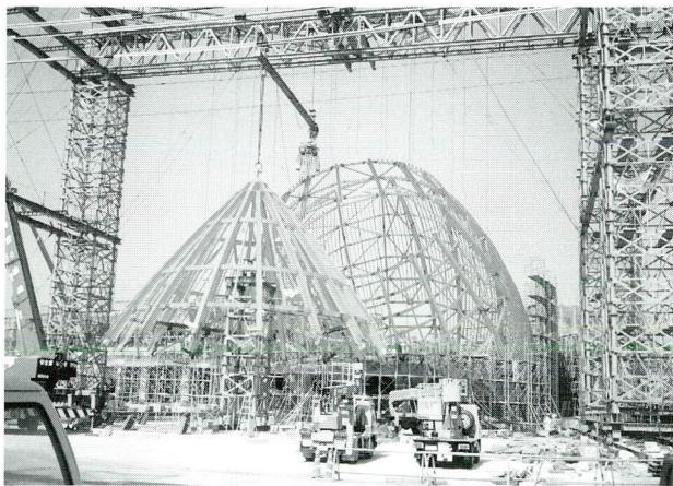
写真-3 第5節建方完了状況第6節コンカル部吊上げ状況
