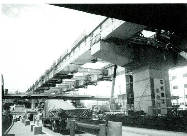
写真-12 3径間連続鋼床版箱桁（再構築）の主桁ブロック閉合
