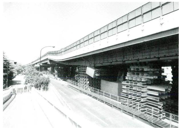
写真-7 3径間連続RC床版鋼箱桁が全体座屈により破壊
