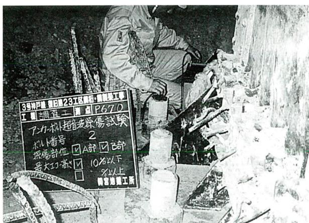
写真-40 超音波探傷検査
