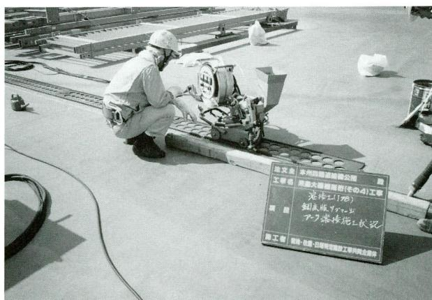
写真-7 デッキプレート溶接状況
