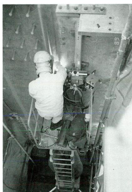
写真-6 エレクトロガスアーケット自動溶接状況
