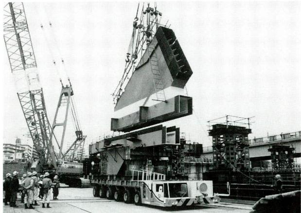
写真-9 桁場内運搬状況 2
