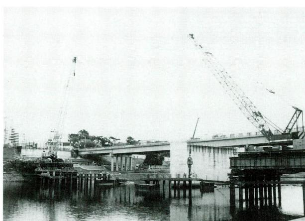
写真-2 棚橋設備 基礎杭の打設
