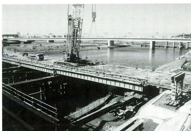
写真-4 ベント設備 工事桁の架設
