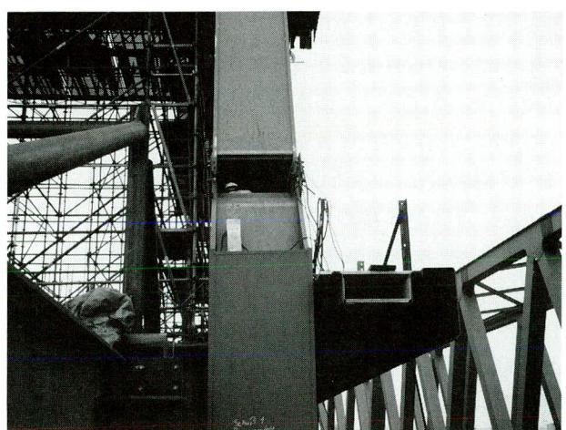
写真-9 ハブルグ市鉄道橋（ワーレントラス弦材）の全断面現場継手
