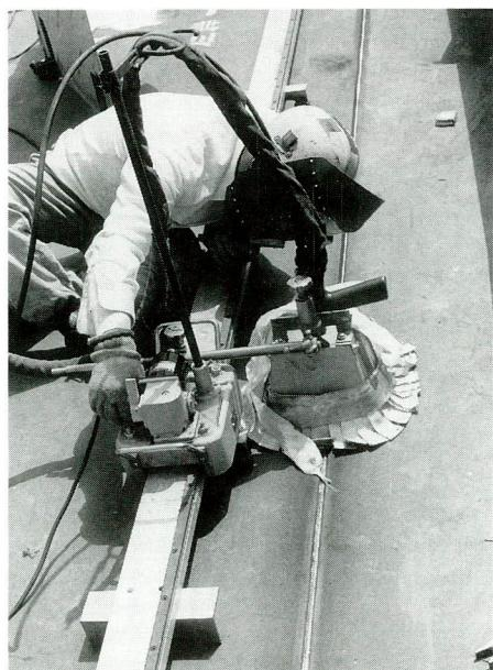
写真-4 S & WCO<sub>2</sub>法施工状況
