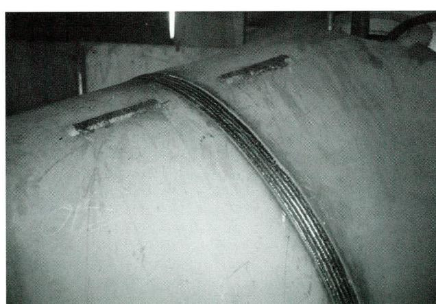
写真-5 鋼管アーチリブの現場溶接後
