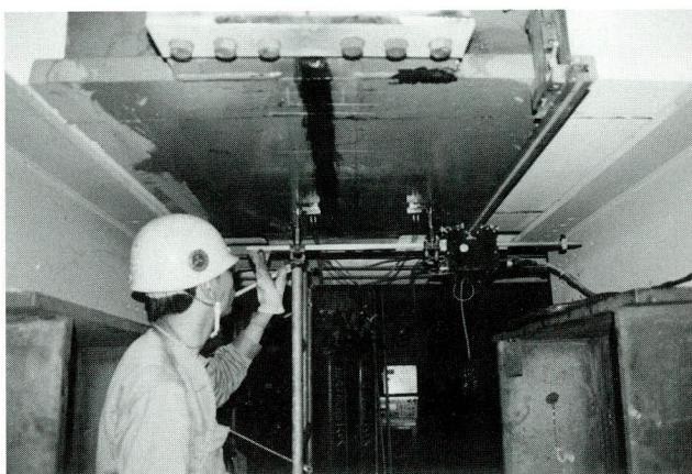
写真-1 箱桁全断面上向き溶接継手におけるAUTの施工例
