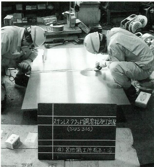
写真-4 突合せ溶接のビード削除
