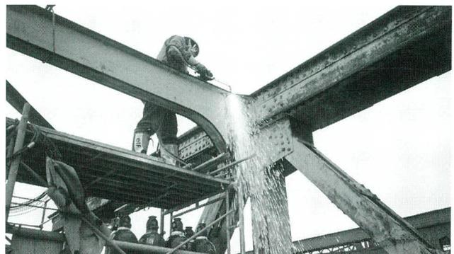
写真-11 トラス桁ガス切断状況
