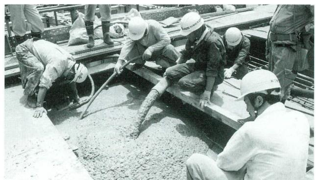
写真-6 剛結部コンクリート施工
