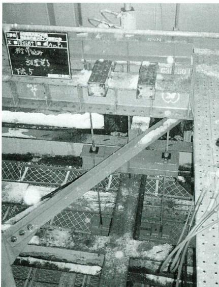
写真-5 トラス桁吊り下げ状況
