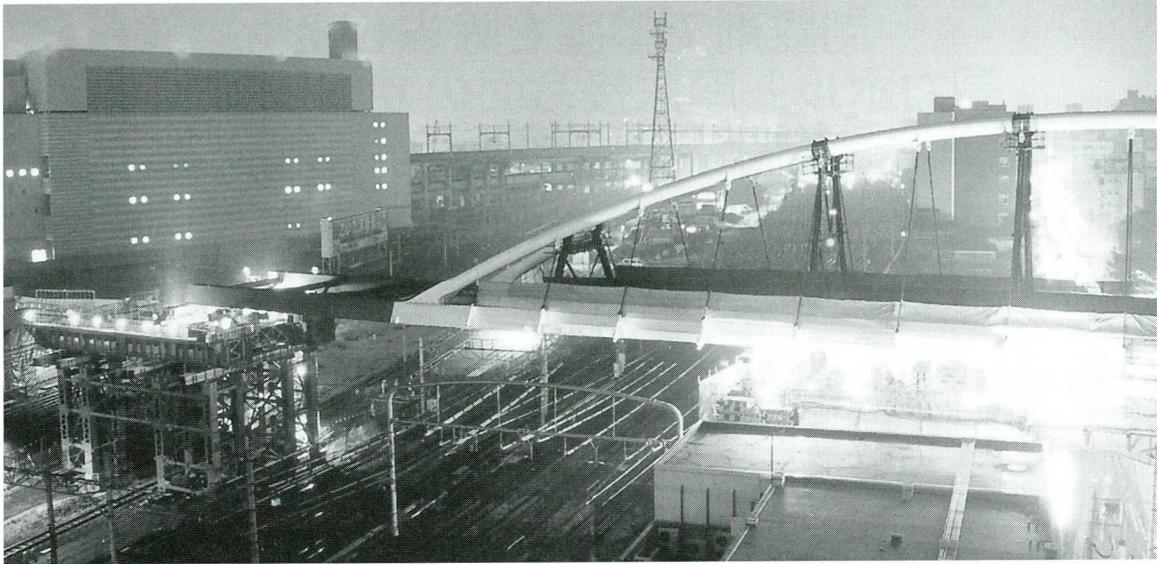
写真-11 第2回桁縦移動完了
