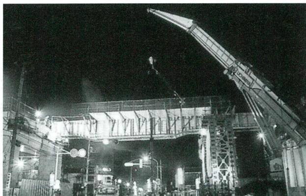
写真-3 工事桁架設
