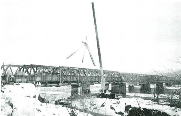
写真-8 トラス桁の撤去
