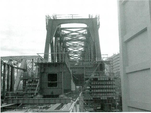
写真-11 工事桁引き戻し作業中
