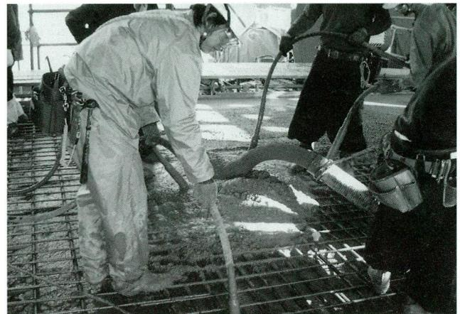
写真-44 コンクリートの打込み
