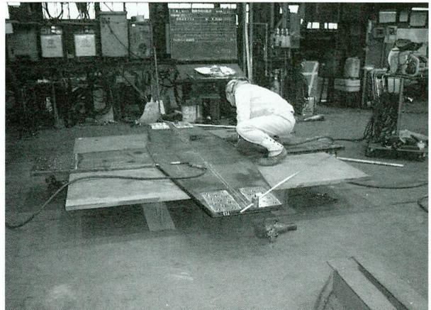
写真-1 下フランジ組立（定盤上で組立、食違い防止）
