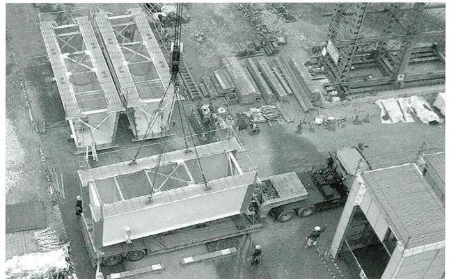
写真-6 開断面箱桁
