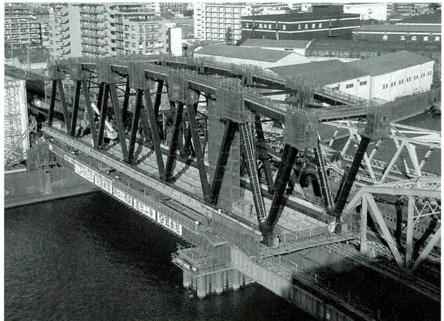
写真-8 トラス6パネル架設完了
