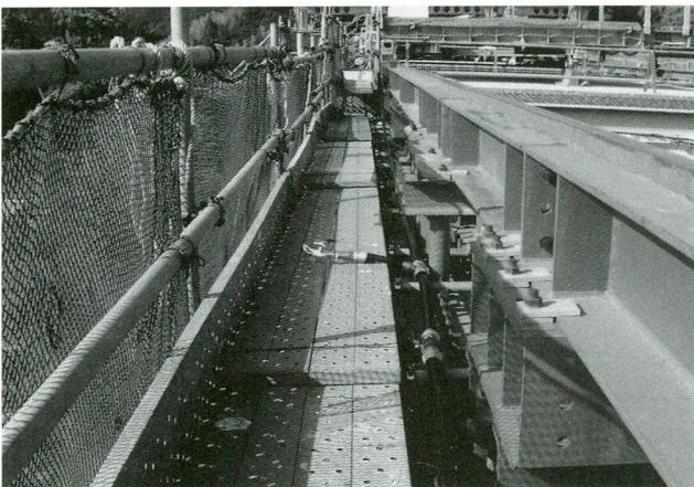
写真-22 主桁上面部の仮設通路足場
