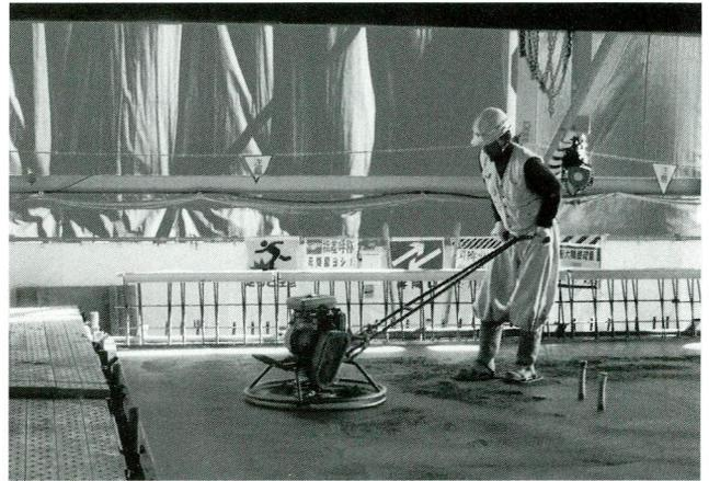
写真-48 トロウエルによる表面仕上げ
