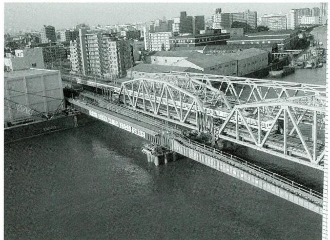
写真-3 工事桁手延べ送り出し架設中
