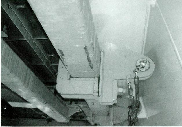
写真-34 挟み込み構造の連結金具
