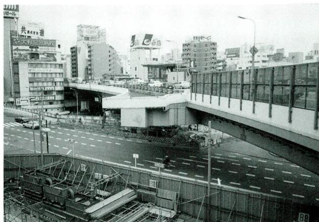
写真-2 既設本線桁の結合仕口
