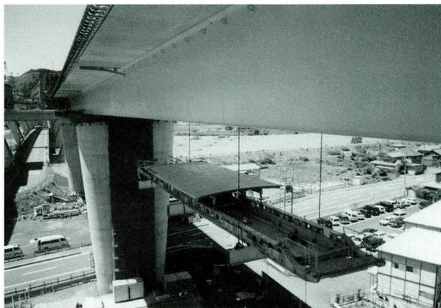
写真-29 インサイド型枠の降下
