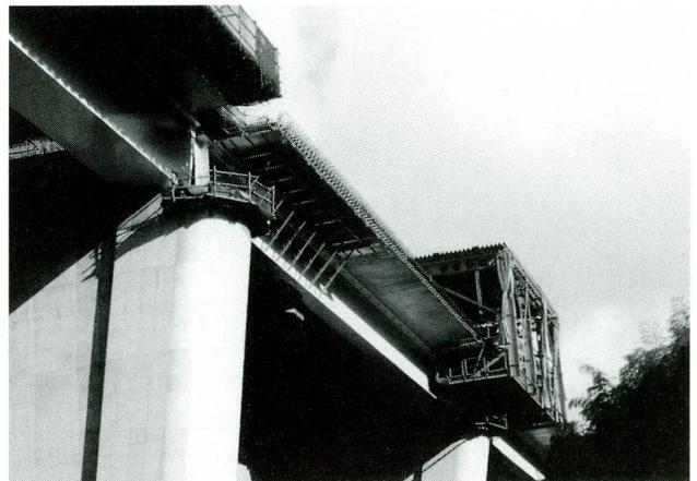
写真-14 アウトサイド型枠と分離した移動足場
