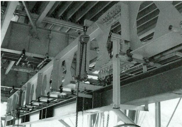
写真-35 吊り上げ、固定された軌条設備
