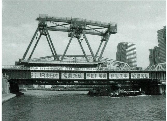
写真-7 トラス縦移動作業中
