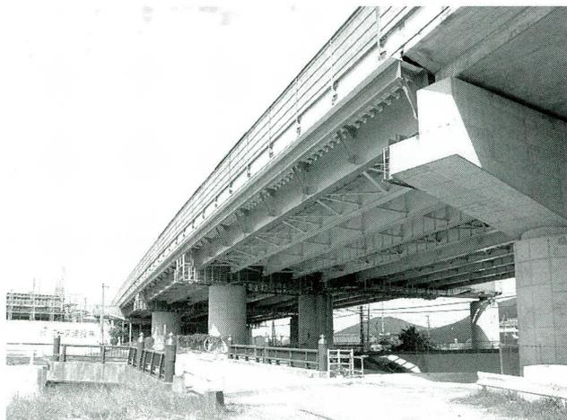
写真-2 底鋼板設置状況 (2)
