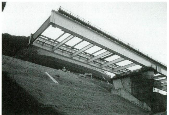
写真-7 鋼桁の送り出し架設
