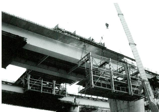
写真-27 移動型枠のブロック組立
