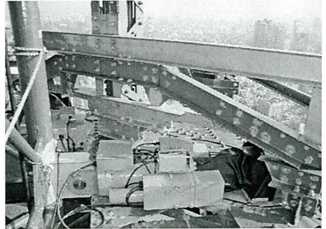
写真一九 制震ダンパー取付け後
