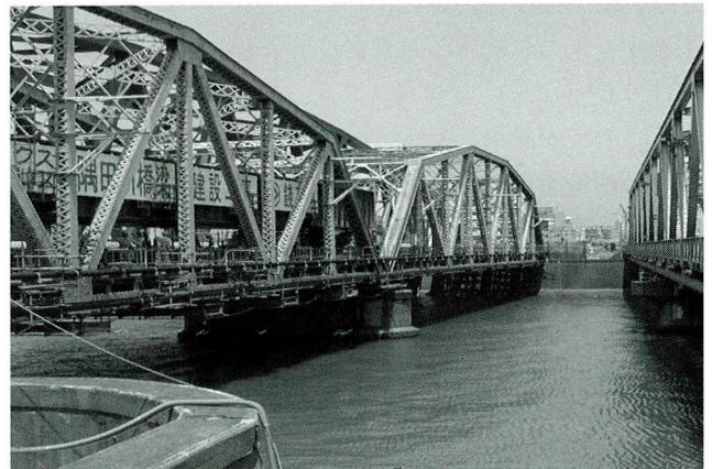
写真-4 架設桁縦移動架設中
