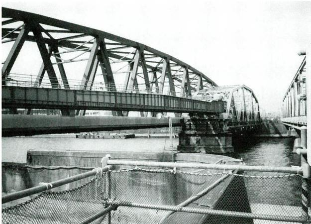
写真－9 架設桁引き戻し状況
