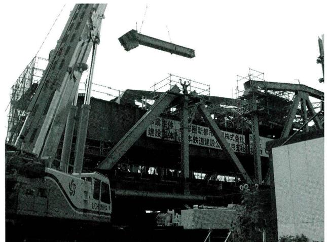
写真一六 最初の上弦材撤去
