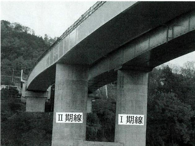
写真-2 II期線柱頭部施工後
