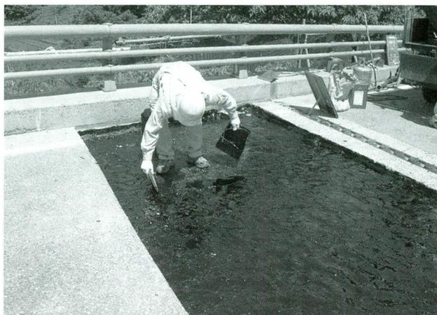
写真-7 加熱型塗膜防水処理
