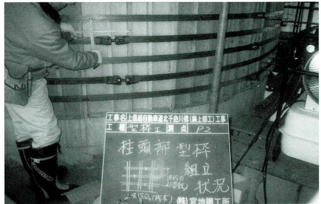
写真-2 木製型枠バンド施工状況
