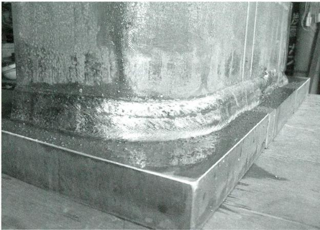
写真-4 溶接完了
