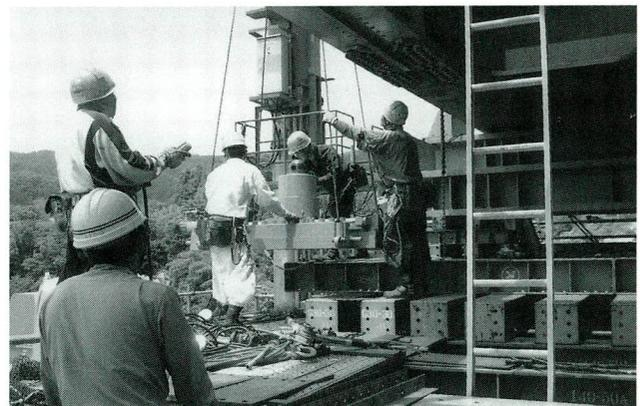
写真-18 送り装置撤去状況 (ジブクレーン)
