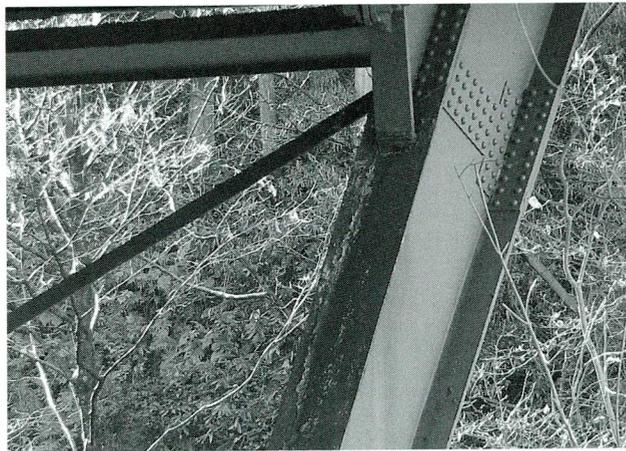
写真-15 ラーメン脚の塗装劣化部
