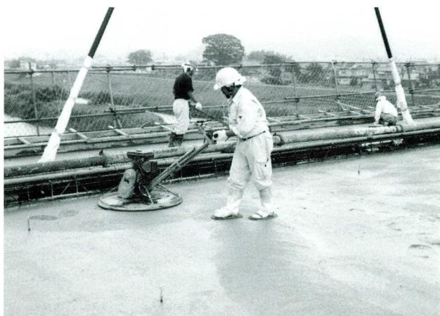
写真-3 トロウエルによる仕上げ
