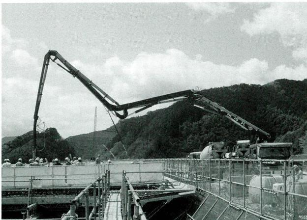
写真一九 床版施工状況 (左:下り線 右:上り線)
