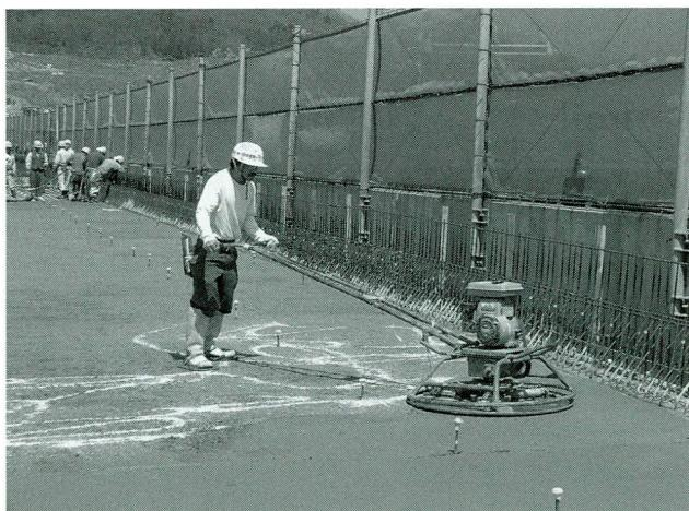
写真-44 床版天端養生材散布
