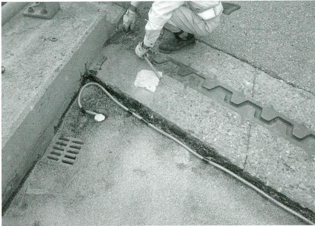
写真-8 導水管敷設
