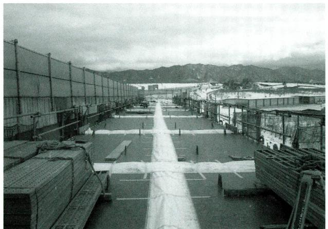
写真-27 上フランジシート養生状況
