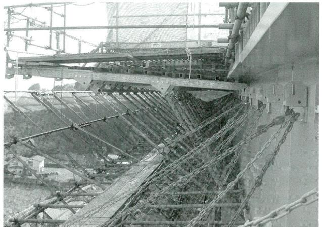
写真-1 支保工設置状況（床版張出部）
