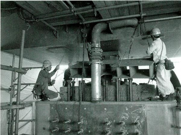
(a) 下部構造定着部材の取付け
