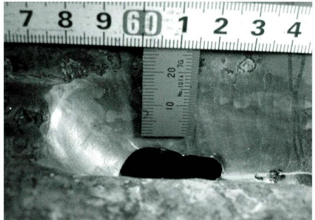
写真-15 カバーPL 端部の除去
