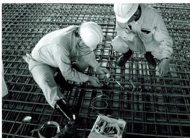
写真-4 計測機器の設置状況写真
