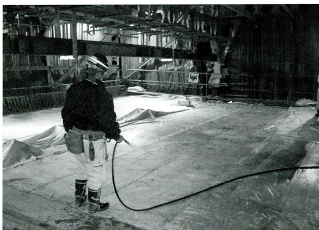
写真-2 床版上面の養生（散水状況）
