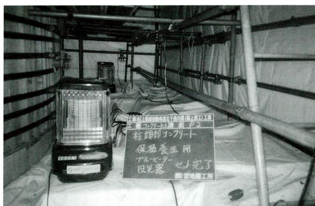
写真一 10 養生設備配置完了
