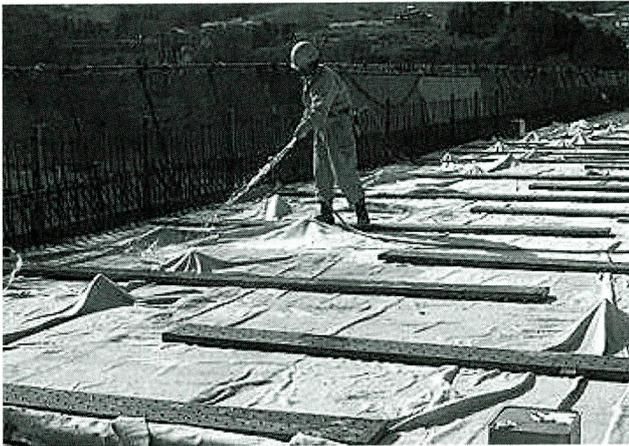
写真-47 養生マット敷設、散水養生
