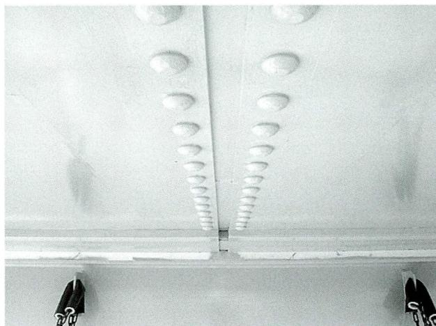
写真-38 調整パネル部外面塗装完了
