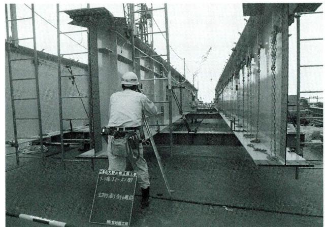
写真-10 主桁架設時の品質管理状況
