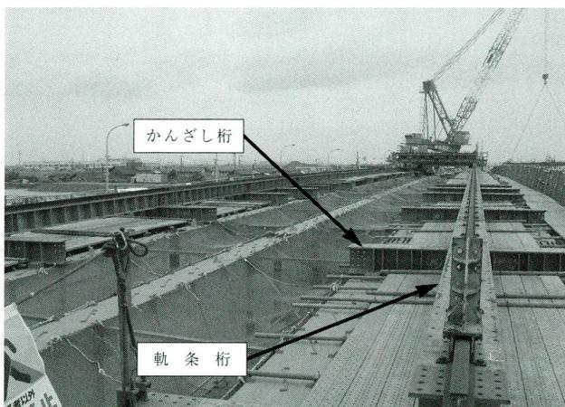
写真-5 クレーン・台車軌条
