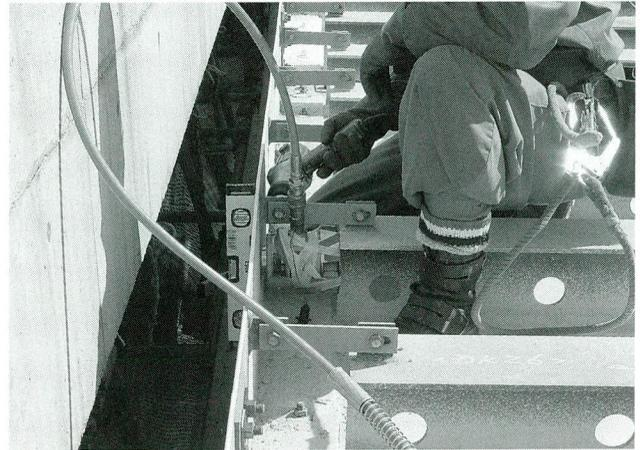
写真一36 側板通り調整状況
