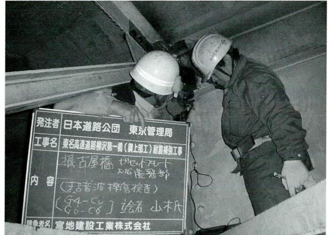
写真-22 超音波探傷試験
