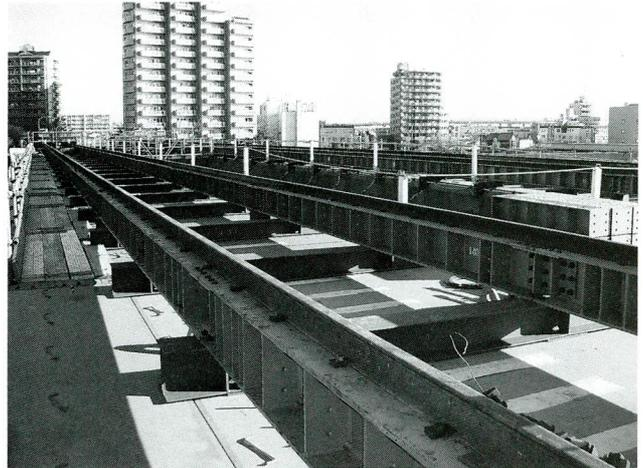
写真一五 桁引き出し軌条設置状況
