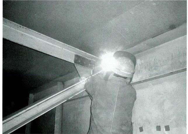
写真-17 ガセットプレート溶接
