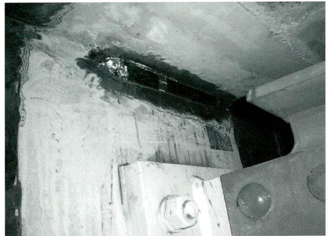
写真-14 亀裂補修完了
