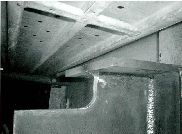
写真-5 溶接完了
