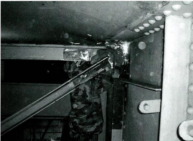
写真-15 既設部材切断状況
