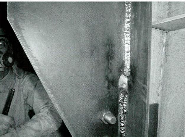
写真-6 溶接完了
