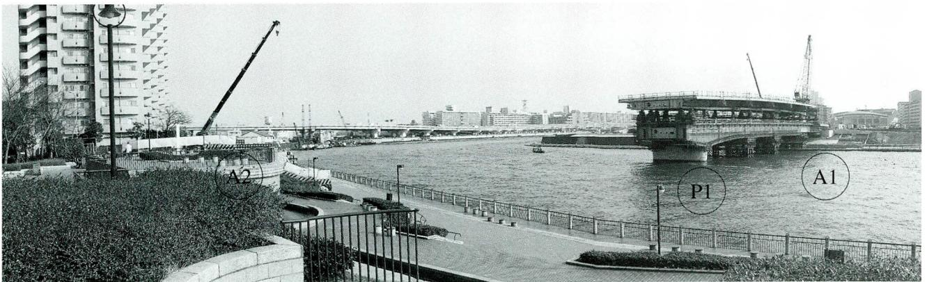
写真一七 引き出し桁組み立て完了状況
