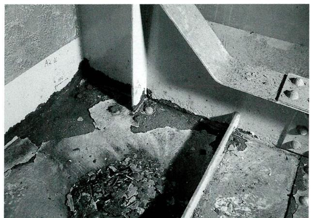
写真-4 箱桁内腐食状況（その2）
