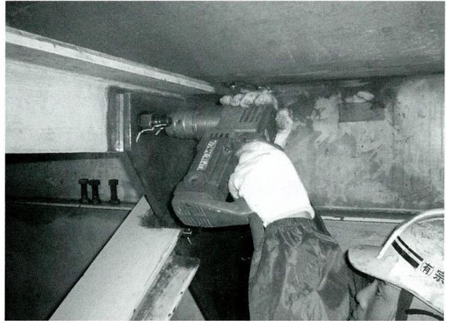
写真-18 高力ボルト本締め
