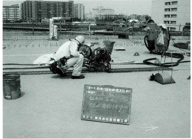
写真-15 鋼床版溶接状況
