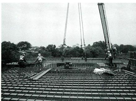
写真-10 合成床版架設状況-2
