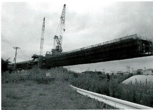
写真-2 台風接近時のトラベラクレーンの後退状況
