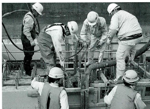
写真-2 主桁部コンクリートの打設
