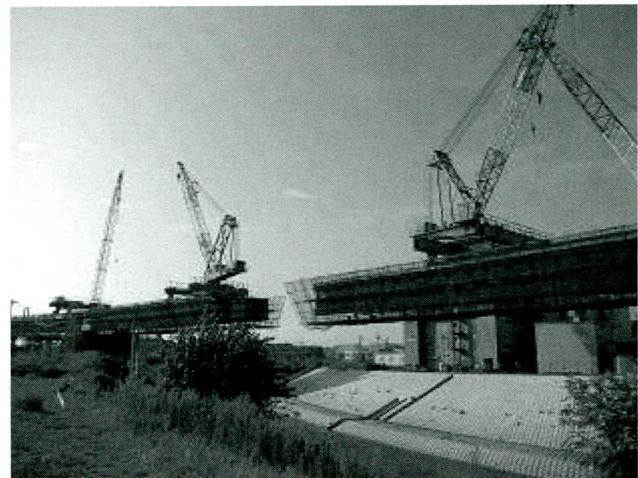
写真-1 架設状況 (4パネル張り出し)
