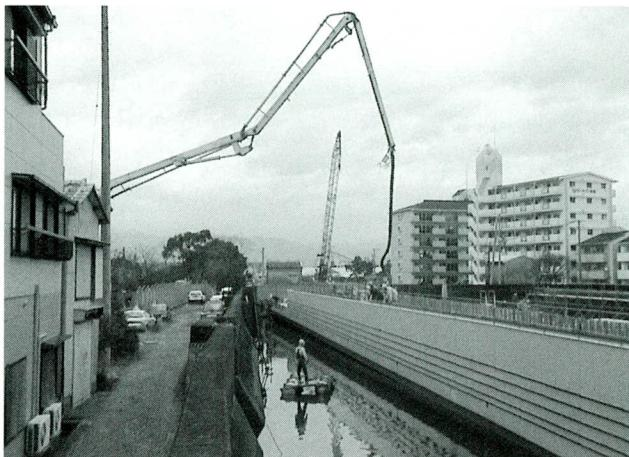
写真-5 壁高欄部コンクリート打設
