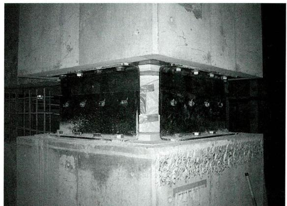
写真-12 免震装置固定プレート
