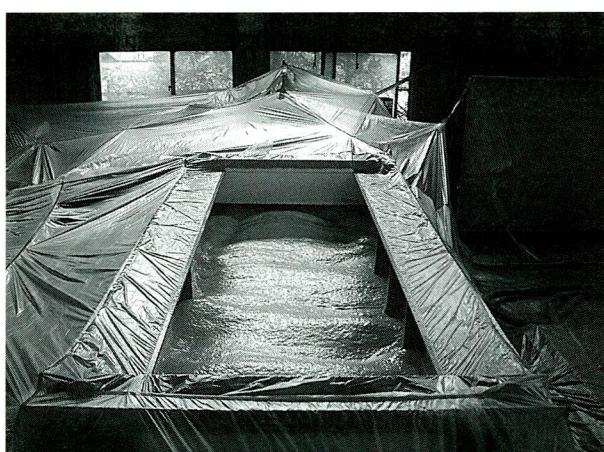
写真-8 先行施工ウレタン充填状況
