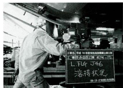
写真-12 斜め上向き自動溶接作業状況
