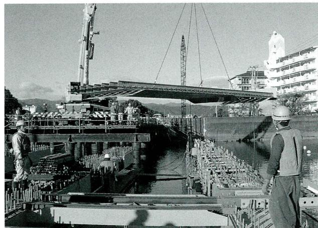
写真-3 FRP床版パネルの架設
