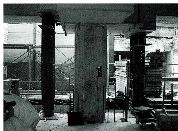
写真-2 仮受支柱設置状況
