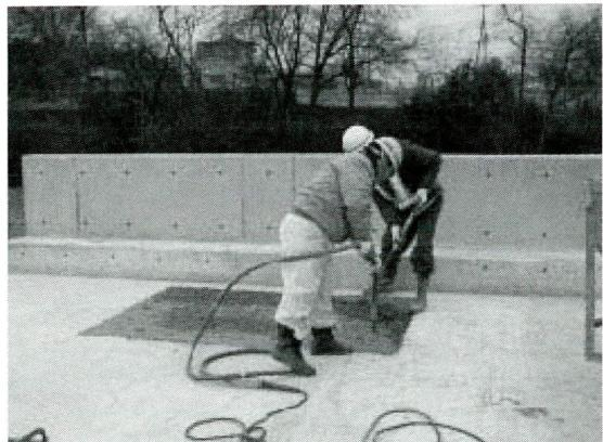
(d) 新コンクリートの締固め
