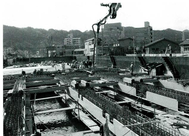
写真-4 床版部コンクリートの打設
