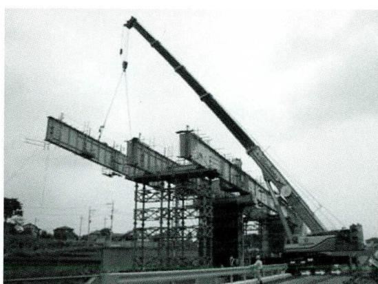
写真-4 主桁架設状況
