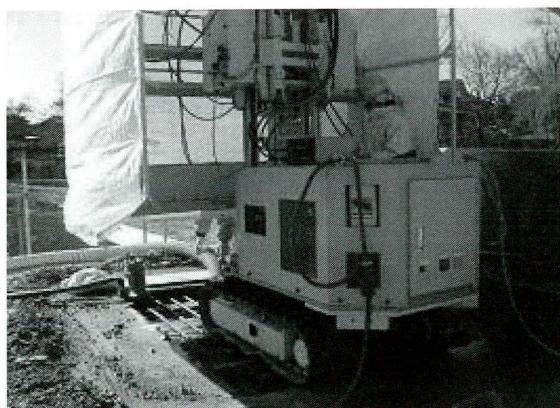
(a) ロボットによるはつり状況
