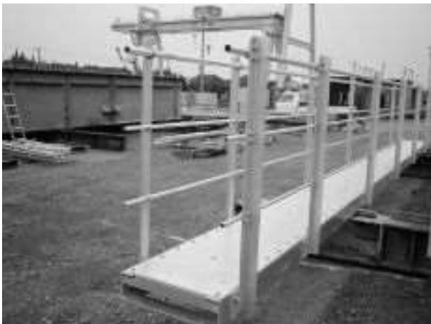
写真一 1 鋼製検査路の実物写真
