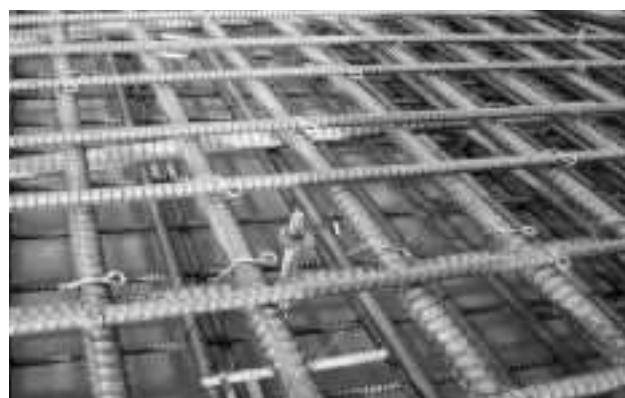
写真-7 鉄筋・PC鋼材の組立状況
