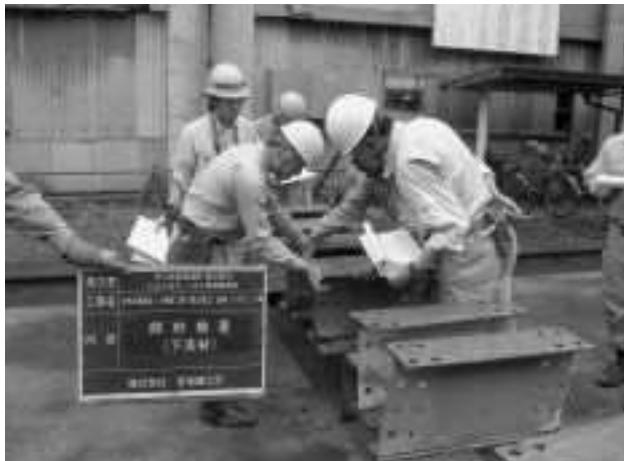
図-15 下支材写真 (部材検査時)
