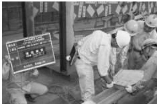
図-10 ガセットPL写真（部材検査時）
