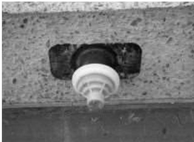
写真-14 PC鋼材切断部の養生
