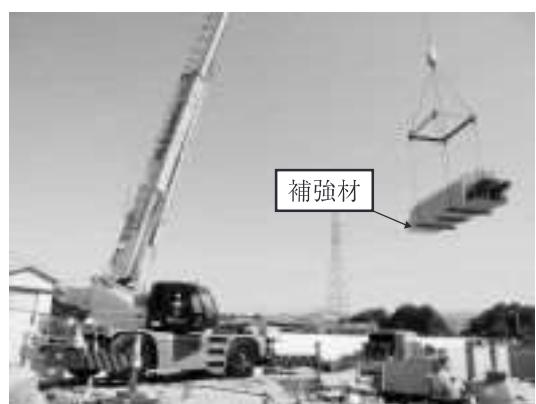
写真-2 主桁パネルの架設状況
