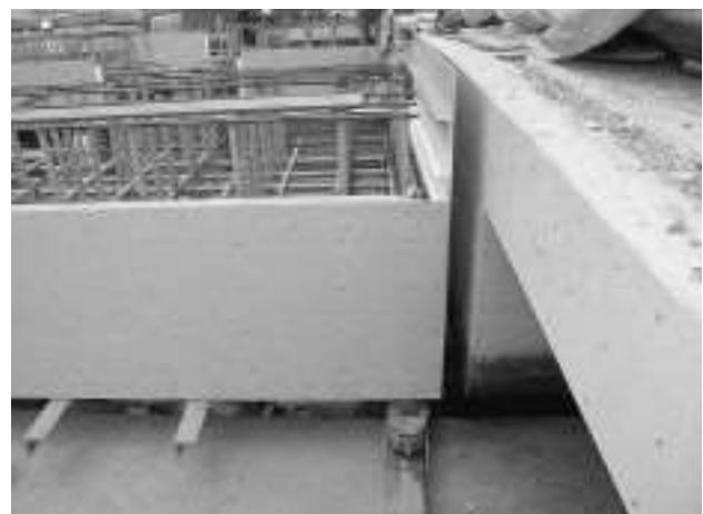
写真-7 張出部仮受け構造 (外桁)
