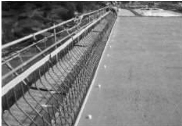
写真-12 止水板の設置状況
