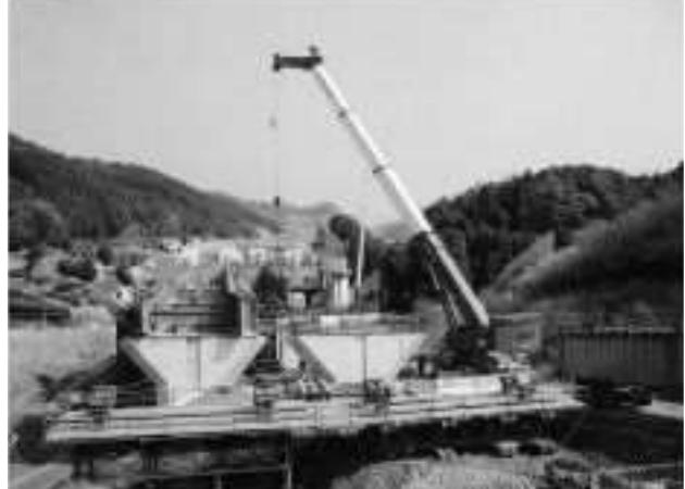
写真四 A1～P3間の鋼桁架設
