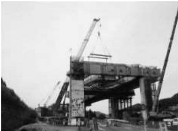
写真一 県道交差部鋼桁の大ブロック架設
