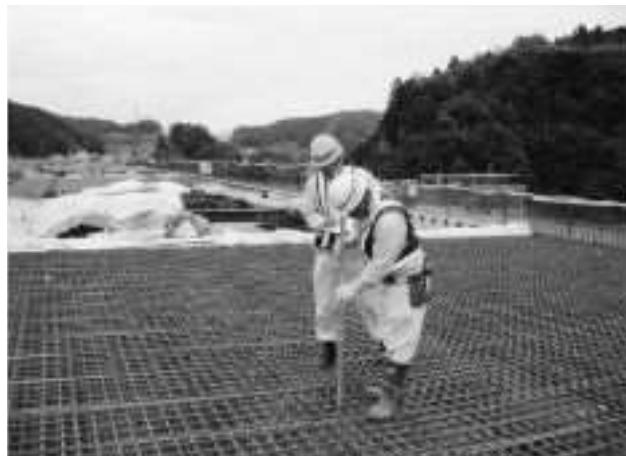
写真-9 PC鋼材設置高さの確認状況
