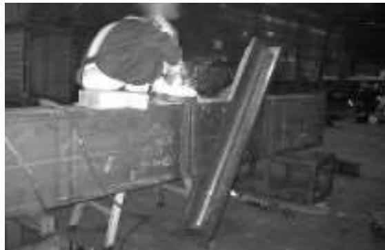
溝形梁とプレース交差部を組立て溶接する
