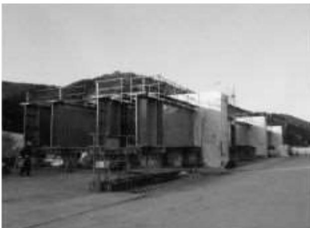
写真二 A1橋台背面ヤードでの鋼桁地組立
