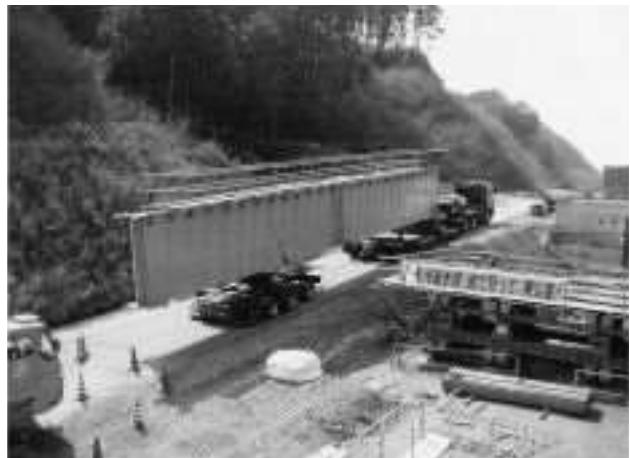
写真三 鋼桁ブロックの構内運搬
