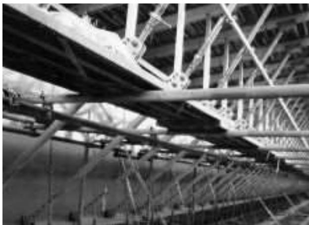
写真-6 床版型枠支保工
