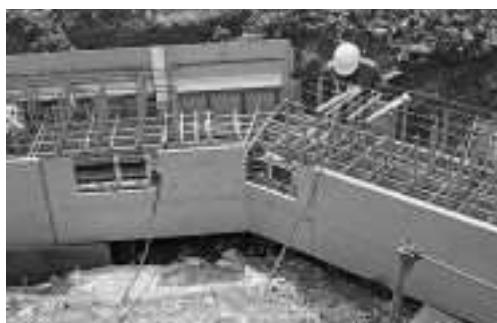
写真-3 杭周り主桁配筋状況（折れ部）
