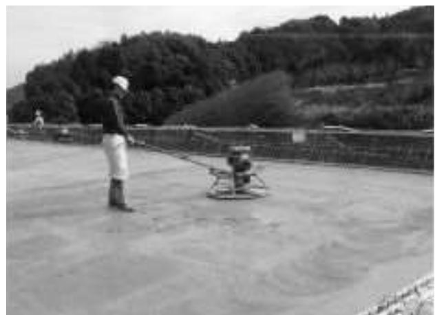
写真-11 トロウェルによる表面仕上げ
