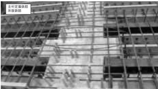
写真-9 床版鉄筋配筋状況
