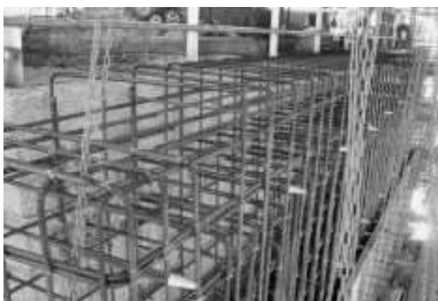
写真-1 緑端拡幅配筋状況
