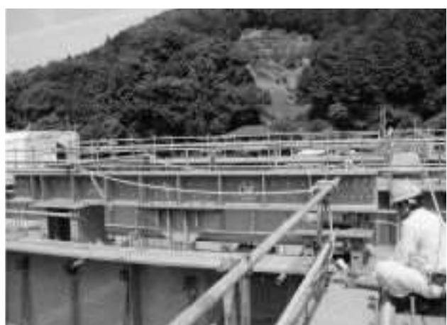
写真五 セッティングビームによる鋼桁高さ調整
