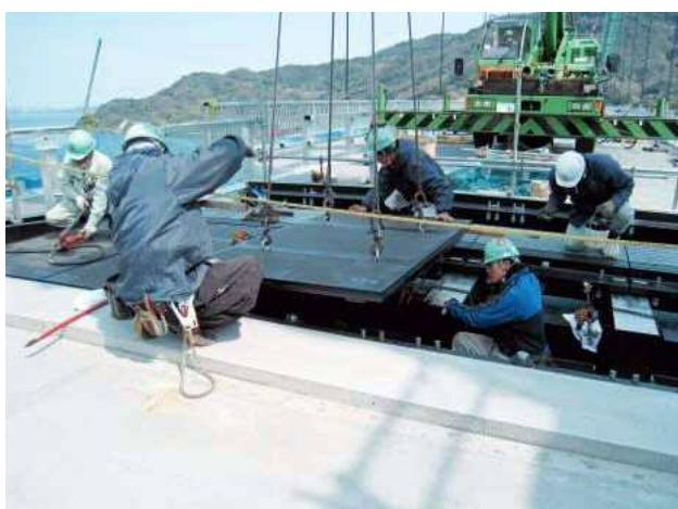
写真一9 伸縮装置据付状況
