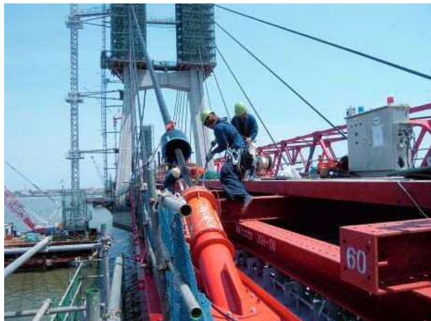
写真-3 斜材ケーブル架設状況（橋面）
