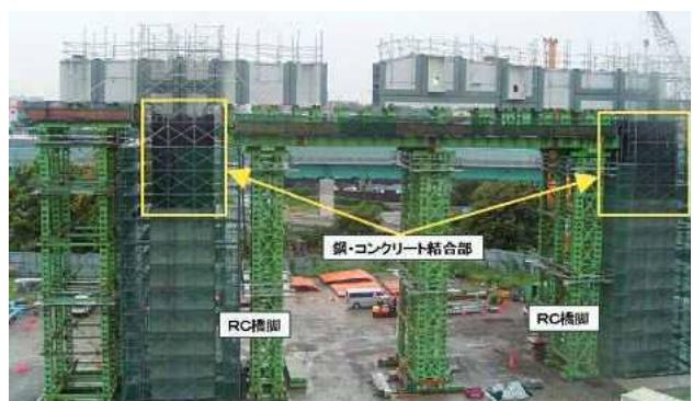
写真-1 BP13複合橋脚の架設状況
