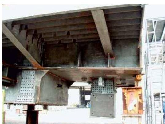
写真-2 D連結路N P 2 9側の端支点構造
