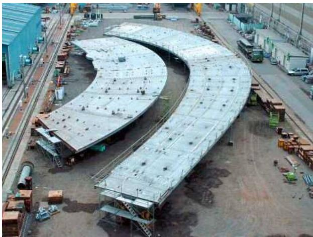
写真一4 B・D連結路主桁の全景 (R=43m・48m)
