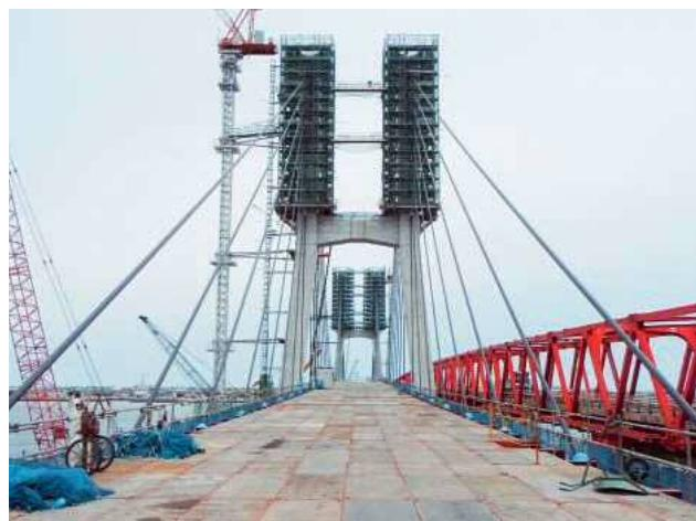
写真-5 橋面覆工設備
