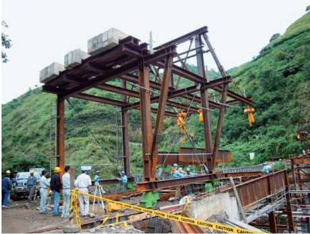
写真-3 ポータルクレーン設置状況
