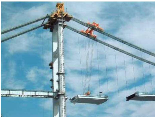
写真一五 スイング架設状況(2)
