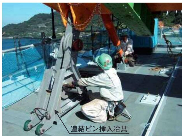
写真-13 補剛桁の2吊点部状況
