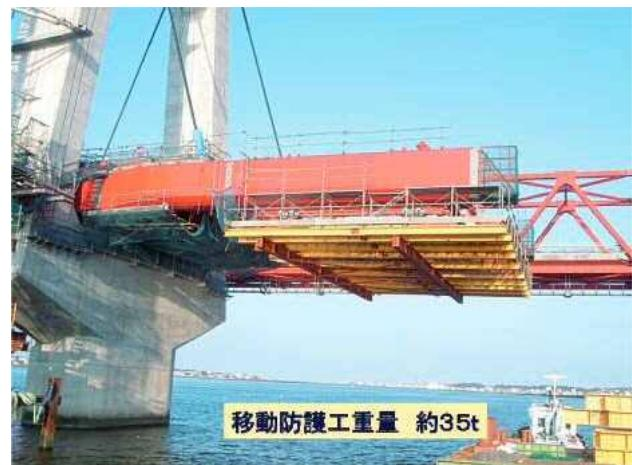
写真-8 移動防護工
