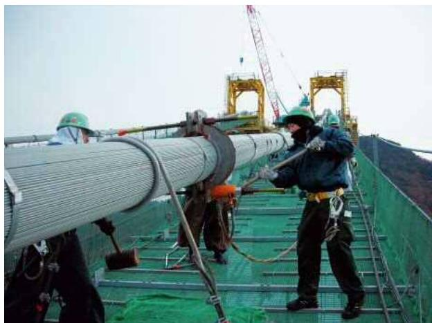
写真-10 主ケーブル断面の補整状況
