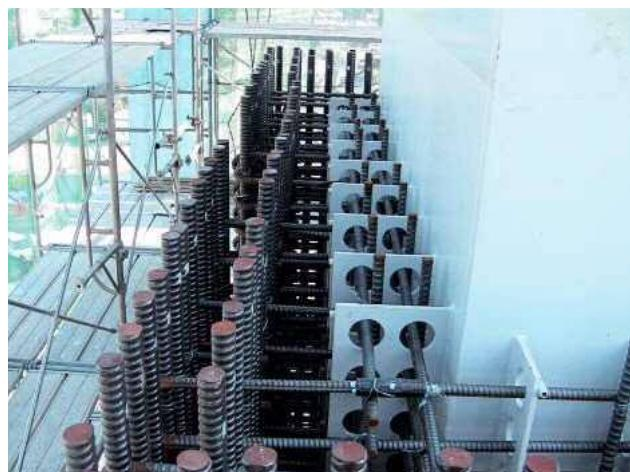
写真-2 複合橋脚結合部の配筋
