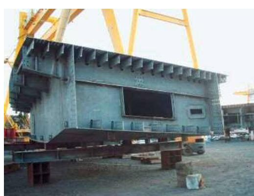
写真-3 既設橋脚回避部の主桁断面
