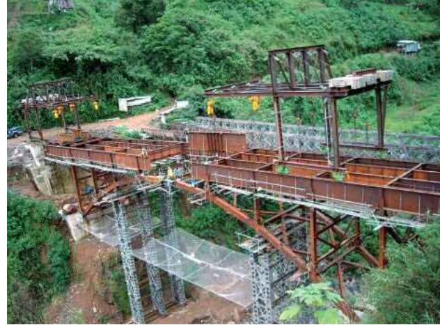
写真-4 閉合ブロック架設状況
