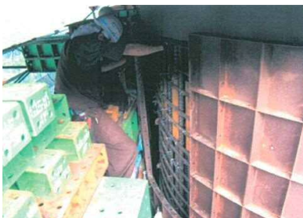
写真-5 鋼製型枠の設置
