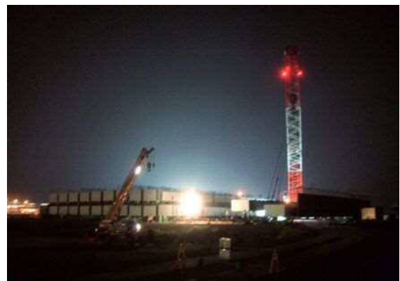
写真-7 夜間の桁移動
