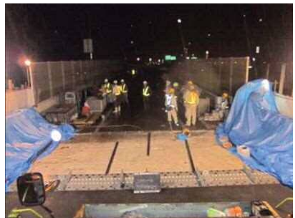
写真-22 コンクリート養生状況
