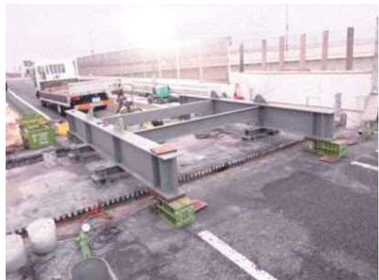
写真-13 セッティングビーム設置状況
