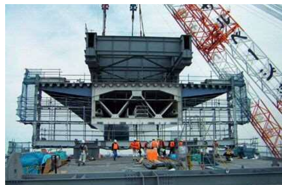
写真-2 セッティングビーム断面
