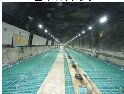
上側鉄筋組立
