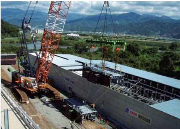
写真-2 大型風防設備
