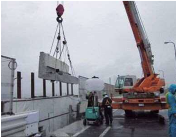
写真-14 壁高欄撤去状況
