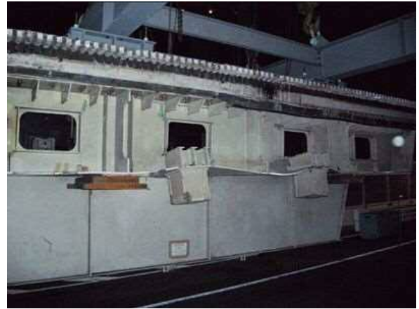
写真-16 撤去桁 (拡大)
