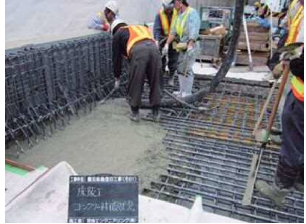
写真-20 コンクリート打設状況
