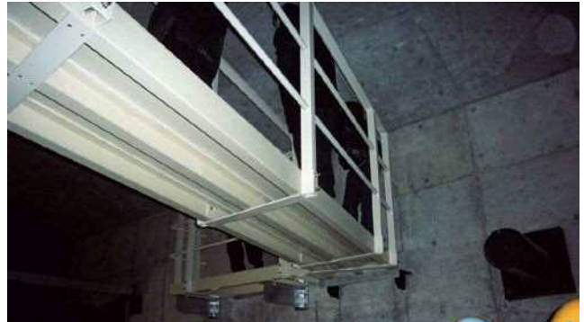
写真-1 (仮称) 駒瀬川橋FRP製検査路
