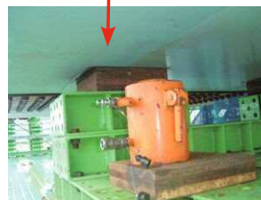
写真-19 樺町Bo架設 電動台車と桁受け点
