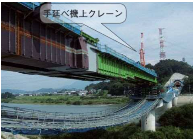
写真-4 手延べ機取り付け状況
