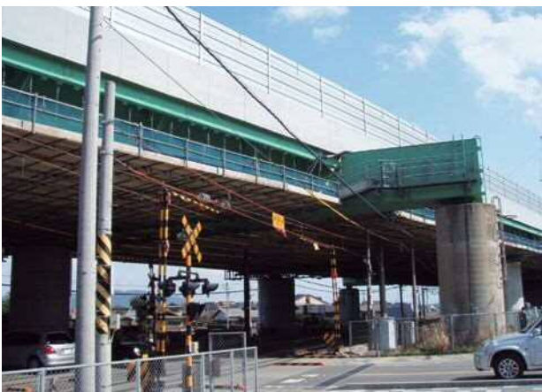
写真二 市道との交差状況
