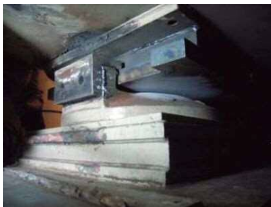
写真-10 仮上柵設置状況
