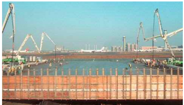
写真-10 床版打設状況
