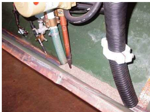
写真一6 溶接状況 (ノズル周辺)
