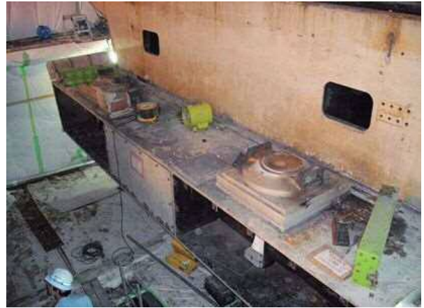
写真-17 既設橋脚状況
