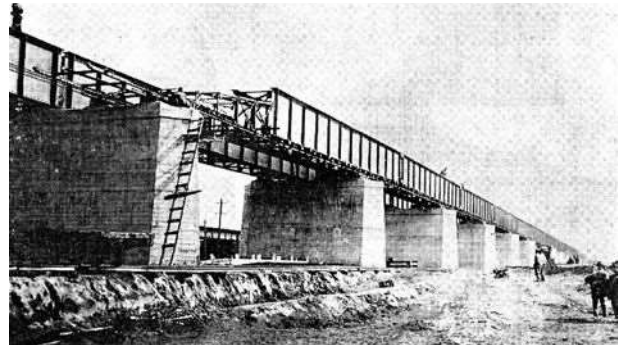
写真一6 ガーダーの連結式架設（1） （東北本線・荒川橋梁、昭和2年）
