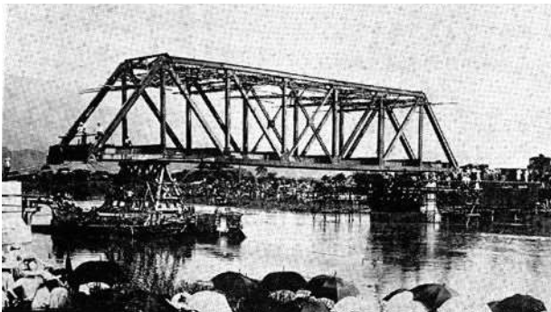
写真一5 ポンツーンによる引き出し架設 （長崎本線・六角川橋梁、昭和4年）
