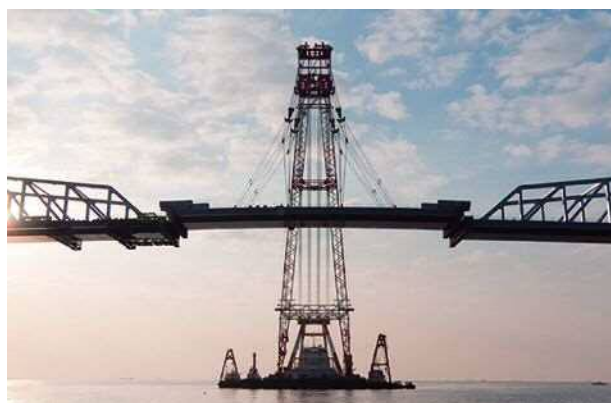
写真一〇 中央箱桁による東京ゲートブリッジ閉合
