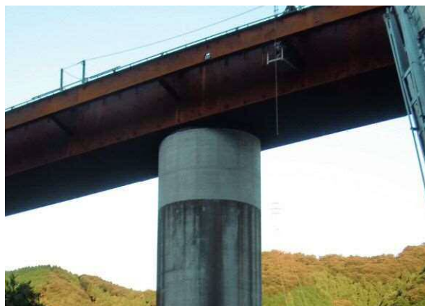
写真-6 剛結部コンクリート施工完了後
