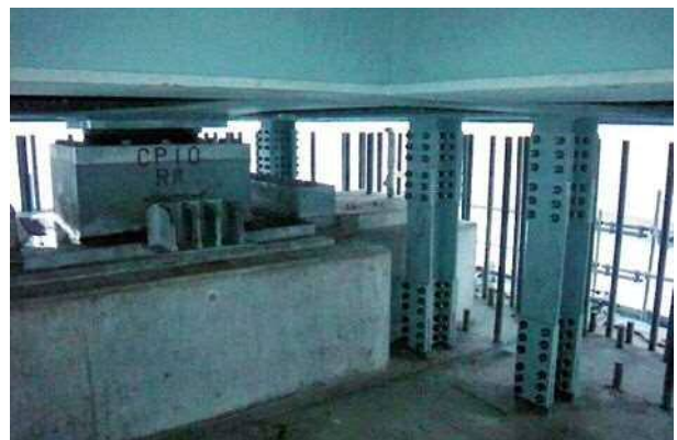
写真一13 橋脚部仮固定設備
