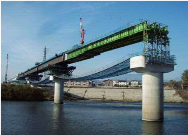
写真一1 架設状況
