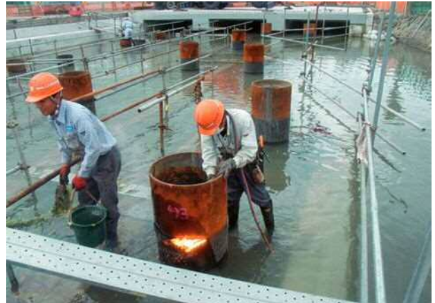
写真-2 鋼管杭ガス切断状況
