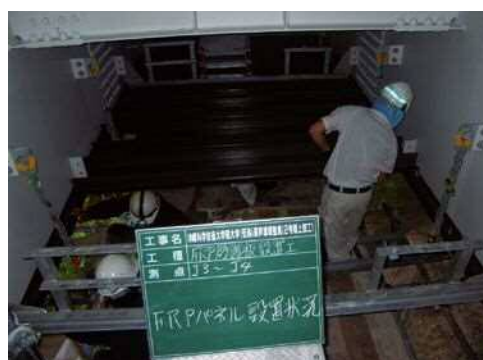
写真-3 FRP防護板設置状況
