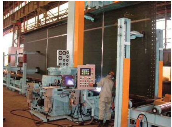
写真-2 自動組立溶接の状況
