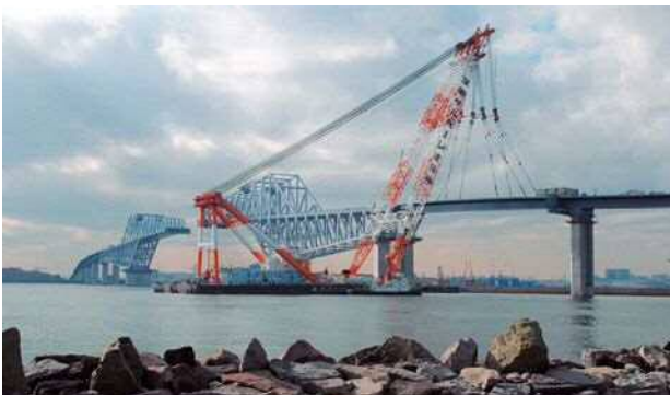
写真一11 架設状況写真
