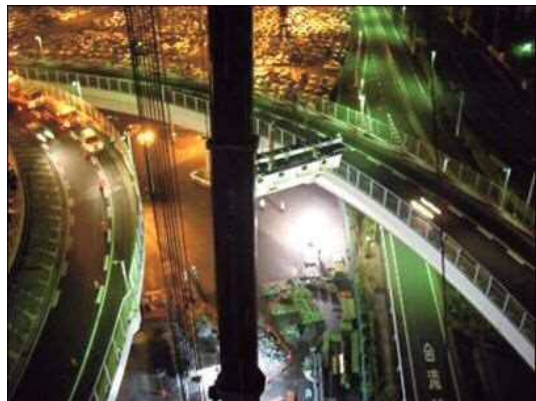
写真-15 損傷桁撤去状況
