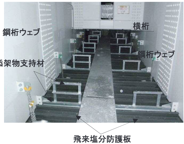
写真-7 FRP飛来塩分防護板の施工事例
