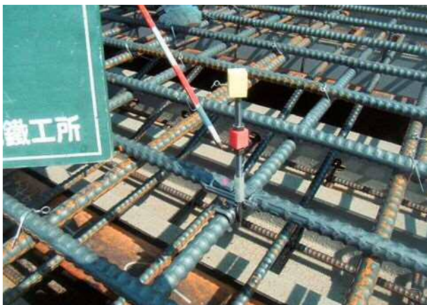
写真-8 検測棒設置状況
