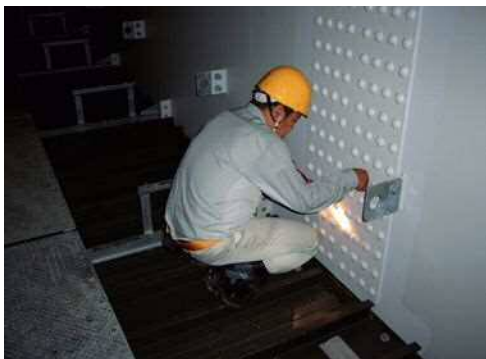
写真-6 点検状況イメージ1
