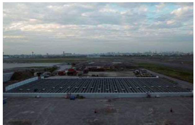
写真-9 全22ブロック架設完了
