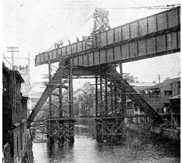
写真-3 ガーダーの帆柱式架設 (総武本線・神田川橋梁、昭和7年)
