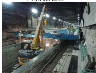
FRP パネルの設置
