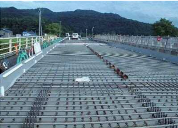
写真-1 FRP床版写真
