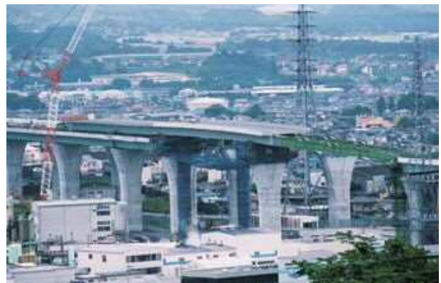
写真-16 身延線第二東名Bo上部工新設送り出し架設工事
