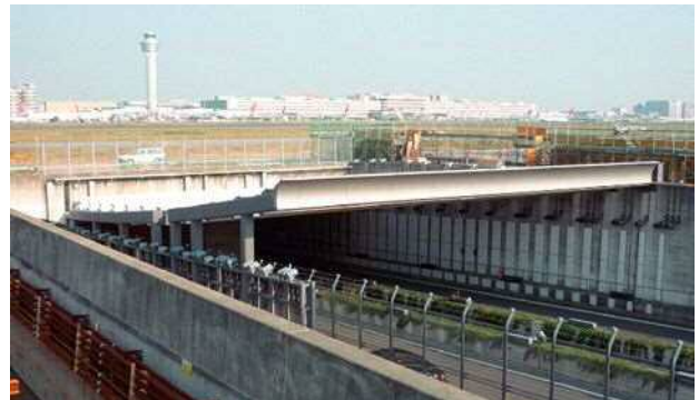
写真-2 遮光ルーバー
