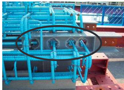
写真-4 孔径拡大部
