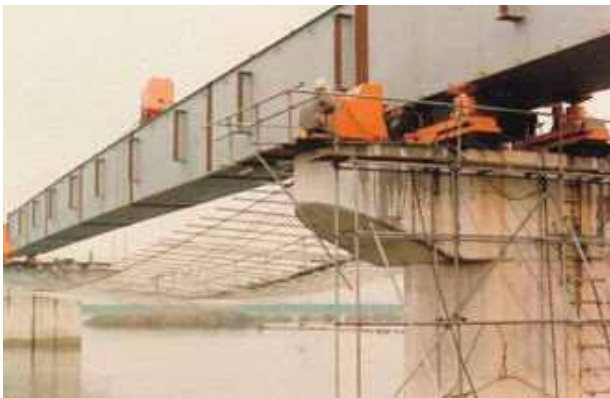
写真-13 BC291工区の送り出し架設
