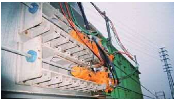
写真-18 50t引きエンドレスキャリー
