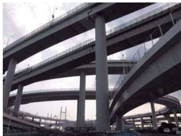
写真-25 大206災害復旧完了状況（桁下）
