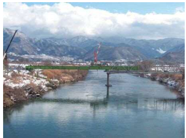
写真-12 撤去状況
