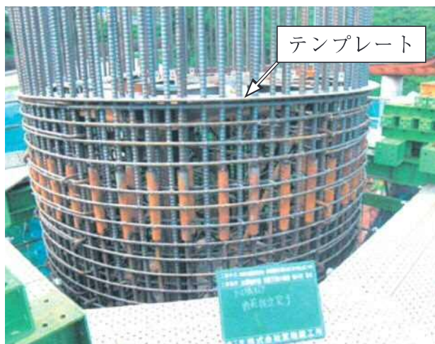
写真一3 柱頭部鉄筋の組立て状況
