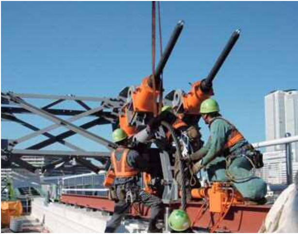
写真-2 引き込み設備組立状況
