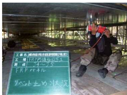
写真-4 リベット接合状況
