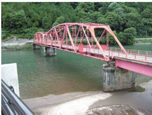
写真一 撤去前
