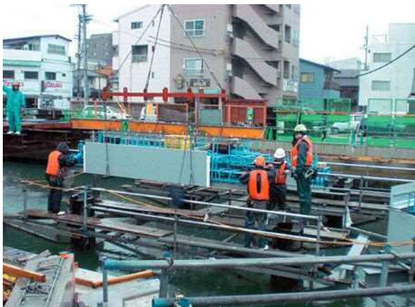
写真-5 主桁パネル架設状況
