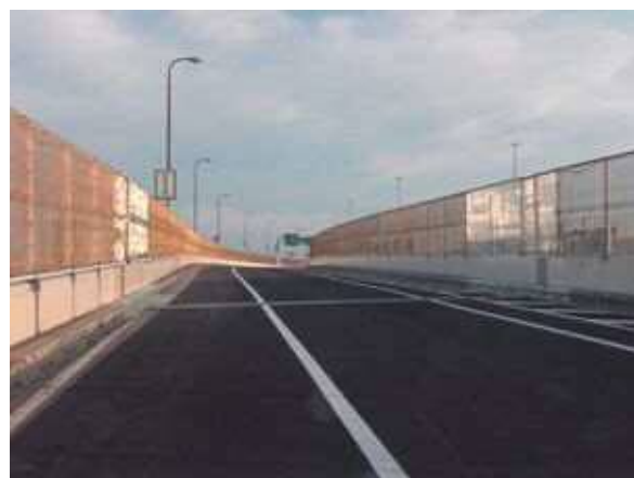
写真-26 大206災害復旧完了状況（橋面）
