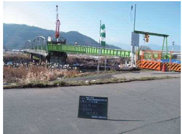
写真-10 撤去状況
