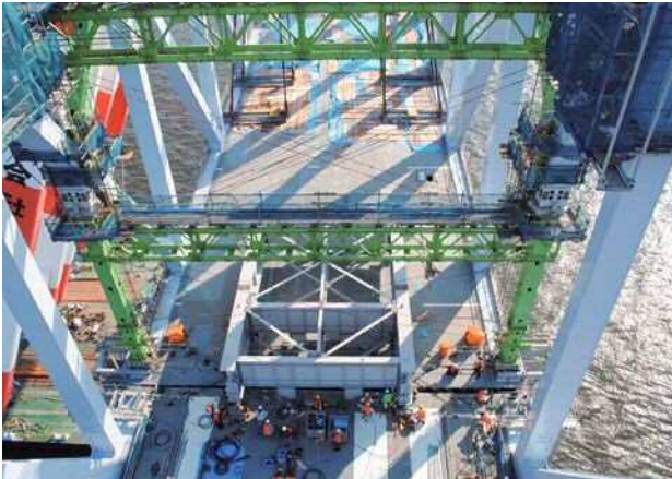
写真-2 トラス形状保持材とセッティングビーム
