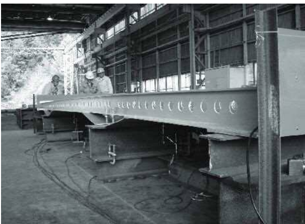
写真-6 強制変位載荷時の状況
