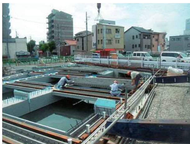
写真-6 床版パネル架設状況
