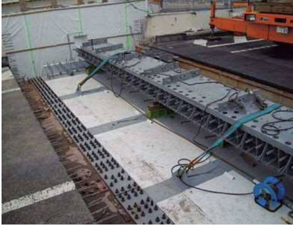
写真-19 伸縮装置搬入状況
