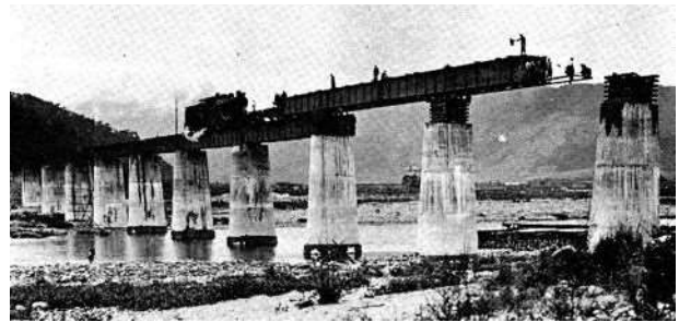
写真一7 ガーダーの連結式架設（2）
