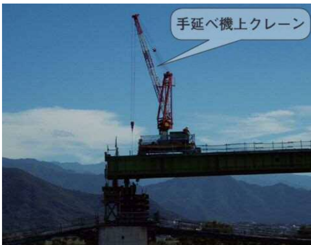
写真一9 手延べ機上クレーン作業状況
