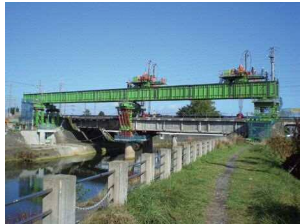
写真-18 撤去状況
