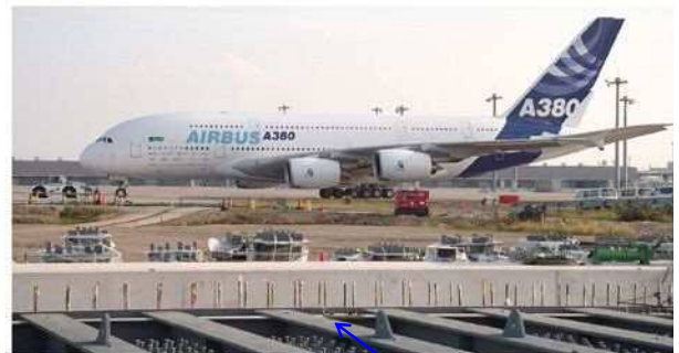
(A380:活荷重LA-0の航空機) 羽田誘導路橋梁
