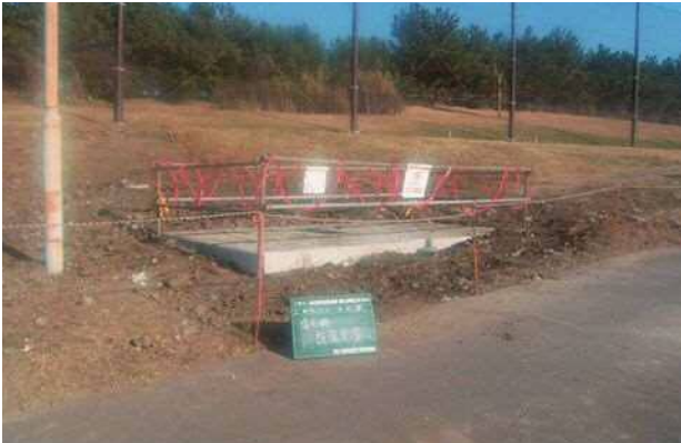
写真-6 陸上アンカー
