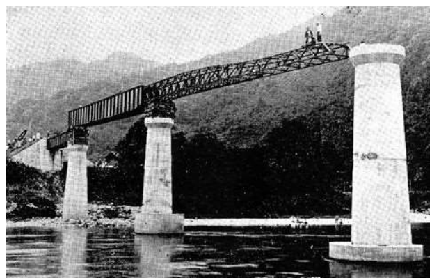
写真一8 ガーダーの手延べ式架設 （三江線・江川橋梁、昭和12年）
