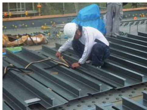
写真-2 シールスポンジ取付状況
