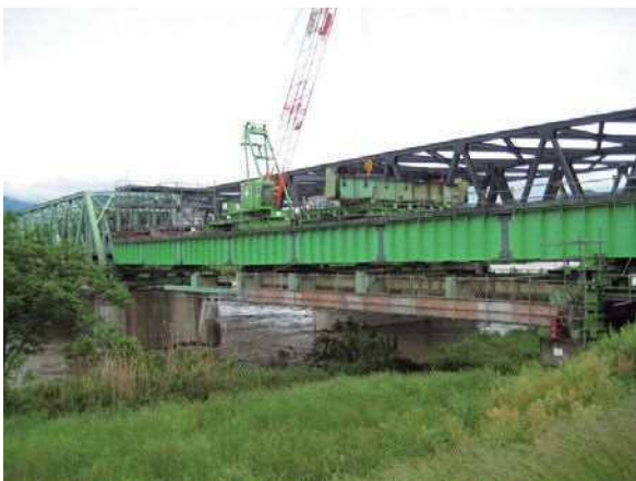
写真-15 撤去状況
