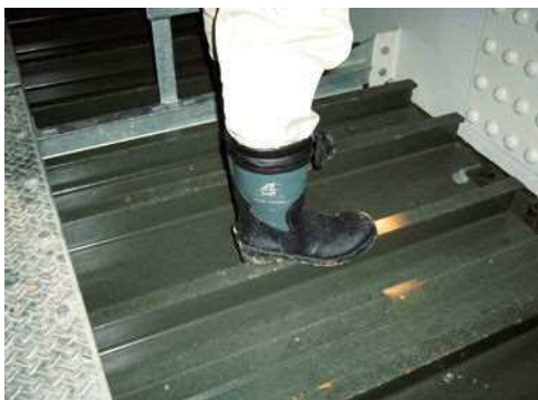
写真-7 点検状況イメージ2
