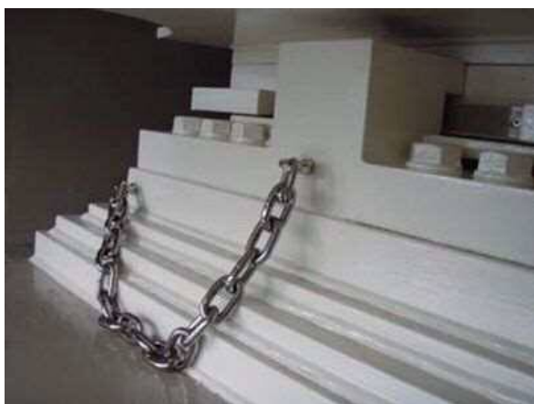
写真-24 ゴム支承設置状況
