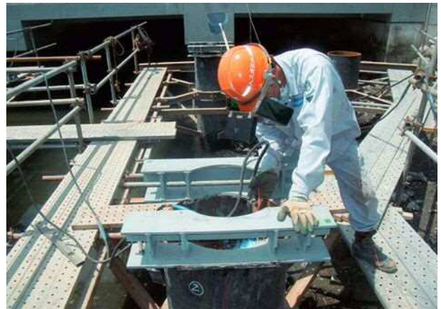
写真-3 受梁設置状況
