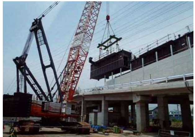
写真-3 高架橋上桁組み立て状況
