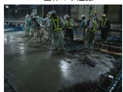
コンクリート打設
