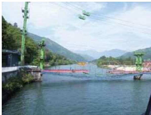
写真四 撤去状況
