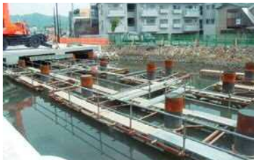
写真-1 足場設置状況
