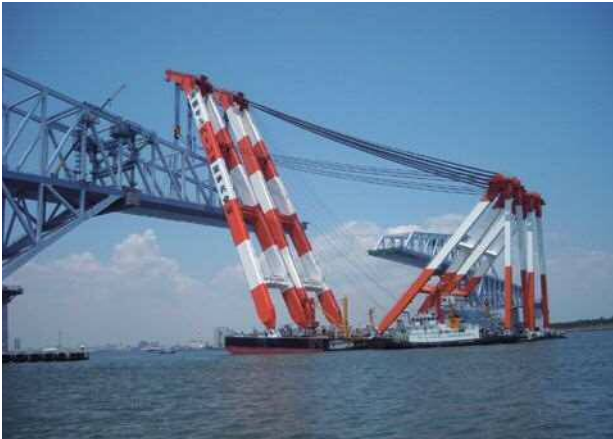
写真一4 中央径間トラス架設状況（中防側）
