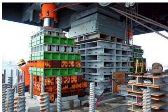
写真-3 高さ調整設備
