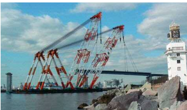
写真一12 架設状況写真
