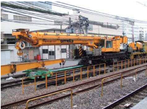
写真-10 現在の新型操重車 （インターネットより）
