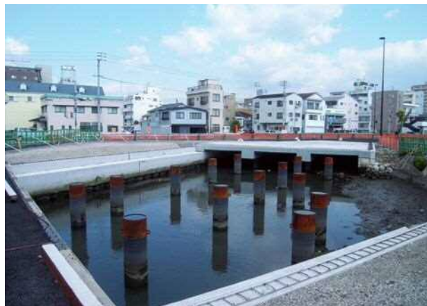
写真-9 施工前状況
