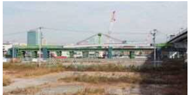
写真-1 送出し時全景
