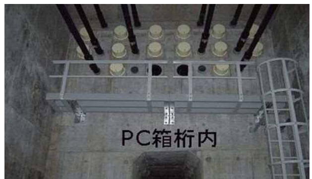
写真-3 既設PC箱桁内にFRP検査路を追加設置した事例
