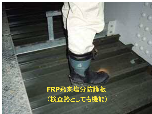
写真-5 FRP飛来塩分防護板の施工事例
