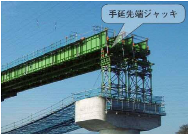
写真-5 手延べ機受けベント
