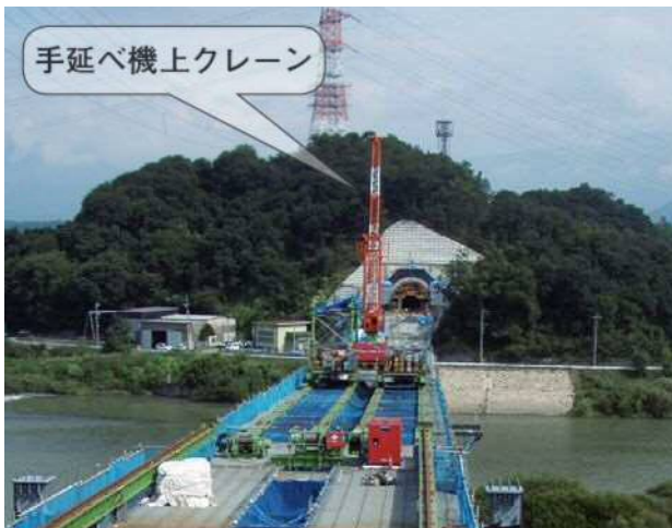
写真一8 手延べ機上クレーン設置状況
