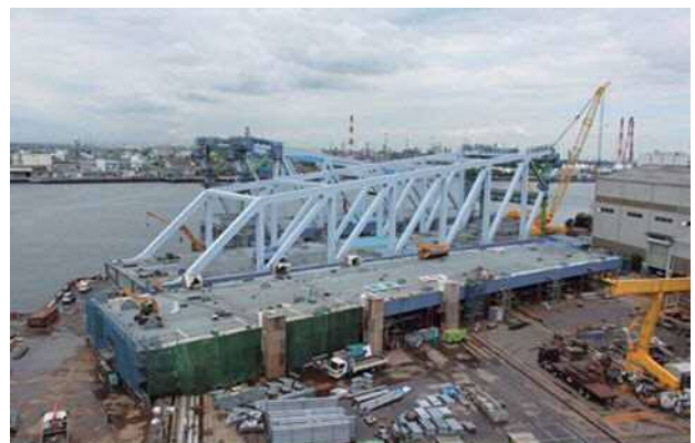
写真-1 千葉工場に接岸する中央径間部材
