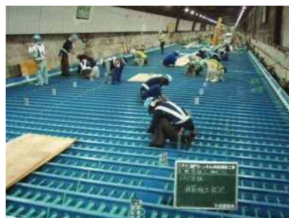
下側鉄筋組立
