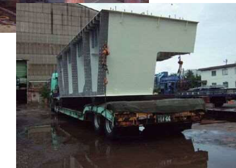
写真-12 取替桁製作・運搬状況
