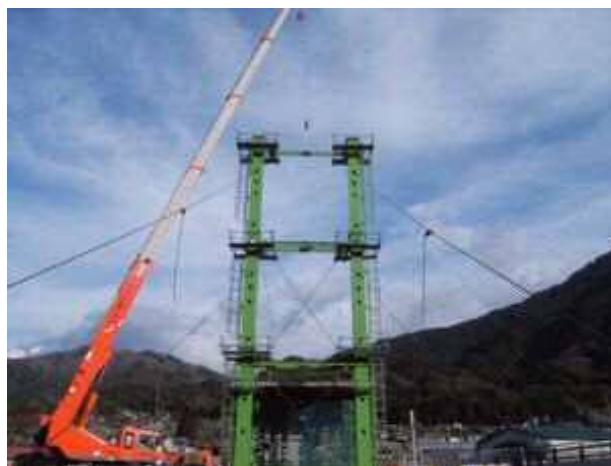
写真二 鉄塔組立状況
