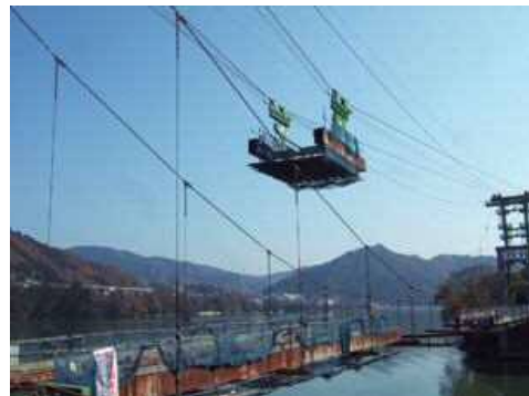
写真-6 撤去状況
