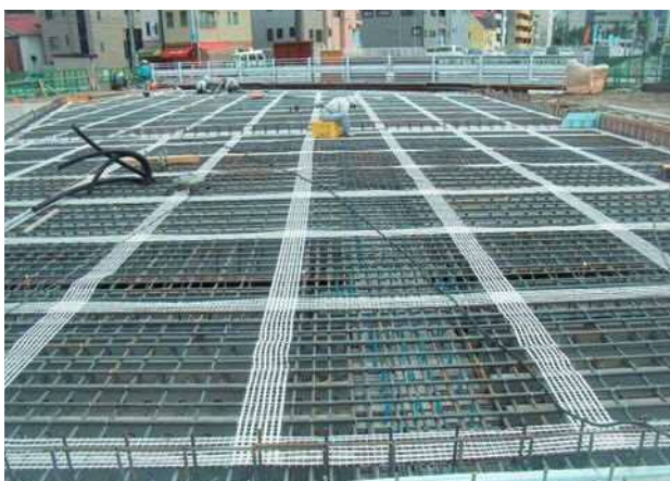
写真-7 ひび割れ抑制ネット敷設状況
