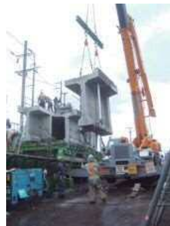
写真-20 切断・搬出
