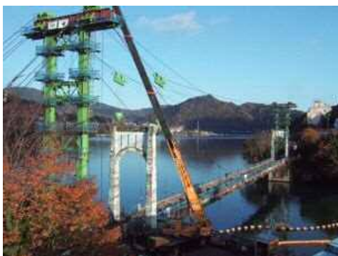
写真-7 撤去状況
