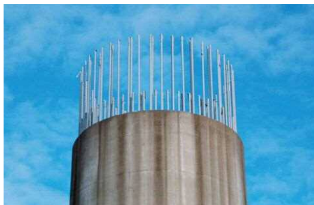
写真一2 柱頭部鉄筋（下部工施工範囲）
