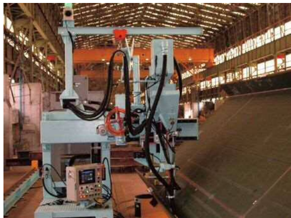
写真一5 溶接状況
