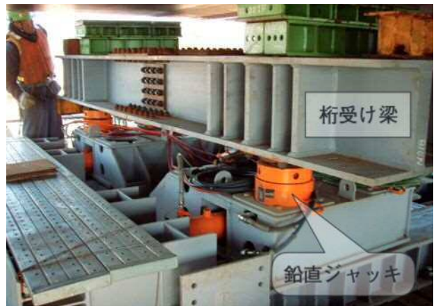
写真-6 橋脚上送り出し装置
