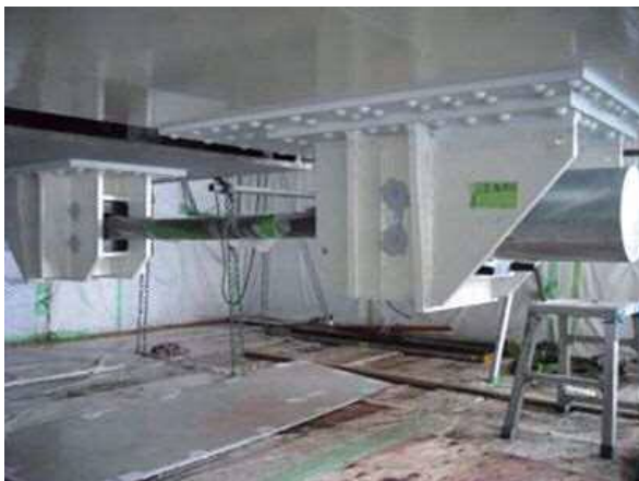
写真-23 落橋防止装置設置状況
