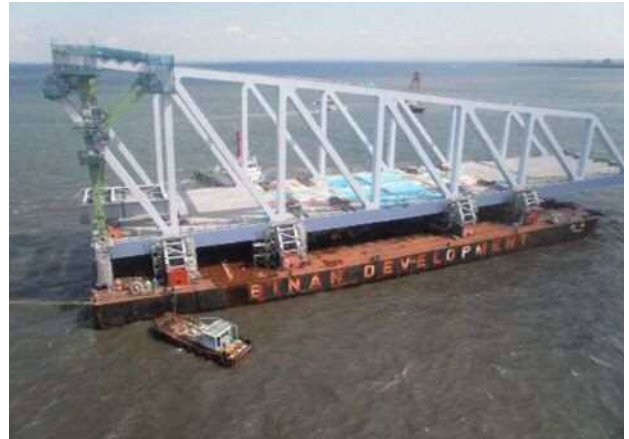
写真-3 作業区域へ入域する中央径間トラス（中防側）
