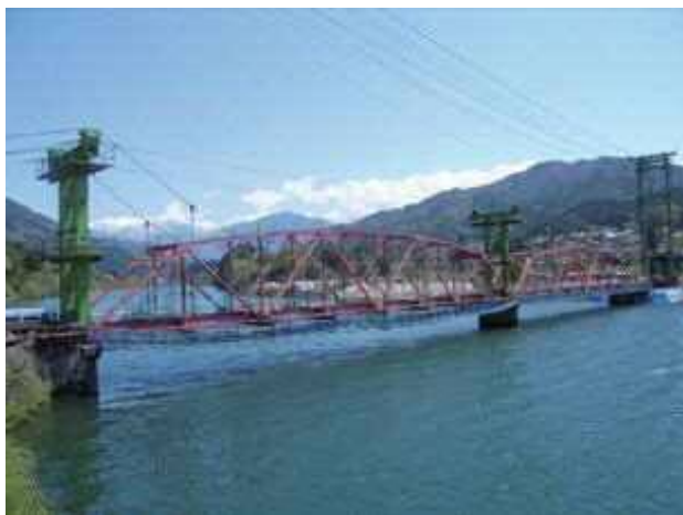
写真三 撤去状況
