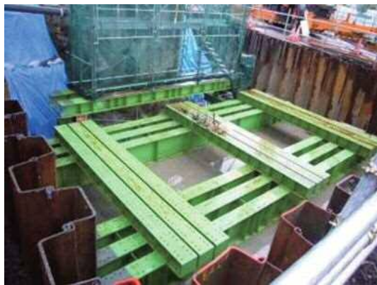
写真-7 ベント基礎設置状況
