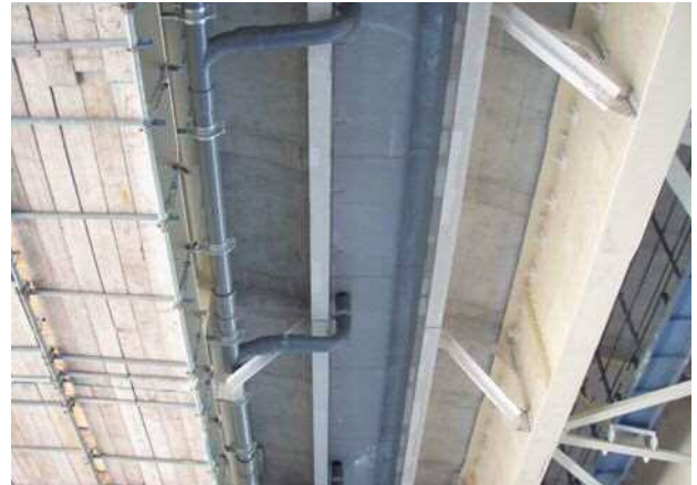
写真三 鋼鈹桁部中央分離帯側のFRP型枠
