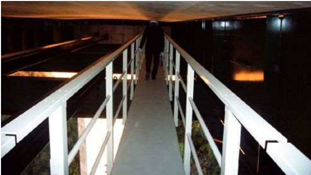
写真-1 (仮称) 駒瀬川橋FRP製検査路
