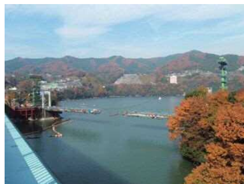
写真-8 撤去状況
