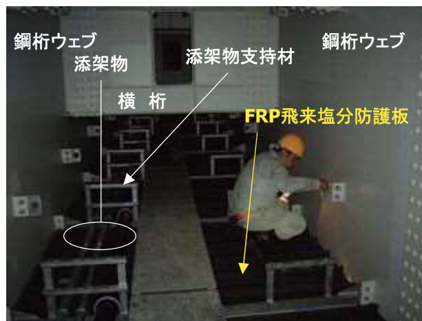
写真-4 飛来塩分防護板の施工事例
