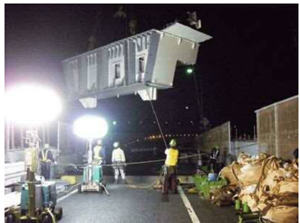
写真-18 新設桁設置状況
