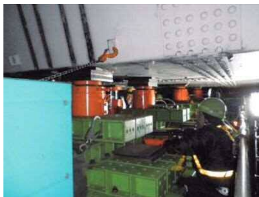
写真-9 ジャッキアップ状況
