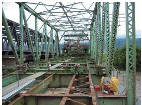
写真-16 撤去状況
