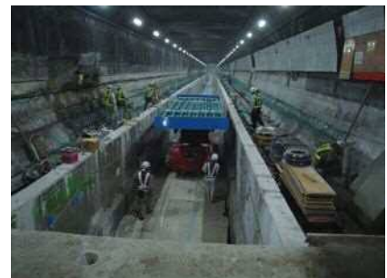
FRP 型枠の小運搬
