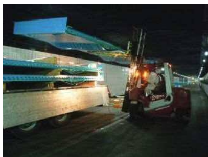
FRP 型枠の荷下ろし
