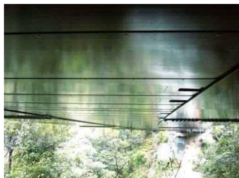
写真-5 FRP防護板敷設完了状況（桁下より）
