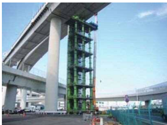
写真-8 ベント設置状況
