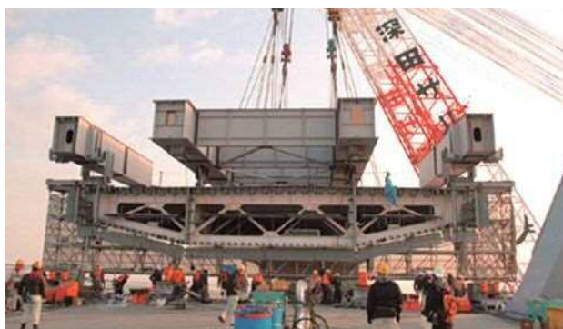
写真一八 中央径間箱桁の架設
