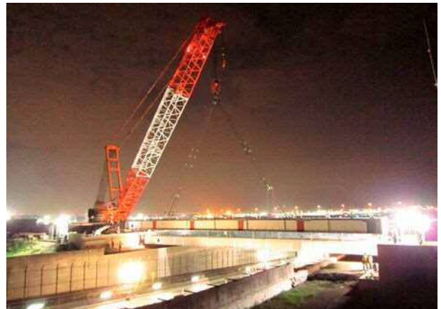
写真-8 一括架設中
