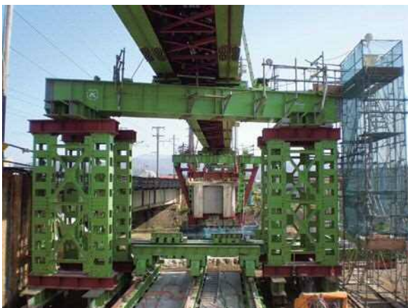
写真-19 撤去状況
