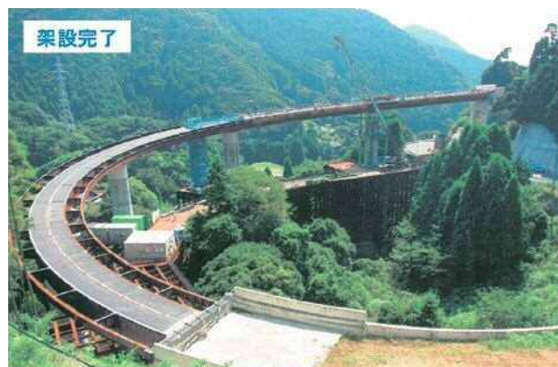
写真-1 現地架設完了状況
