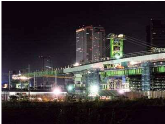
写真-5 送出し状況
