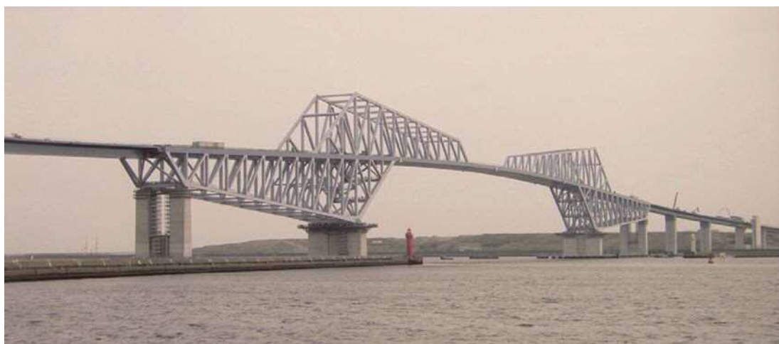
写真-12 東京ゲートブリッジ全景
