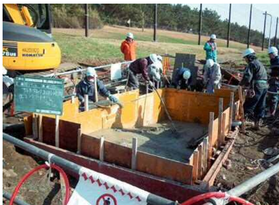
写真-5 陸上アンカー施工状況
