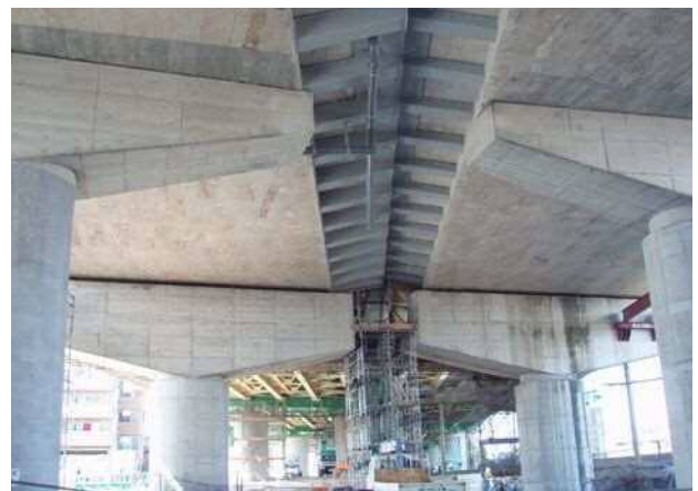
写真四 RC中空床版部中央分離帯側のFRP型枠
