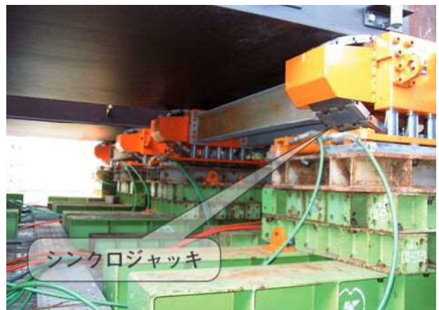
写真-7 高架橋上送り出し設備
