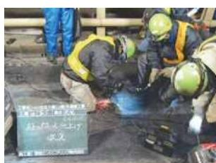
写真-7 ストップホールの施工
