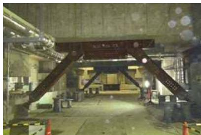
写真-2 鉄骨ブレース
