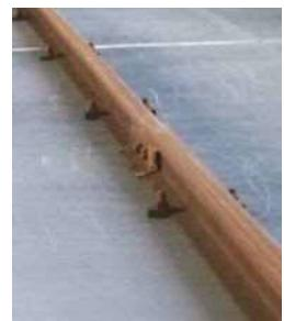
図-14 軌条設備固定用アンカー
