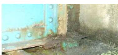
図-2 桁端の損傷事例<sup>1)</sup>
