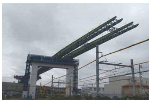
写真-3 下り線桁送出し完了
