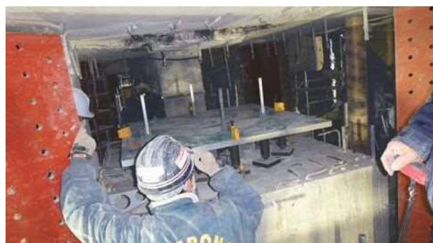
写真-12 下部ベースプレート設置、調整
