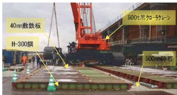
写真-1 走行路および架設補強
