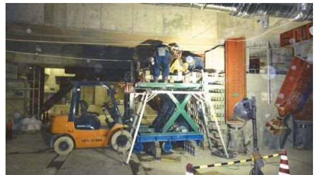
写真-9 切断ブロック引き出し
