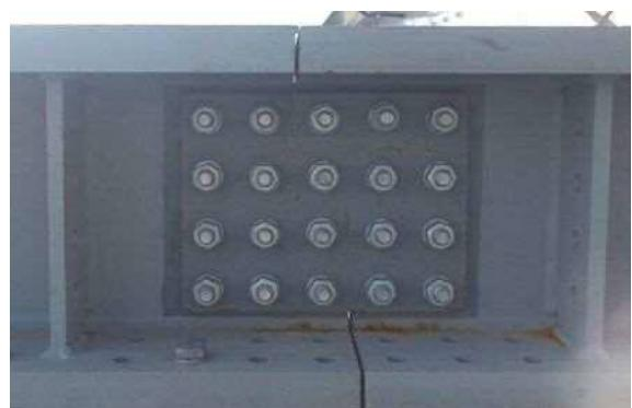
写真一2 軌条梁の継手構造
