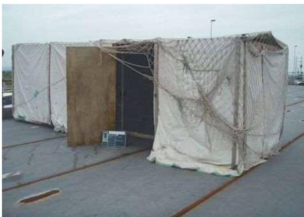
写真-7 溶接風防設備
