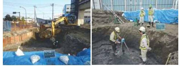
図-26 基礎掘削と地盤確認
