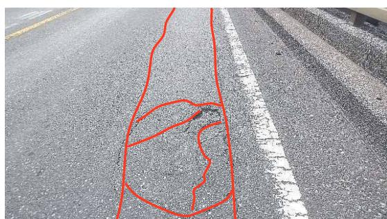
写真-5 舗装のき裂
