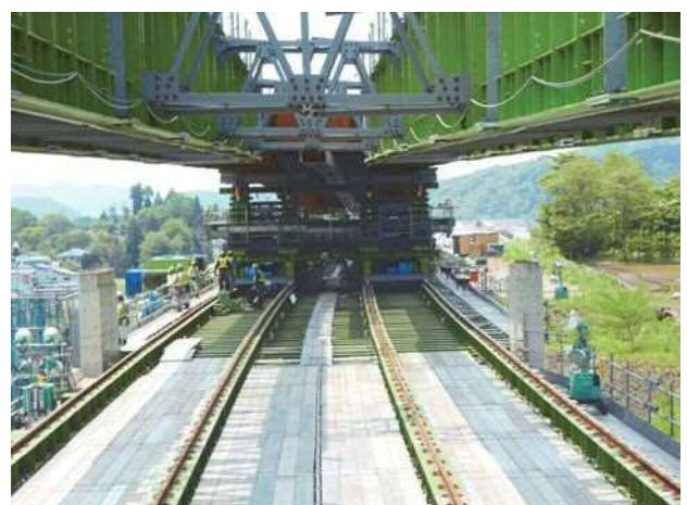
写真-2 曲線形状の軌条設備
