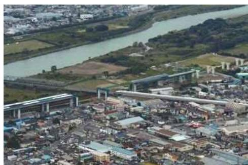
写真-2 第1回桁送出し完了
