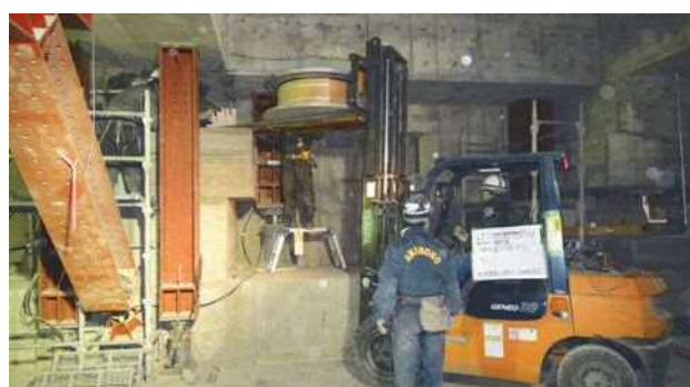
写真-13 免震装置設置
