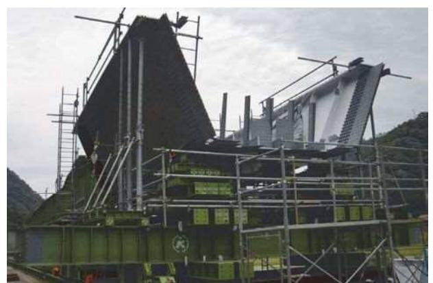
写真-7 送出しヤードでの主桁組立
