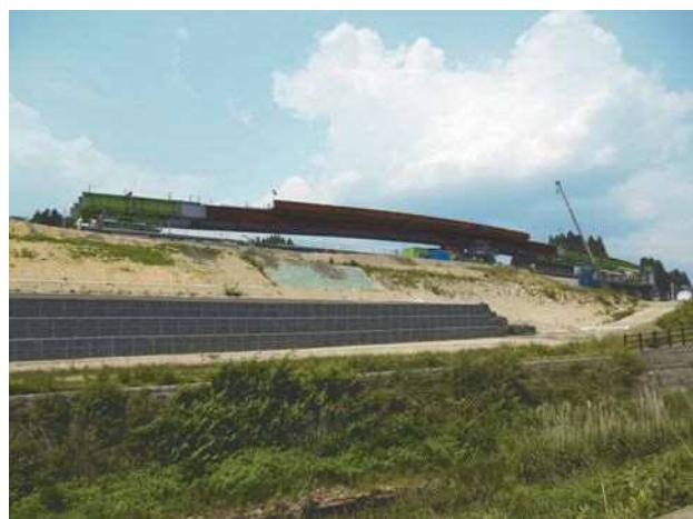
写真-1 送出し桁全景
