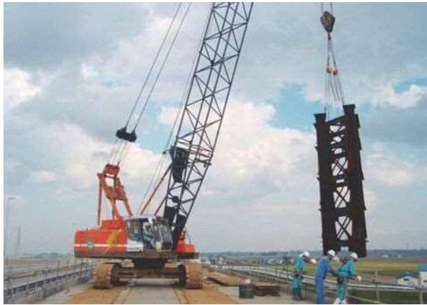
杭基礎の撤去は設置したときと同じ能力のバイブロハンマーによる引き抜き作業を試みたが、引き抜くことができず、能力の大きなバイブロハンマーを採用することとなった。おそらく最も時間の経過したもので設置から1年以上が経過しており、杭周りの地盤の締固まりで付着力が増加したためと予想される。そのため、過負荷により安全装置が作動し、バイブロハンマーの停止により撤去作業の効率が低減し、また周囲の地盤振動が大きくなり、周辺環境の悪化が懸念された。
