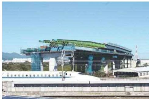
写真-1 下り線桁送出し前
