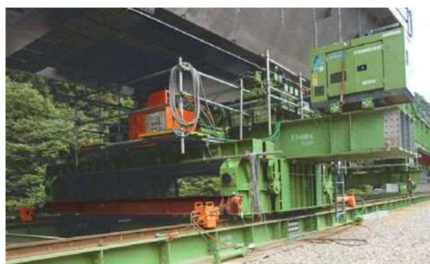
写真-6 推進台車設備
