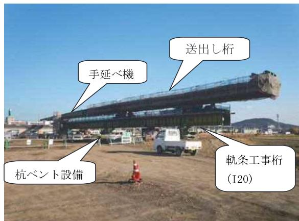
写真一2 軌条工事桁及び杭ベント設備
