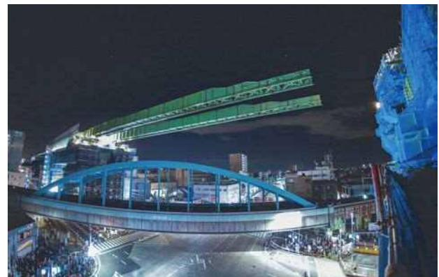
写真-1 第1回主桁送出し状況
