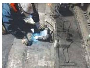
写真-6 き裂先端確認
