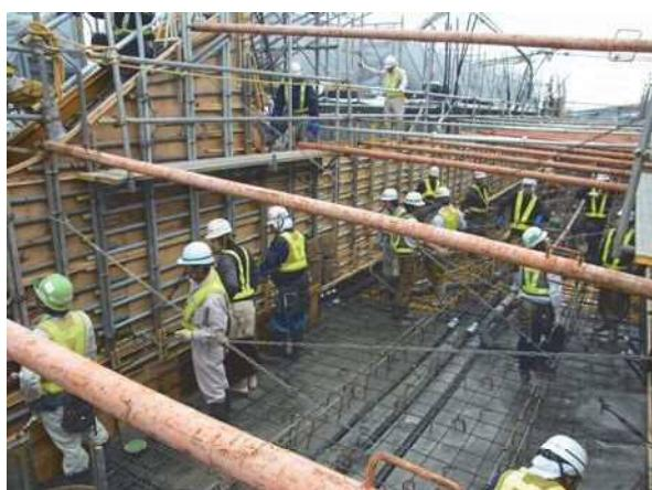
写真-7 補剛桁コンクリート打設状況
