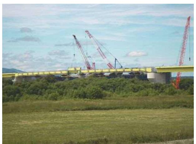
写真-4 補剛桁架設状況
