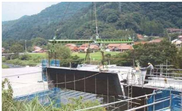
写真-12 主桁クレーン架設
