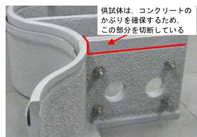
写真-1 FRP伸縮の継手構造
