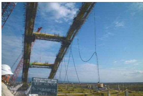
写真-6 ケーブル架設状況
