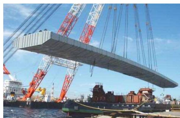
写真-3 大ブロックの積み込み状況
