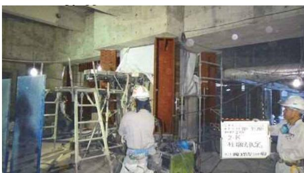
写真-7 柱切断（無水ワイヤーソー）
