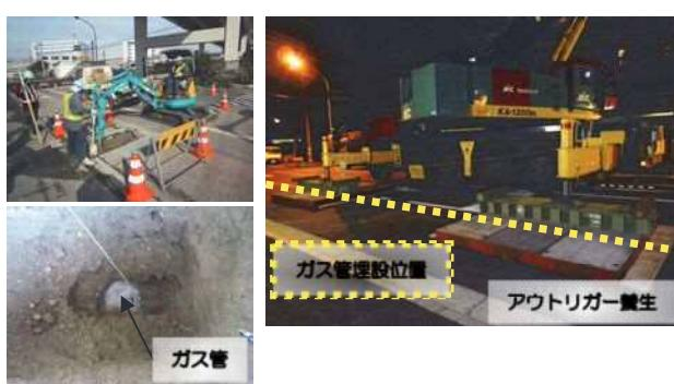
図-17 ガス管試掘・アウトリガーナンバーニング
