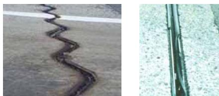
図-1 伸縮装置の損傷事例<sup>1)</sup>
