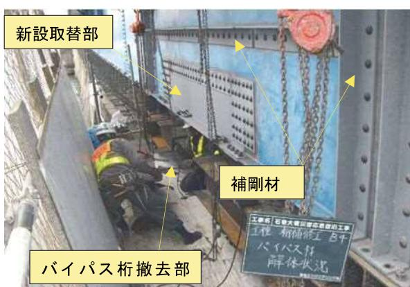
写真-12 バイパス桁撤去状況①
