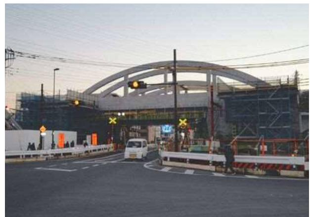
写真-9 ランガーガーダー製作完了
