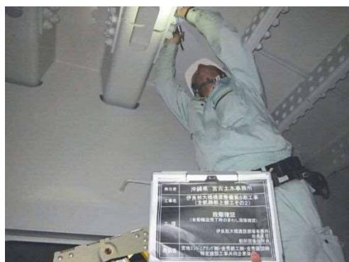
写真一五 塗膜割れの確認状況
