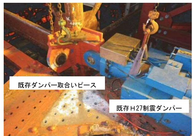
写真-13 既存制震ダンパー撤去状況
