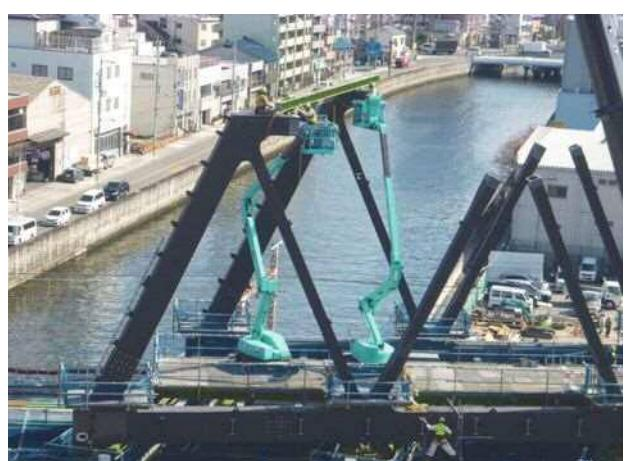
写真-4 橋台設備使用施工状況
