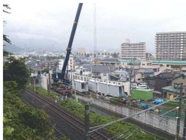
写真-4 桁地組状況
