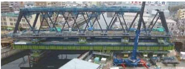
写真一7 後方トラス桁組立
