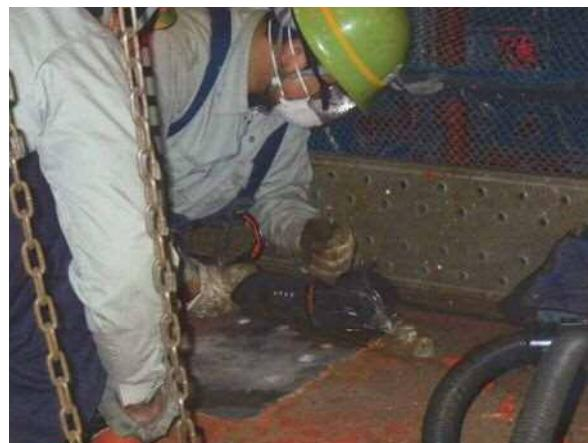
写真-15 摩擦面処理現場施工状況
