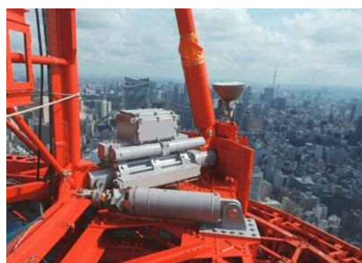
写真-5 H27制震ダンパー（更新後）
