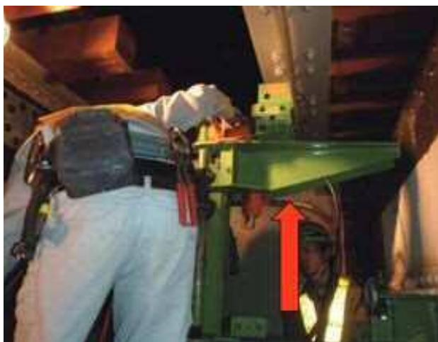
写真一二 新規T型フランジ吊上
