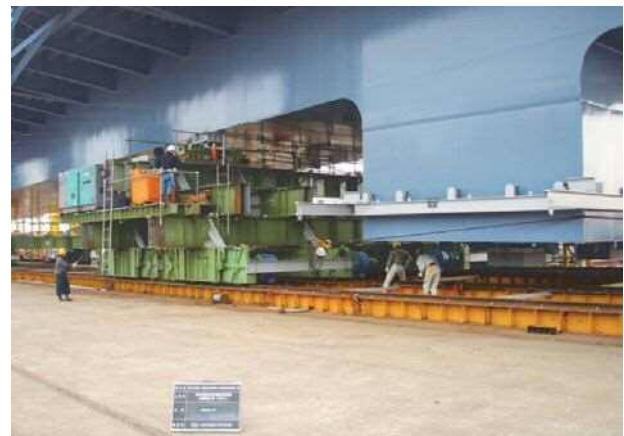
写真-1 自走台車による移動
