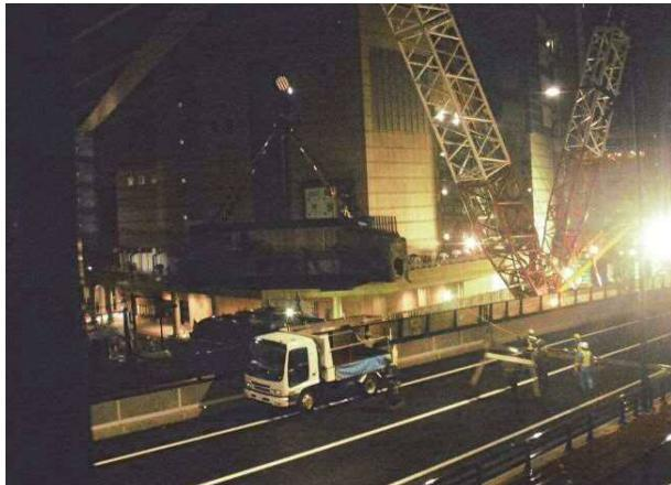
写真-7 市道上へ桁旋回
