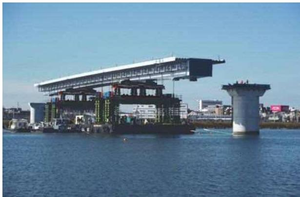
写真-14 桁吊り上げ完了
