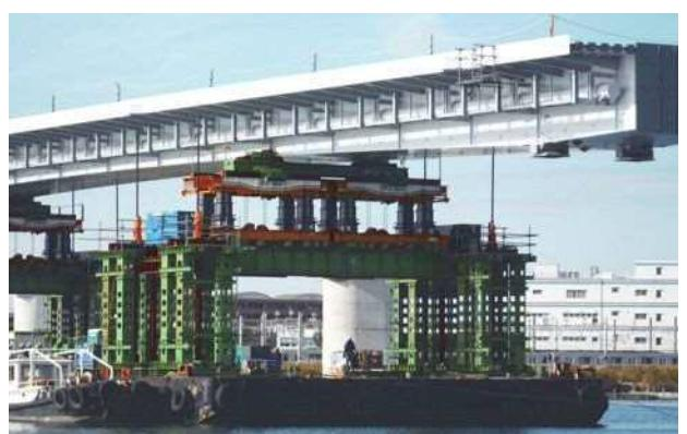
写真-12 桁吊上状況
