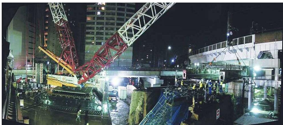
写真-4 桁地切り・巻き上げ
