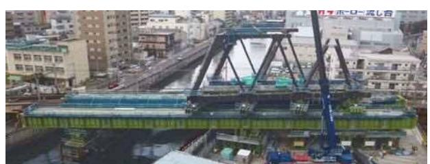
写真-5 前方トラス桁組立
