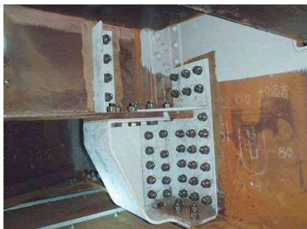
写真-1 床組接合部補強状況
