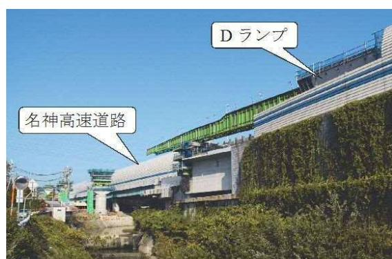
写真-3 Dランプの送り出し架設
