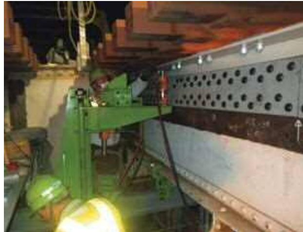
写真一四 新規T型フランジ設置完了
