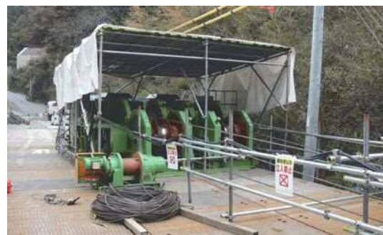
写真-8 ウィンチ設置状況
