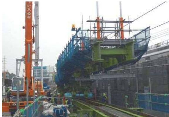
写真-3 吊上げ台車
