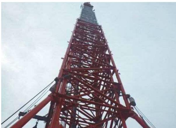
写真-10 SG塔補強フレーム
