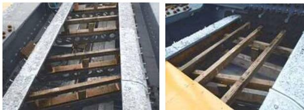
写真-12 PICフォーム・支保工施工状況
