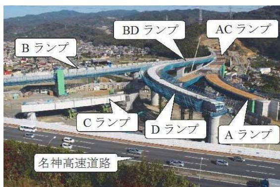
写真-1 各ランプ橋の架設状況
