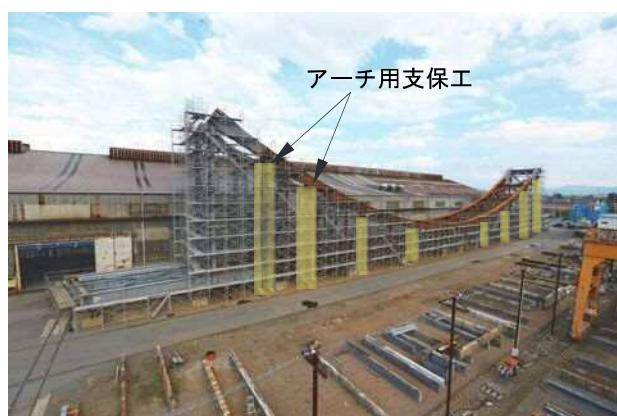
写真-4 倒立一体仮組立完了状況
