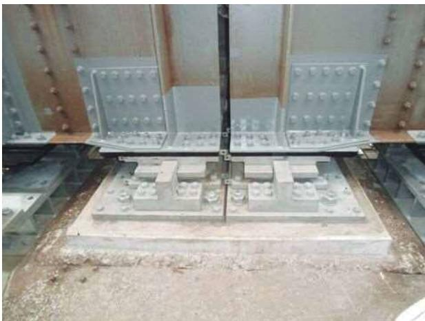
写真一2 支承部取替・補強状況
