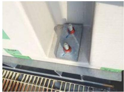
写真一9 FRP防風柵取付けボルト状況
