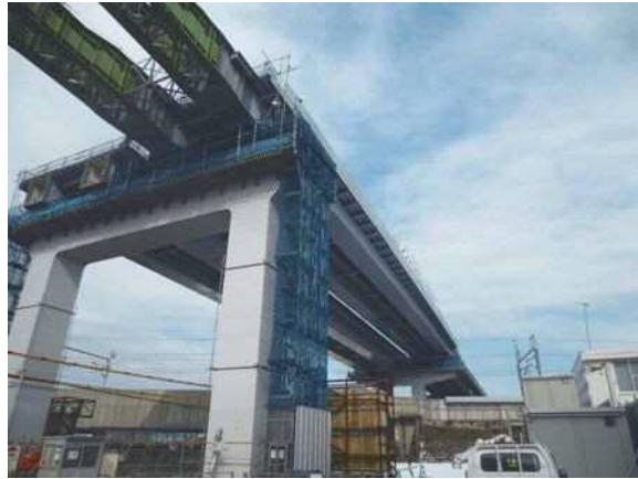
写真-8 上り線送り出し完了
