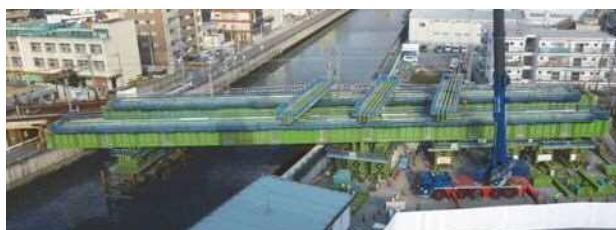
写真-2 送出し工事桁設備全量
