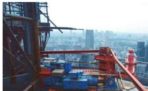
写真-4 H27制震ダンパー（更新前）
