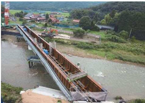
写真一4 桁架設完了
