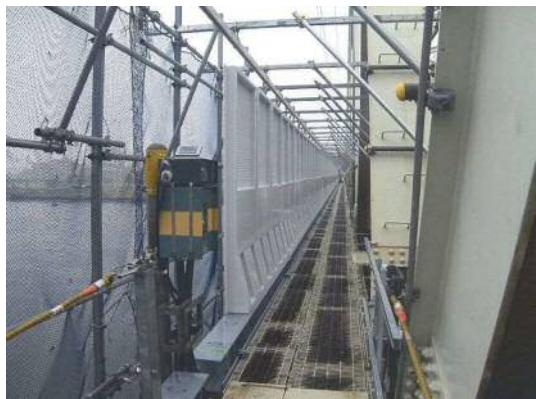
写真一6 FRP防風柵設置完了
