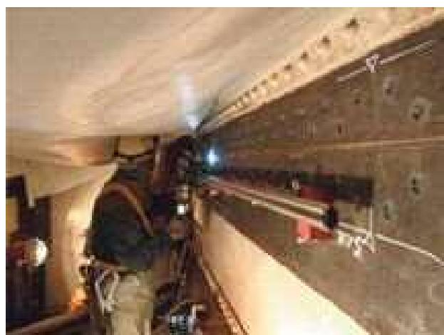
写真-6 腹板水平切断
