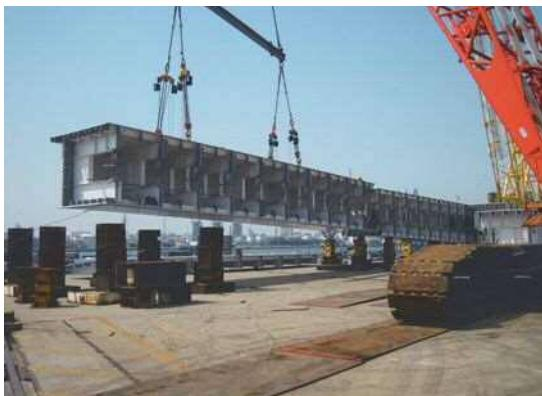
写真-3 箱桁の組立状況
