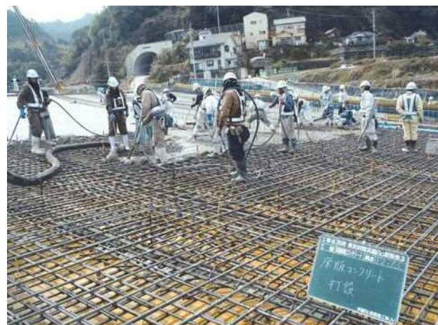
写真-7 床版コンクリート打設状況
