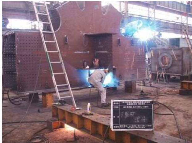
写真-7 部材溶接状況
