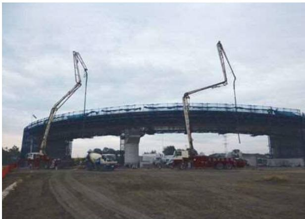
写真-7 床版コンクリート打設
