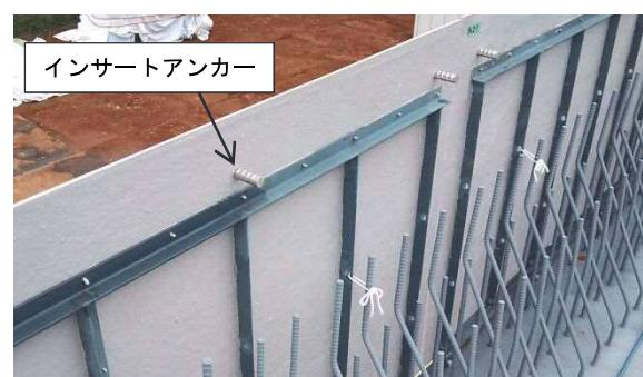
写真-3 インサートアンカー
