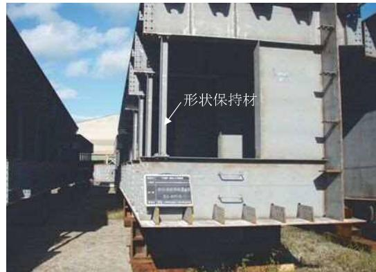
写真-2 形状保持材の設置状況
