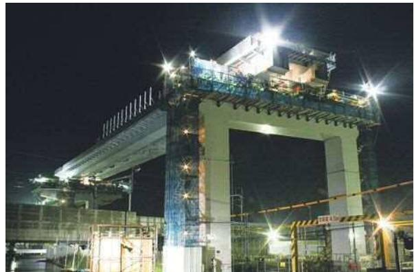
写真-6 下り線桁横取り状況
