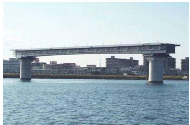
写真-16 桁据付け完了
