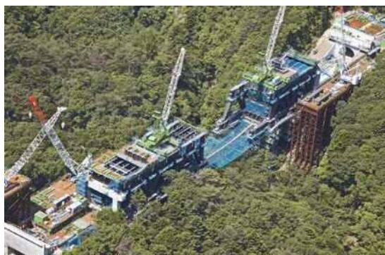
写真-13 トロベラクレーン張出し架設状況
