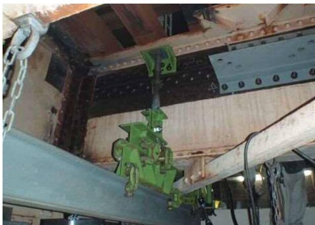
写真一15 既設上フランジ回転撤去設備
