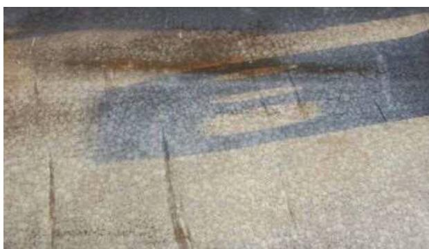
写真-3 溶融亜鉛めっき面の赤さび
