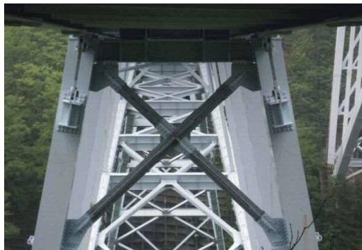
写真-5 座屈拘束装置施工完了
