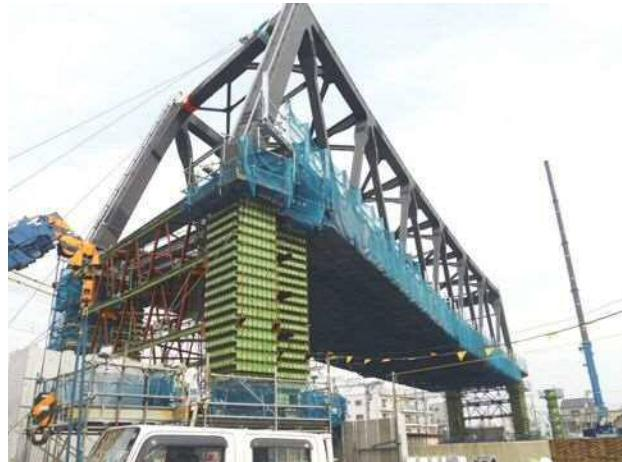
写真一9 ジャッキダウン設備全景
