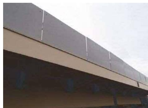
写真-5 FRP型枠外面
