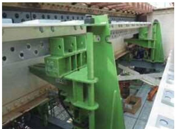
写真-8 上フランジ交換準備完了
