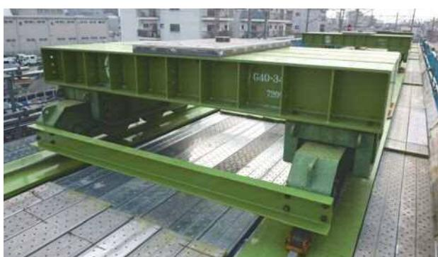
写真-3 従走台車上スライド設備（ステンレス板）
